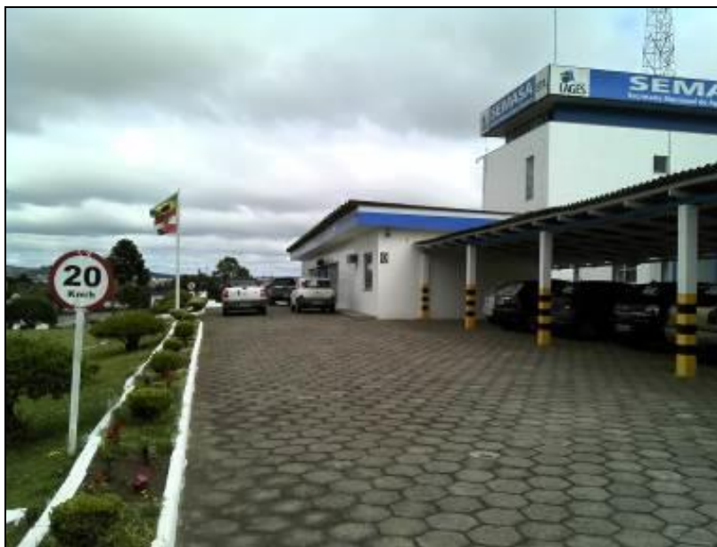
Figura 10: Fachada da ETA
