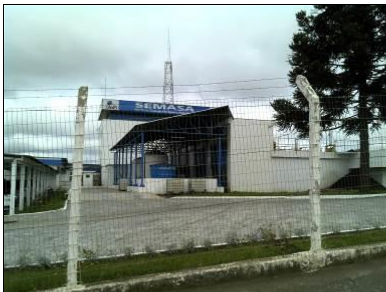
Figura 13: Cerca de proteção da ETA
