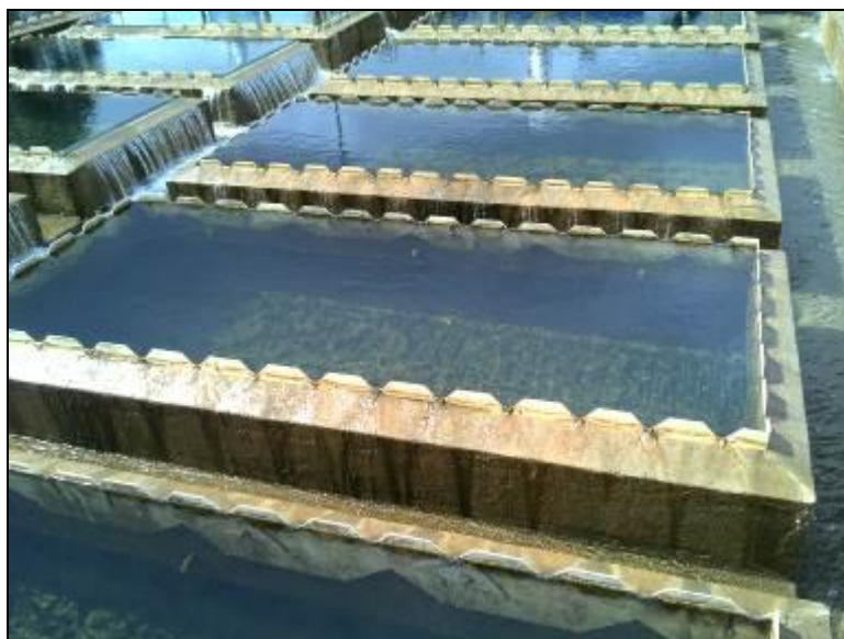
Figura 15: Decantadores da ETA
