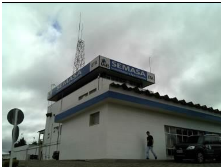
Figura 11: Acesso a ETA
