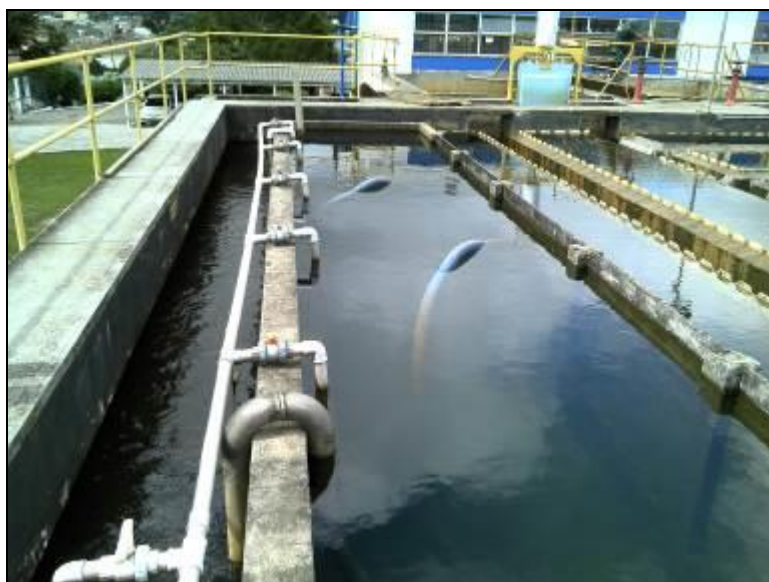
Figura 14: Guarda Corpo da ETA
