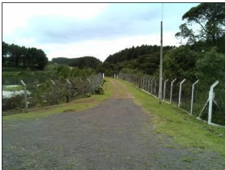
Figura 8: Acesso a Captação
