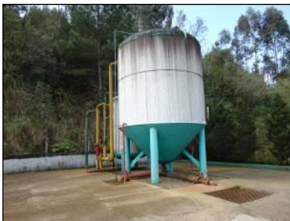
Figura 1: ETA com filtro (E) necessitando de manutenção
