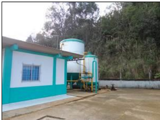
Figura 1: ETA com filtro (E) necessitando de manutenção
