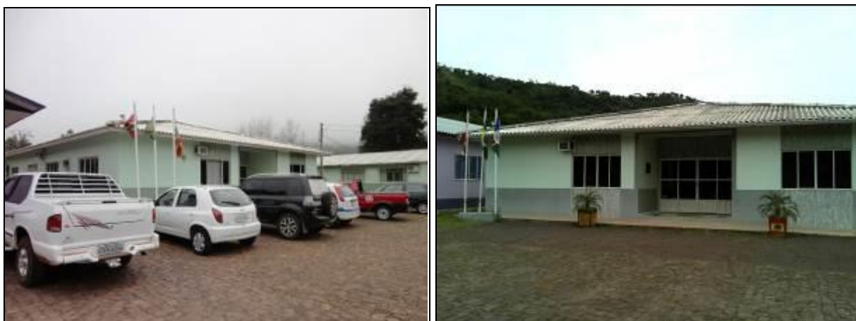
Figura 1: Fachada da Prefeitura (inicial e acompanhamento) Coordenada 26°39'20"S 53°26'20"O
