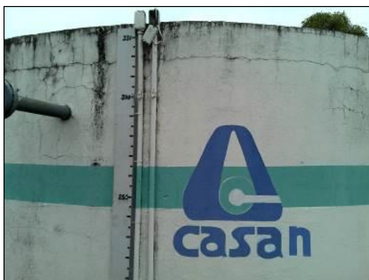
Figura 11: Régua e medidor de nível (acompanhamento)
