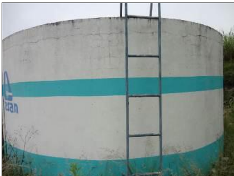
Figura 10: Escada de acesso
