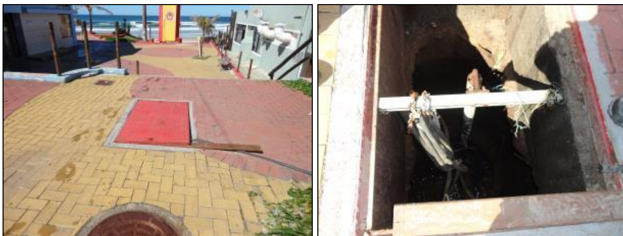
Figura 662- Vista externa e interna do poço úmido
