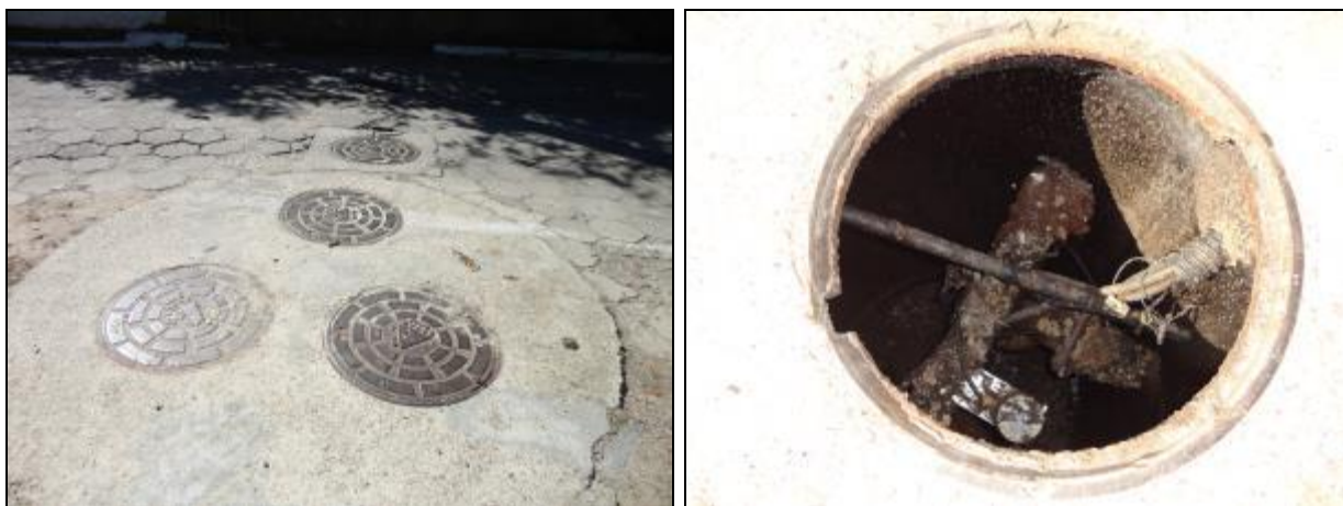
Figura 660- Vista externa e interna do poço úmido
