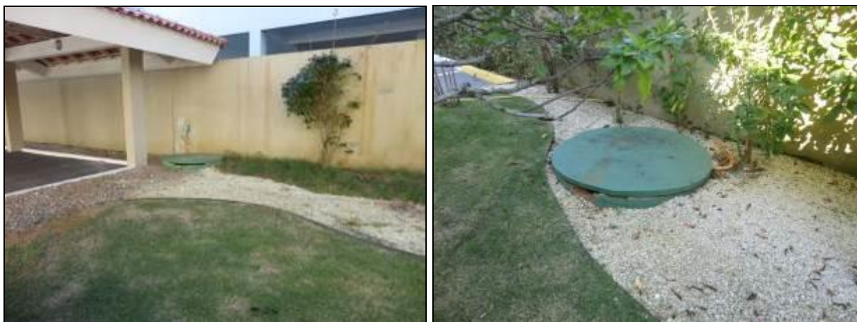
Figura 105 - Área do manancial cercada, porém não identificada (Acompanhamento)
