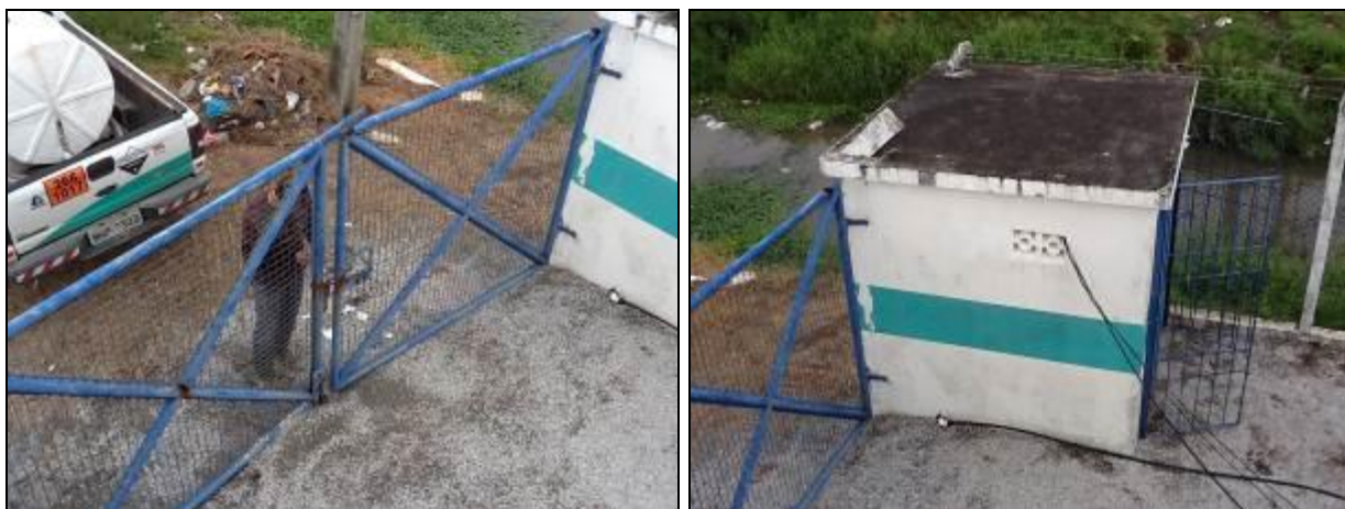
Figura 543 - Áreas frontais da ETE vistas de cima (Inicial)
