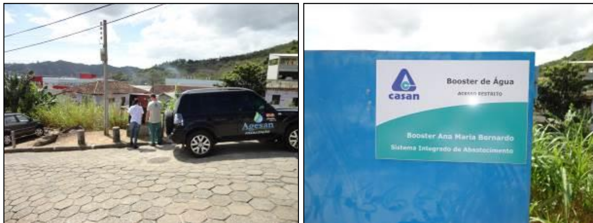
Figura 410- Vista geral do Booster com placa de identificação
