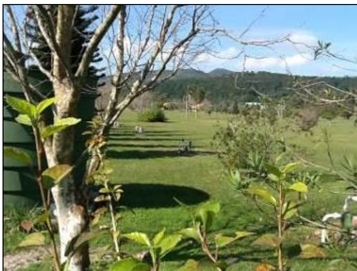
Figura 118 - Ponteiras onde é feita a captação (Inicial)
