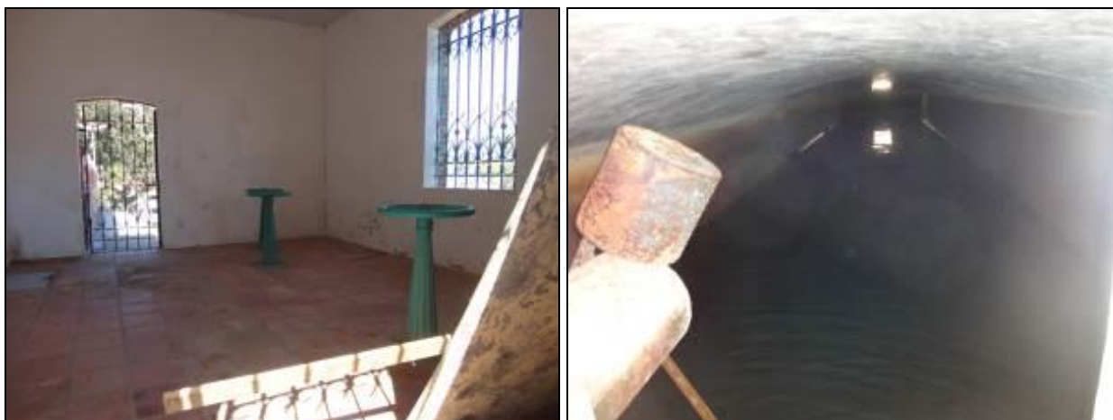
Figura 220 – R-0 – Centro – Imagens internas do reservatório (Acompanhamento)
