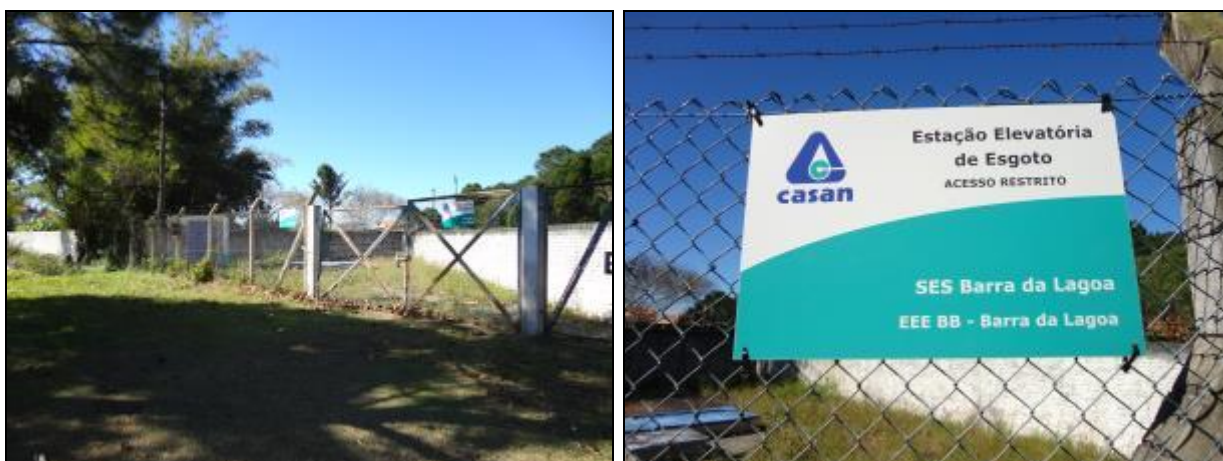
Figura 654- Vista geral da EEE BB Barra da Lagoa com placas de identificação e restrição
