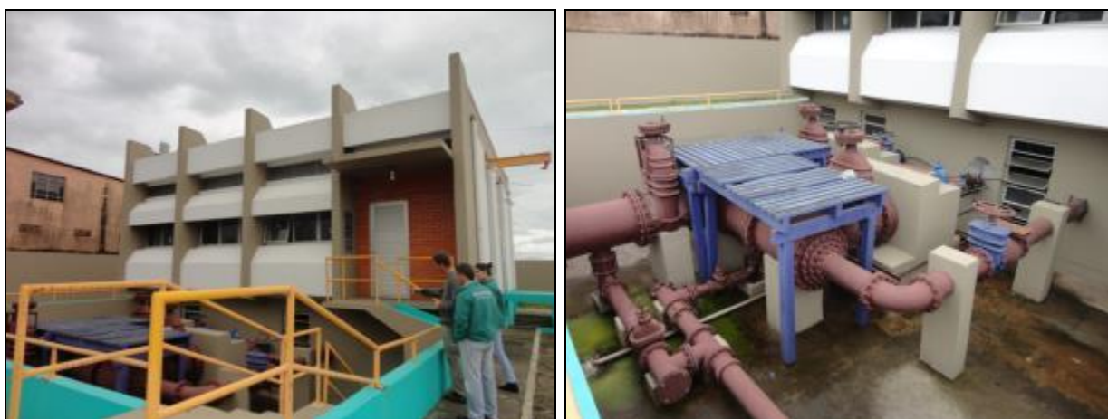
Figura 712- vista geral da estrutura da EEE
