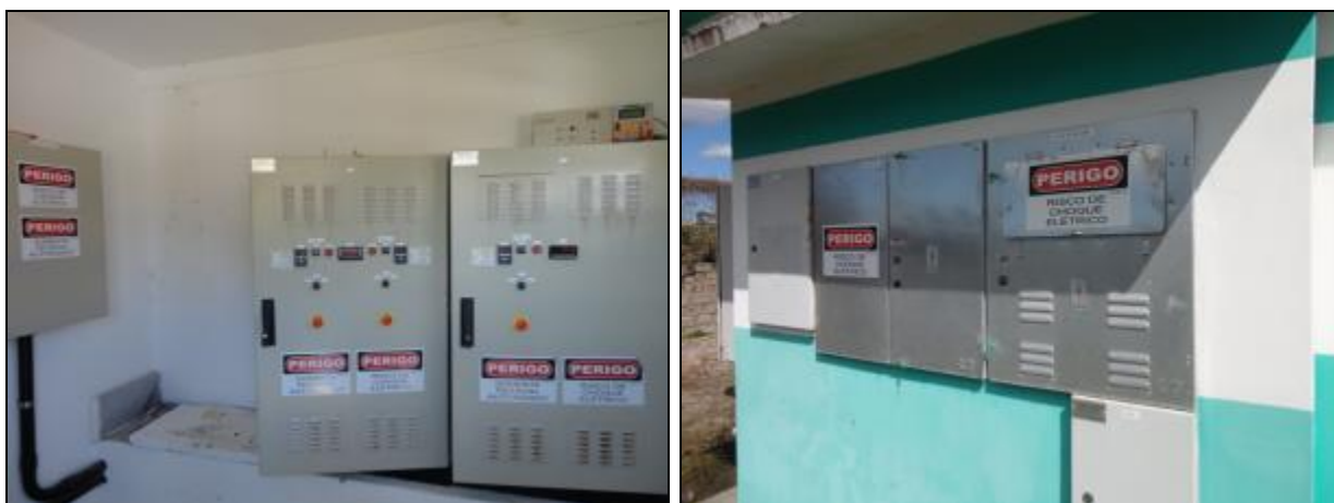
Figura 601- Quadros de comando e energia
