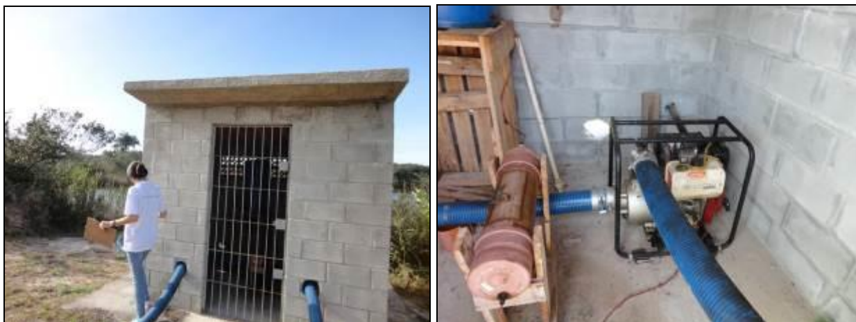
Figura 70 - Cada das máquinas onde é feito o recalque para a ETA (Acompanhamento)
