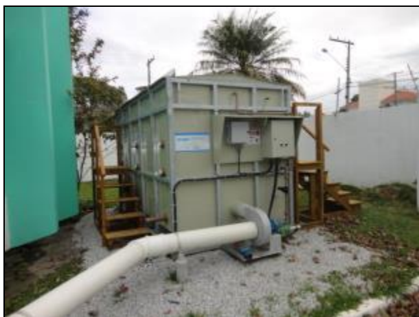
Figura 708- Nova instalação: Biofiltro (para eliminar odores)
