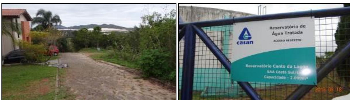
Figura 299- Acesso ao Reservatório Canto da Lagoa e placa de identificação (Acompanhamento)
