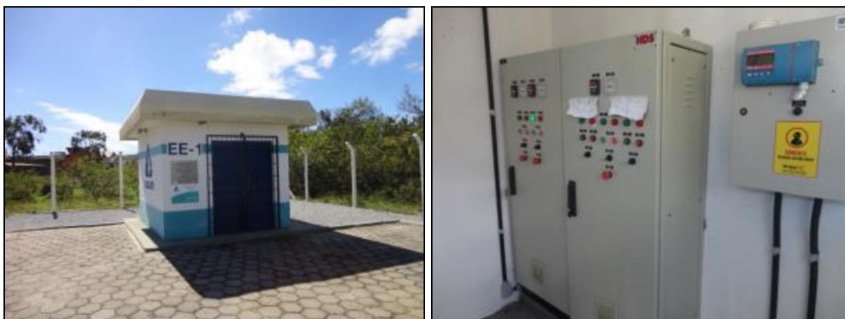
Figura 597- Vista externa e interna da casa de comando
