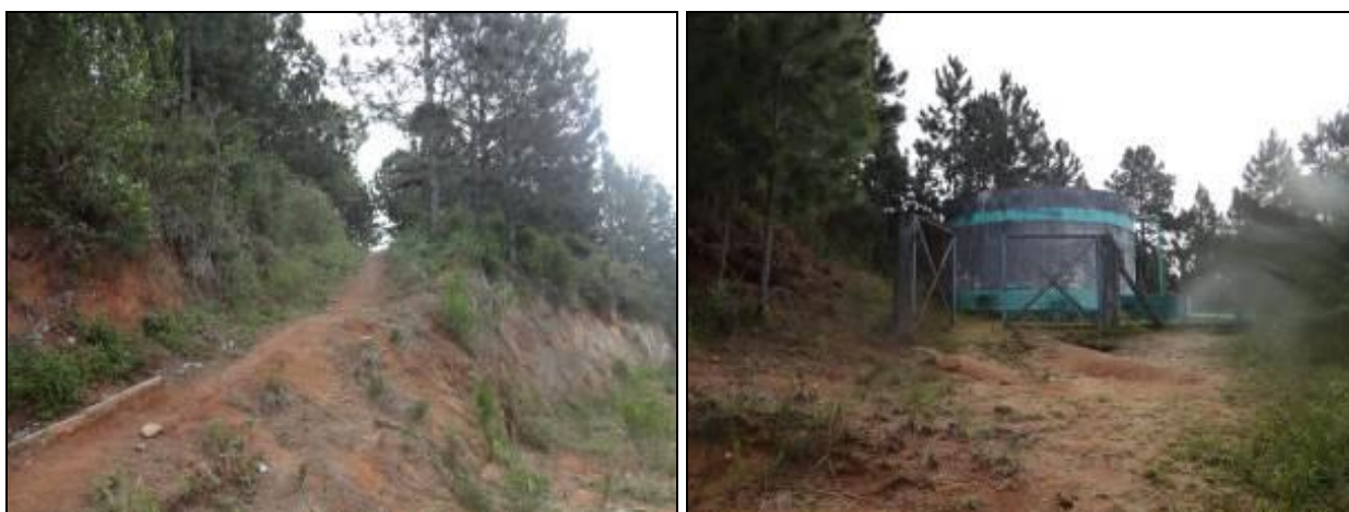
Figura 261 – Costa Azul – Itacorubi – Acesso ao reservatório e vista do portão de acesso (Acompanhamento)
