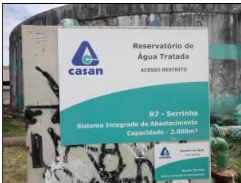
Figura 241 – R-07 – Serrinha – Acesso ao reservatório e placa de identificação (Acompanhamento)
