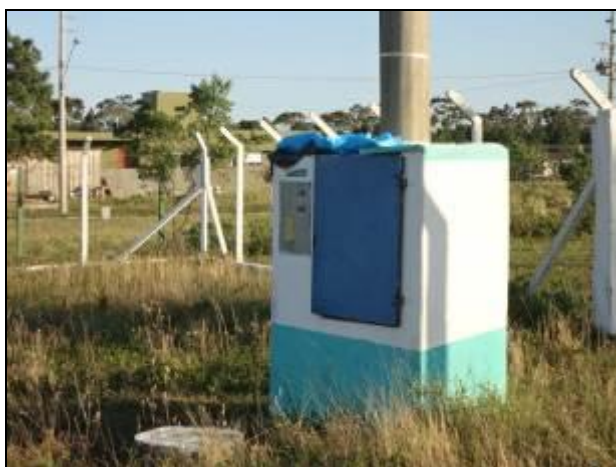
Figura 86 – Quadro de energia sem cadeado, vidro do relógio quebrado, sem identificação (Acompanhamento)
