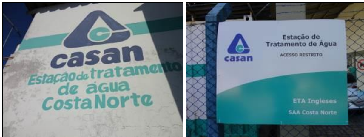
Figura 207 – Fachada da ETA (Acompanhamento)
