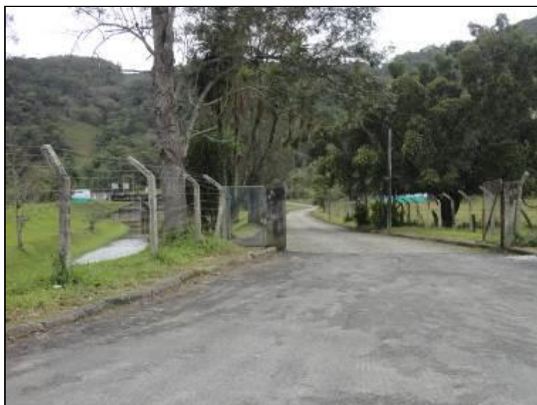
Figura 21 – Portão de acesso à área de captação sem placa de identificação (Acompanhamento)
