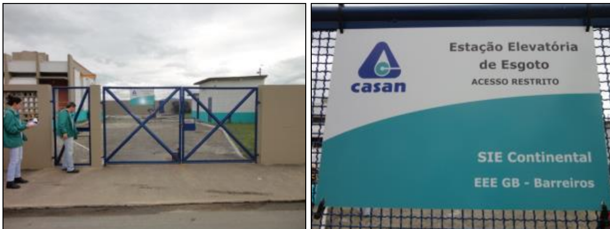
Figura 711- Portão de acesso à EEE GB Barreiros com placa de identificação e restrição de acesso
