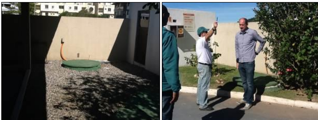
Figura 102 - Poços localizados dentro de Condomínio Residencial (Inicial)
