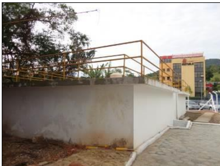
Figura 498 – Vista geral da ETE (Acompanhamento)
