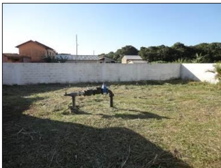
Figura 338- Vista da área do Poço Didi II
