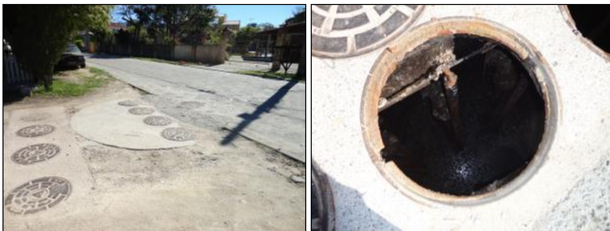
Figura 658- Vista externa e interna do poço úmido
