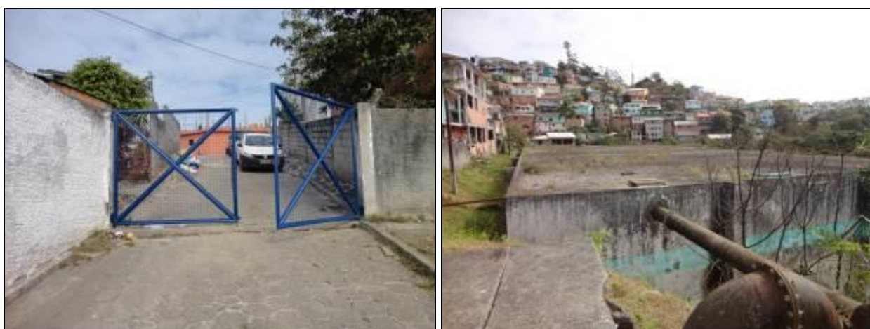
Figura 247 – R-09 – Serrinha – Portão de acesso ao reservatório (à esquerda) e vista superior do reservatório (à direita) (Acompanhamento)
