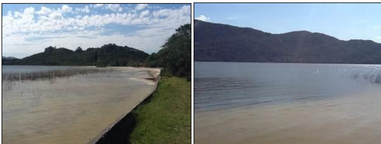
Figura 71 - Área do manancial onde é feita a captação (Inicial)
