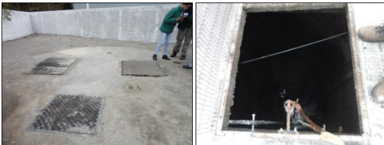
Figura 696- Vista externa e interna do poço úmido
