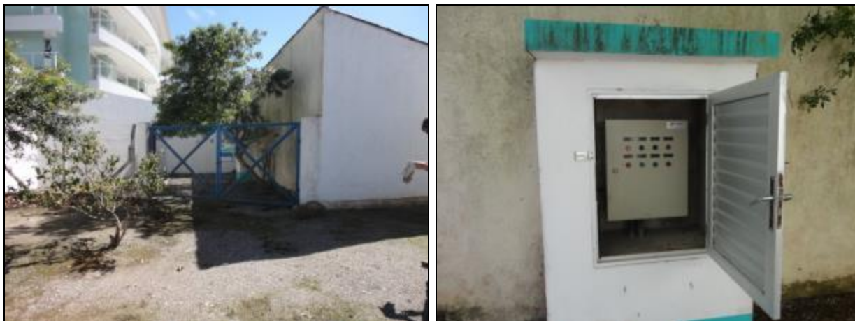
Figura 610- Vista geral da EEE OAB (à esquerda) e quadro de comando (à direita)
