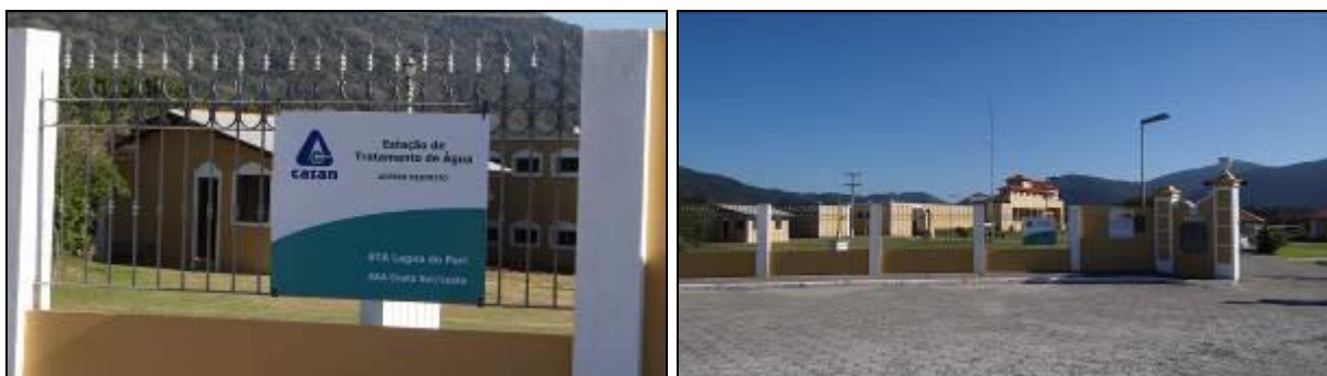
Figura 192 – Placa indicativa e portão de acesso à ETA (Acompanhamento)
