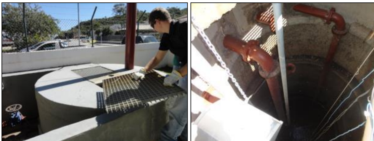
Figura 621- Vista exterior e interior do poço úmido
