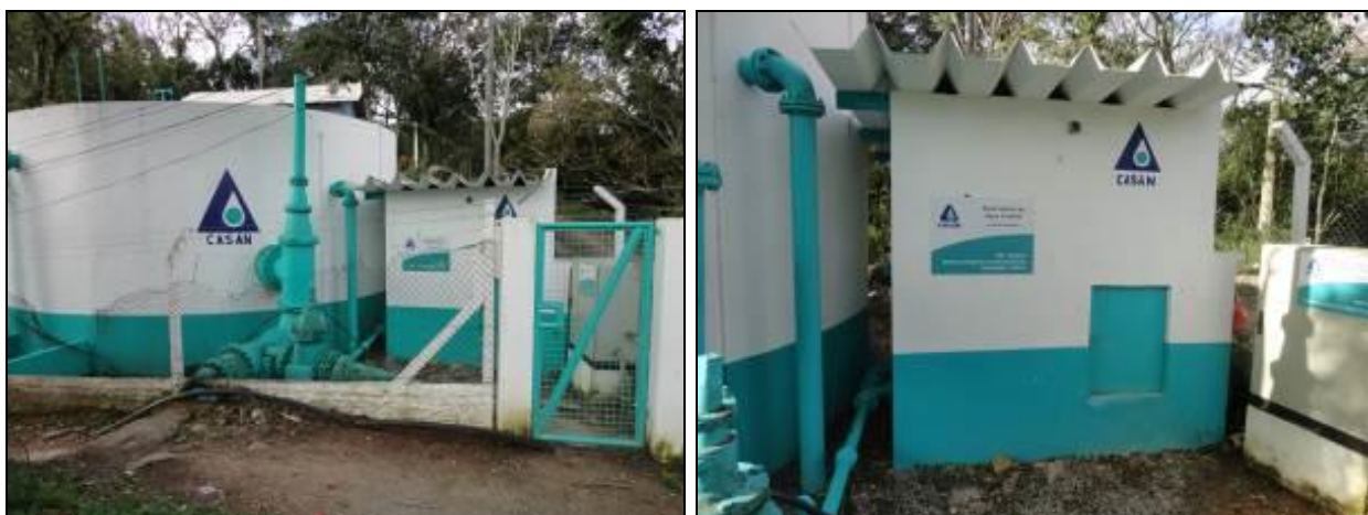
Figura 244 – R-08 Centro – Vista geral do reservatório e placa de identificação (Acompanhamento)
