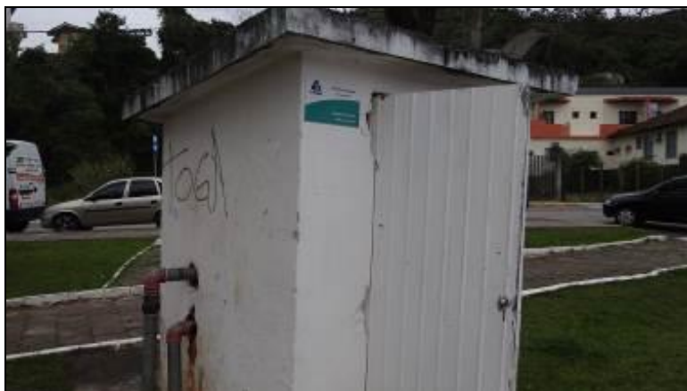
Figura 325- Vista externa da estrutura
