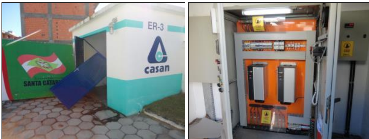
Figura 632- Vista externa e interna da casa de comando
