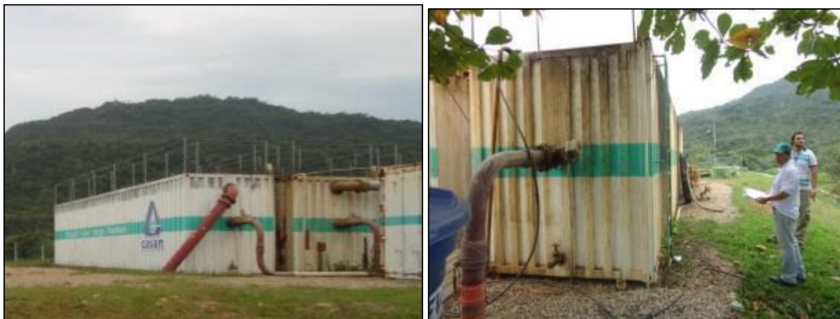
Figura 532 – Visão geral da ETE (Acompanhamento)
