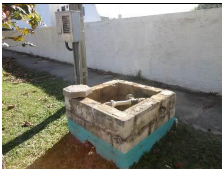
Figura 352- Poço 6 ativo somente no verão
