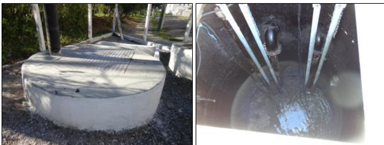
Figura 752- Vista externa e interna do poço úmido
