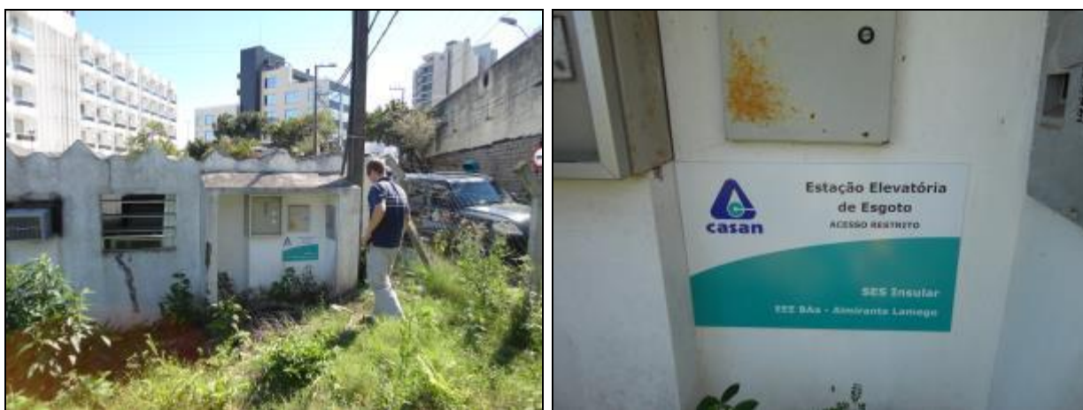
Figura 765- Vista da EEE BAa Almirante Lamego com placa de identificação e restrição de acesso
