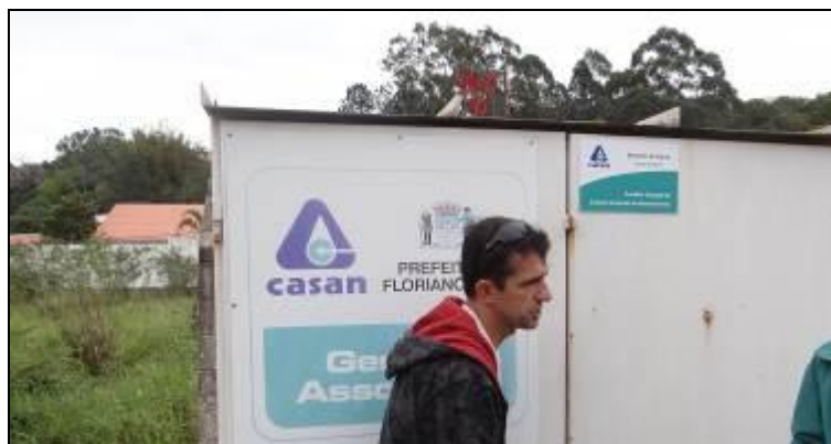
Figura 375- Vista geral do Booster Cacupé SC 401
