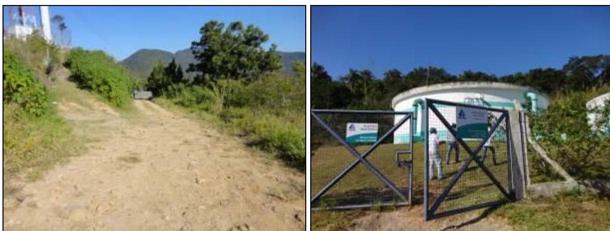
Figura 275 – Acesso ao Reservatório Ingleses e portão com placas de identificação (Acompanhamento)
