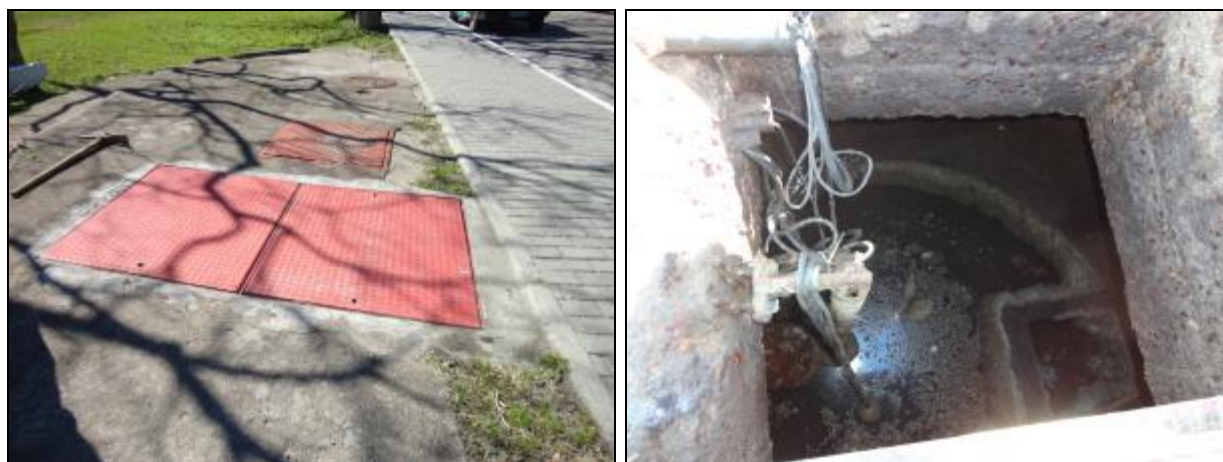
Figura 664- Vista externa e interna do poço úmido
