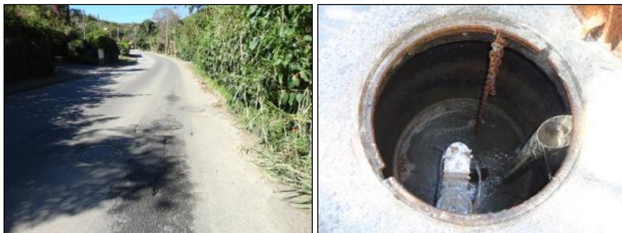
Figura 686- Vista externa e interna do poço úmido
