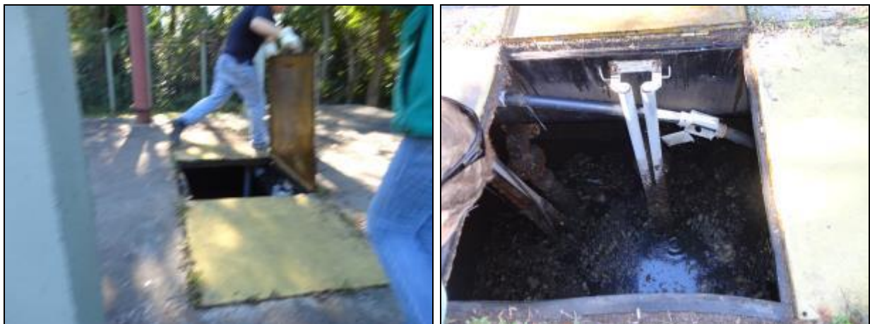
Figura 678- Vista externa e interna do poço úmido
