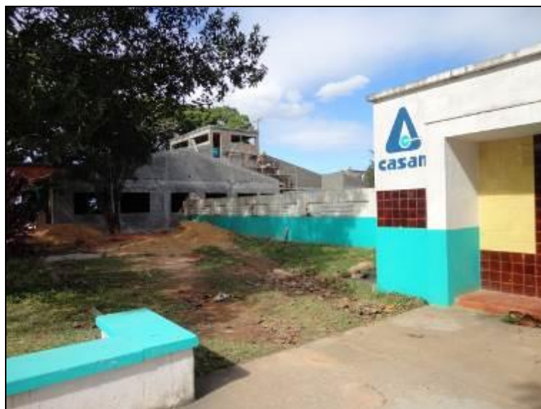
Figura 229 – R-02 – Ivo Silveira – Obras do posto de saúde no terreno no reservatório (Acompanhamento)
