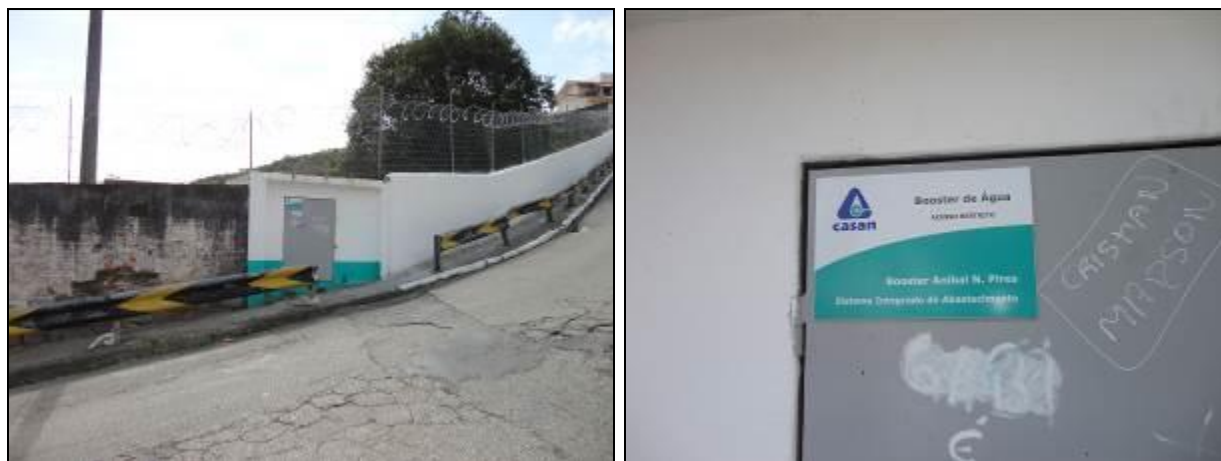
Figura 450- Vista da área do Booster e placa de identificação
