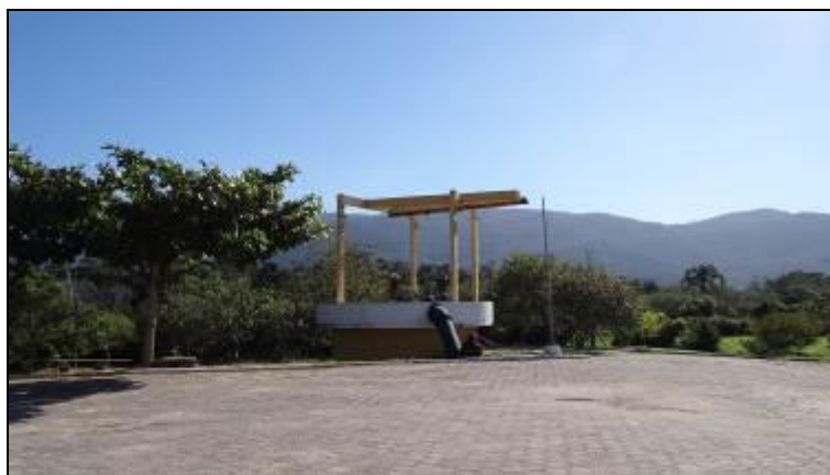
Figura 76 – Casa das máquinas onde é feito o recalque para a ETA (Acompanhamento)
