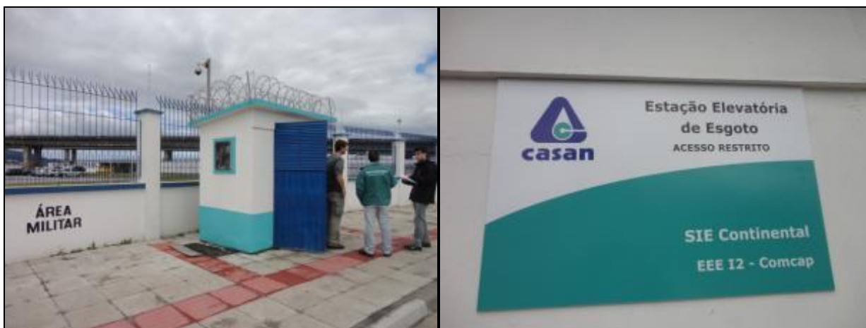
Figura 689- Vista da EEE I2Comcap com placa de identificação e restrição de acesso
