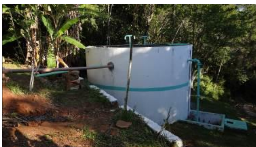
Figura 273 – Quilombo – Vista geral do reservatório (Acompanhamento)
