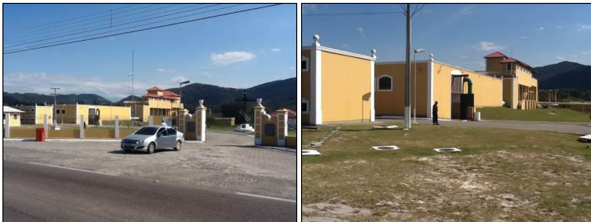
Figura 189 - Entrada principal e panorâmica geral da ETA Coord. Geográficas: 27°43'46.89"S 48°30'32.93"O (Inicial)
