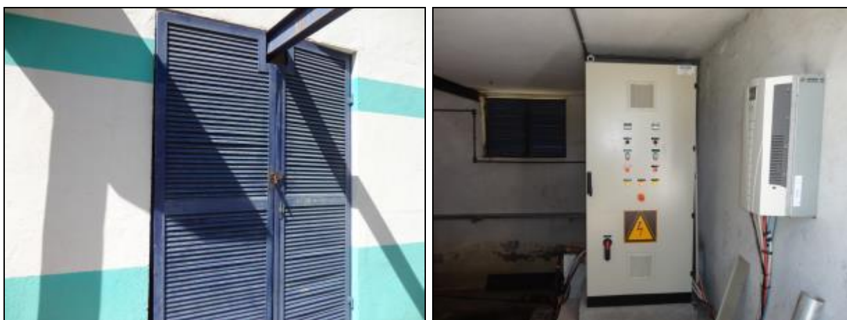
Figura 722- Vista externa e interna da casa de comando
