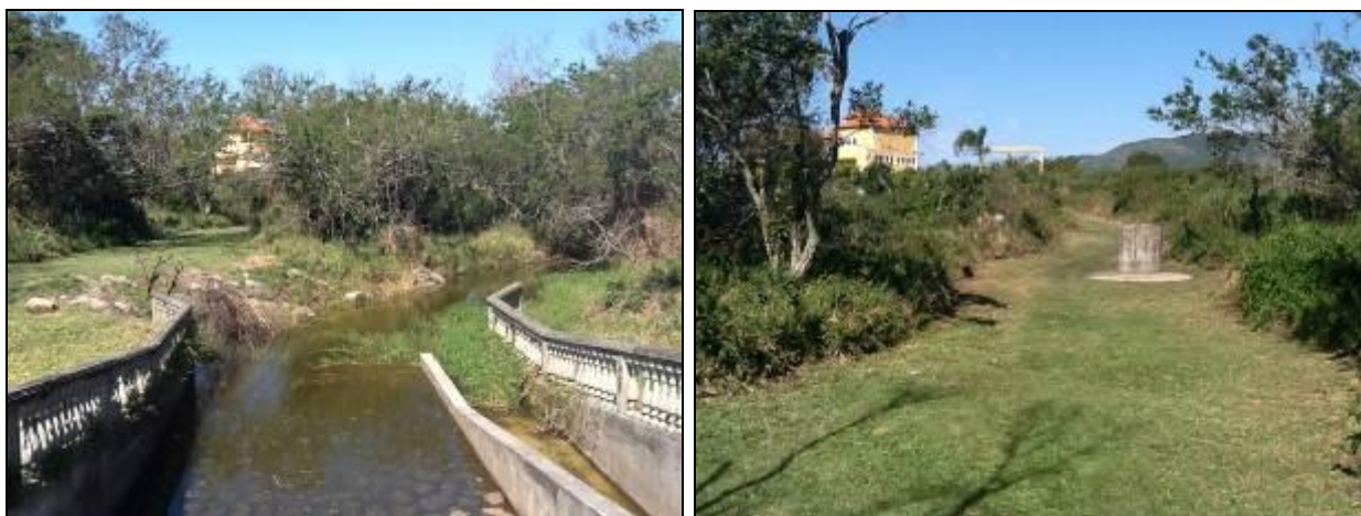
Figura 77 - Caminhos de acesso da ETA à Captação (Inicial)
