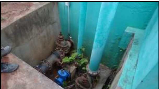
Figura 302- Área do Reservatório Barra da Lagoa com placa de identificação e local das válvulas sem grade de proteção (Acompanhamento)
