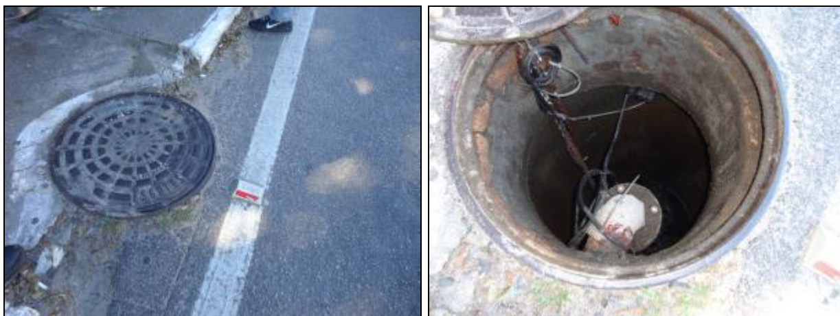
Figura 669- Vista externa e interna do poço úmido
