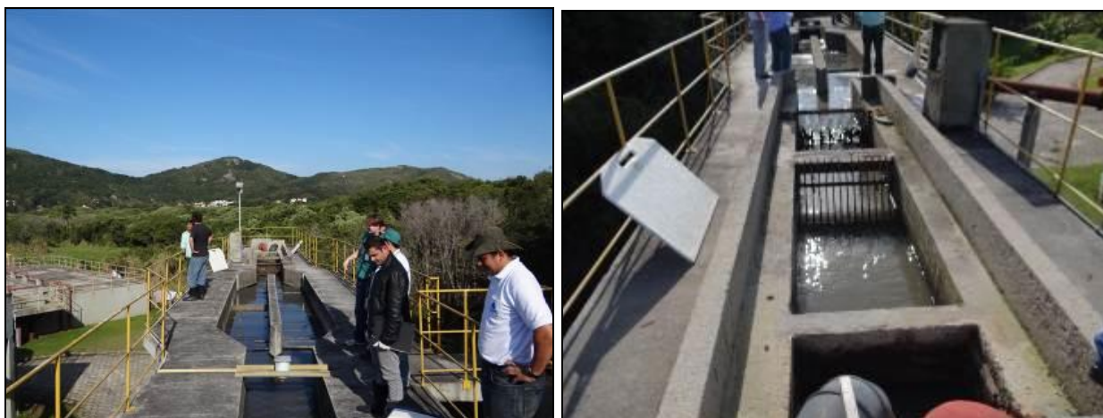
Figura 557 - Área de chegada, caixa de areia e gradeamento (Inicial)
