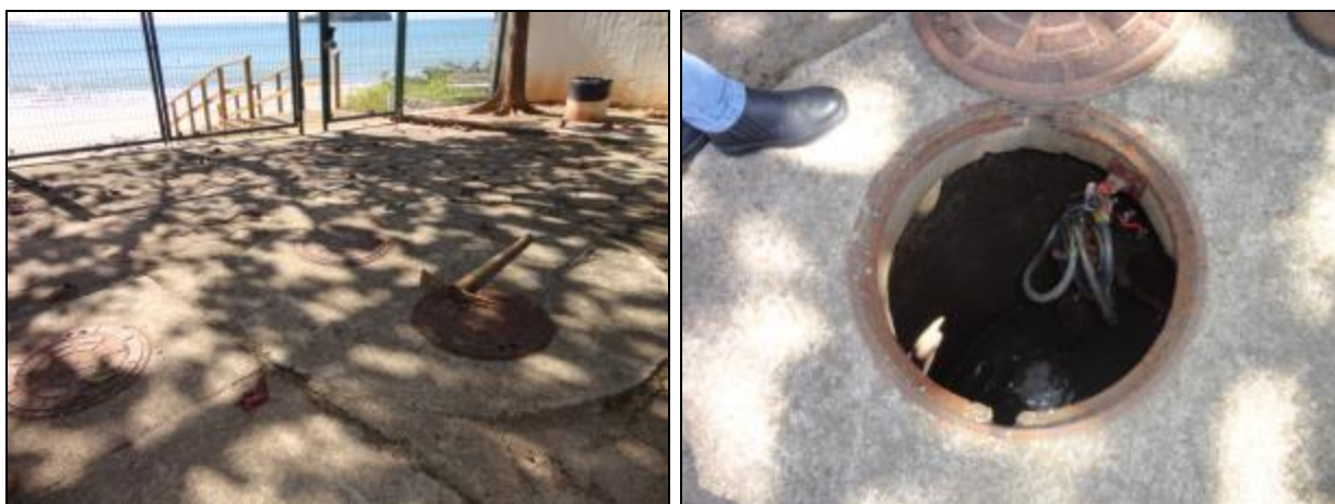
Figura 607- Vista exterior e interior do poço úmido
