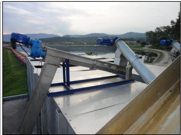
Figura 591 – Equipamentos de tratamento inicial do esgoto na entrada da ETE: separação de sólidos (Acompanhamento)
