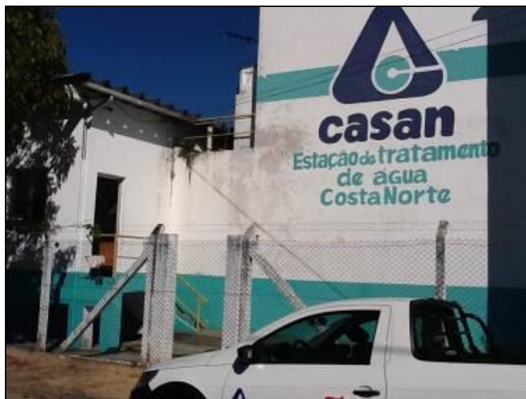
Figura 206 - Fachada e panorâmica geral da ETA - Coord. Geográficas: 27°26'35.17" S / 48°23'42.39" O (Inicial)
