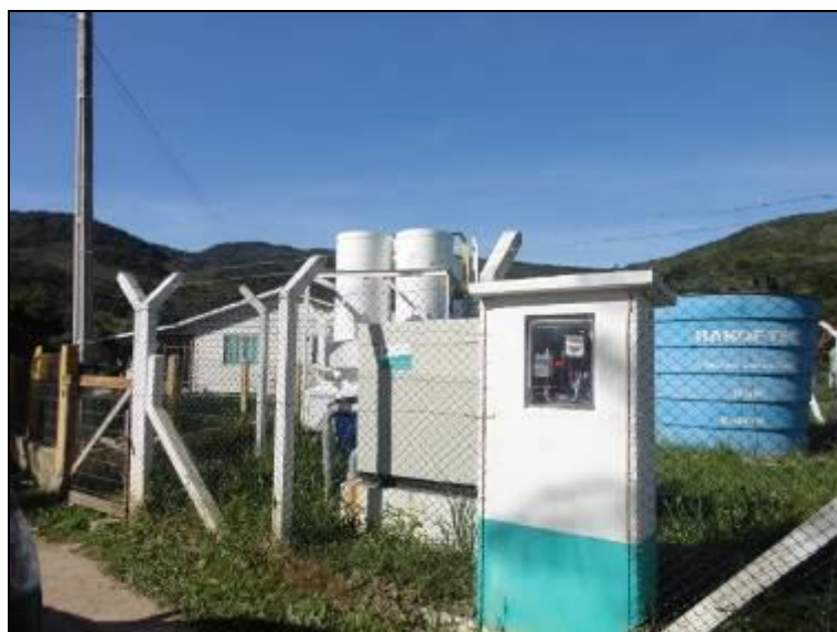
Figura 321- Vista geral do Booster ETA Vargem Grande que está desativado
