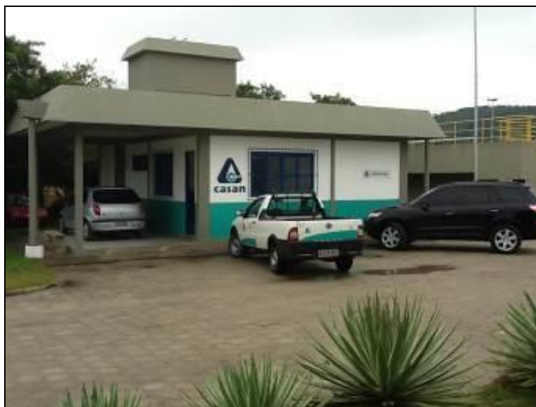
Figura 503 - Fachada da área administrativa da Estação Canasvieiras (Inicial)
