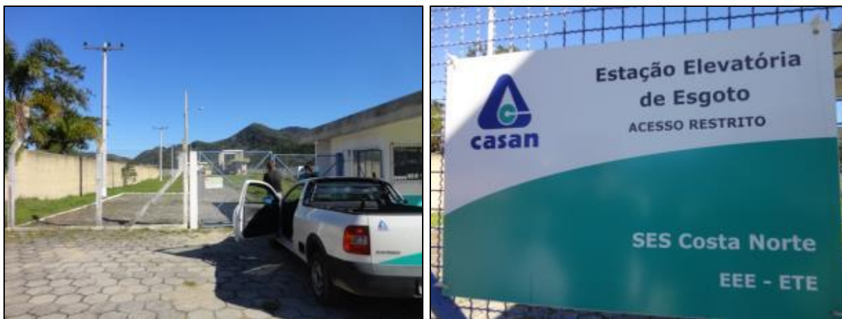
Figura 628- Vista geral da EEE ETE Ingleses com placa de identificação e restrição de acesso
