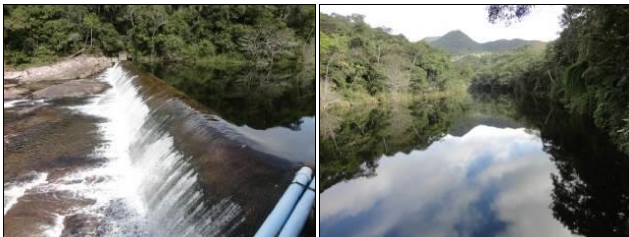
Figura 2 – Visão geral do manancial situada em Pilões (Acompanhamento)
