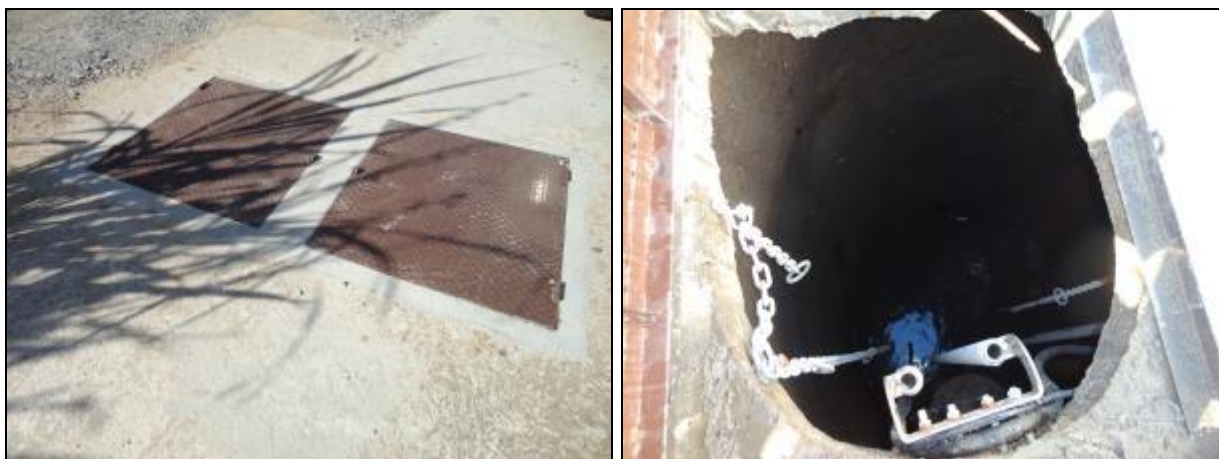
Figura 737- Vista externa e interna no poço úmido
