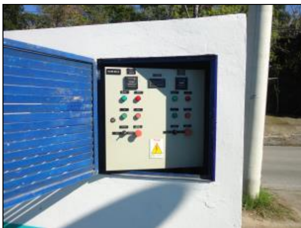
Figura 680- Quadro de comando (à esquerda) e quadro de energia (à direita)
