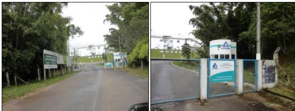
Figura 144 – Fachada principal da ETA com placa de identificação (Acompanhamento)
