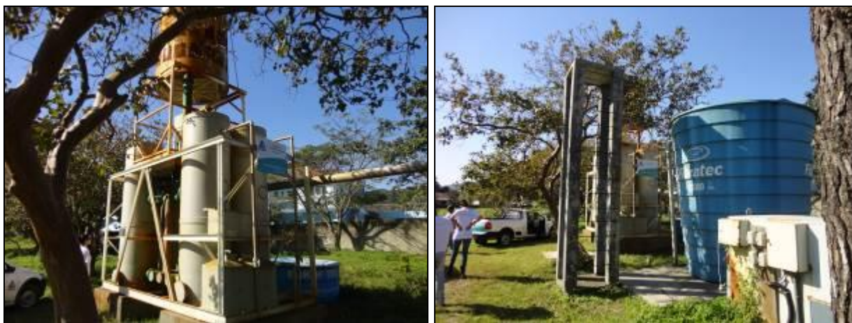
Figura 170 - Panorâmica geral da ETA (Acompanhamento)
