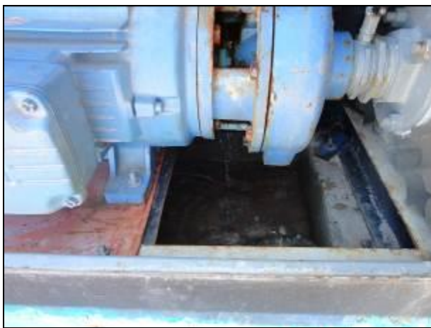
Figura 392- Vazamento na bomba
