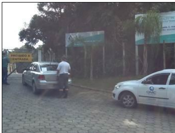
Figura 580 - Acesso e pátio interno da ETE (Inicial)
