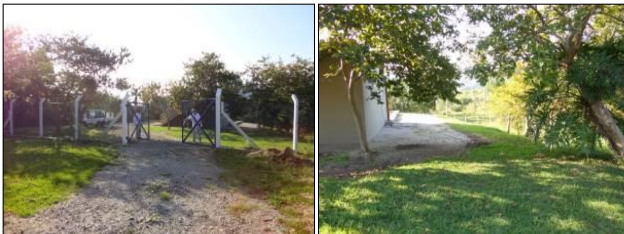
Figura 478 – A área está cercada (Acompanhamento)
