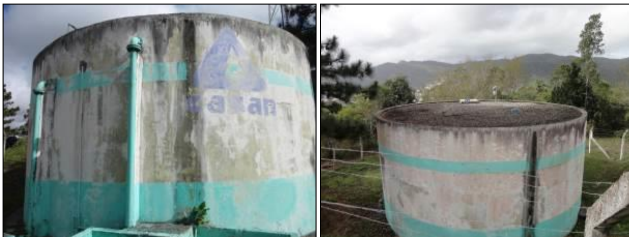
Figura 265 – Caiobig – Saco Grande – Vista geral do reservatório (Acompanhamento)
