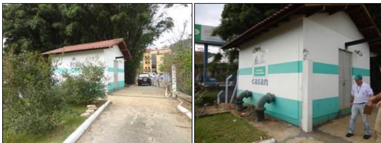
Figura 495 – Acesso à ETE Parque Tecnológico (Acompanhamento)
