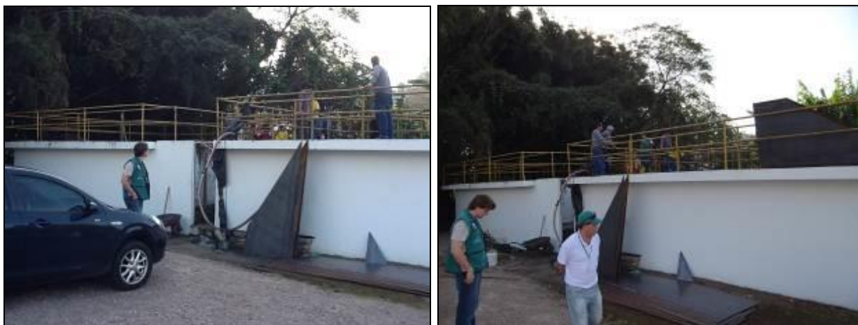
Figura 497 - Vista geral da ETE (Inicial)
