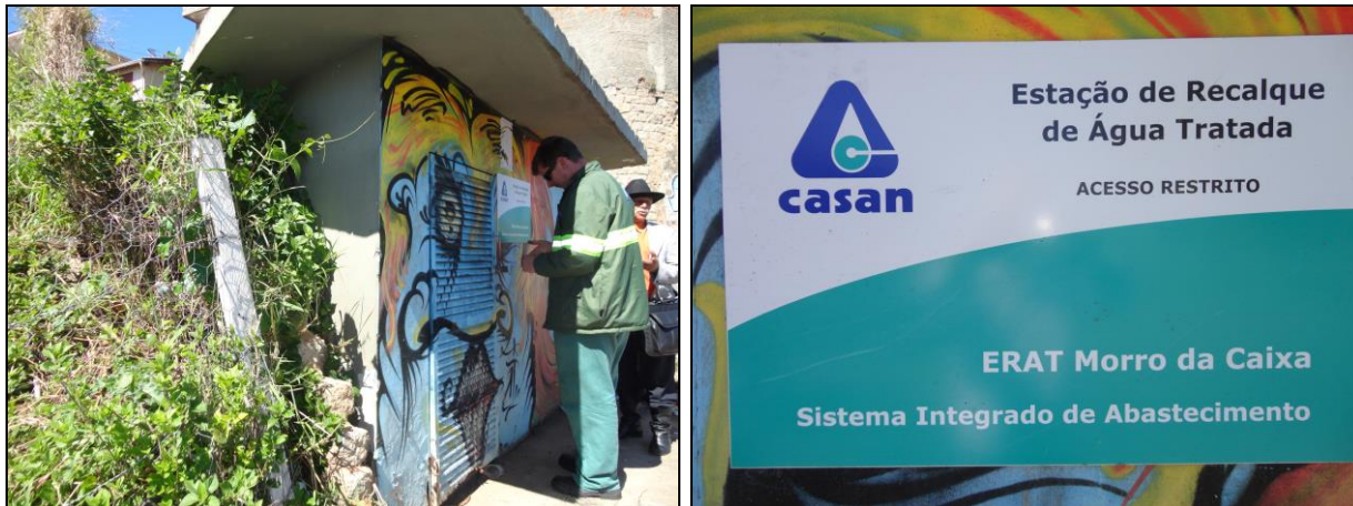
Figura 383- Vista externa do Booster Morro da Caixa com placa de identificação
