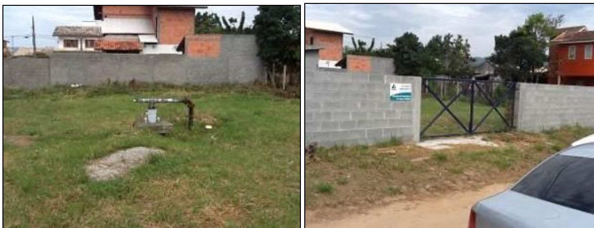
Figura 137 - Área do manancial onde é feita a captação – cercada e identificada (Inicial)
