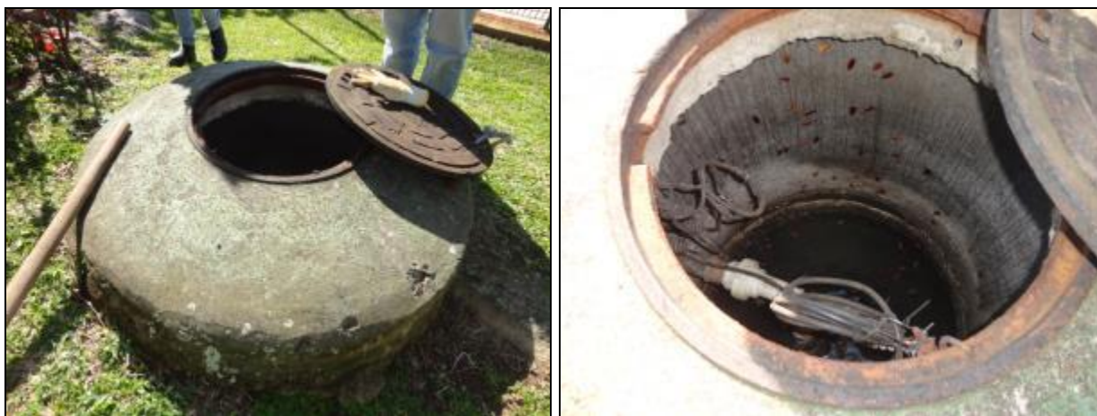
Figura 609- Vista exterior e interior do poço úmido
