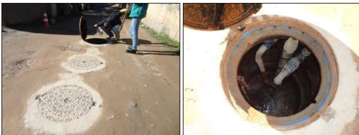
Figura 675- Vista externa e interna do poço úmido
