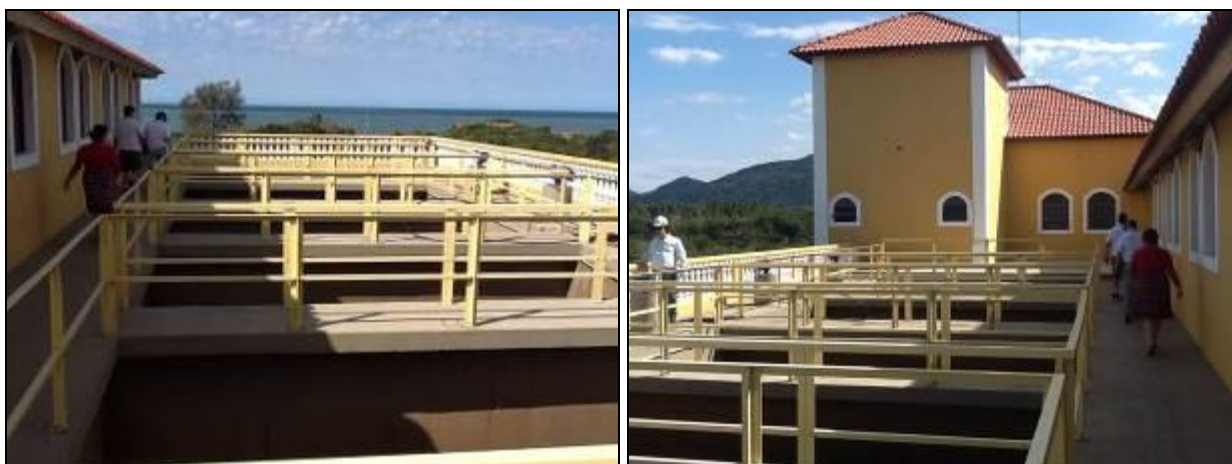
Figura 199 - As áreas de tratamento da água, contam com proteção de guarda-corpo (Inicial)
