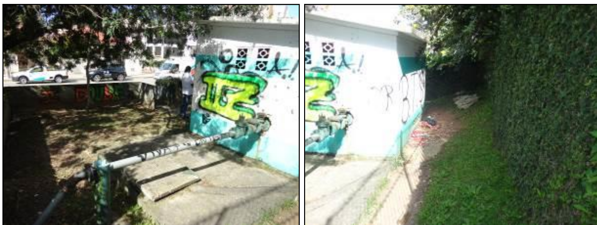
Figura 386- Vista da área onde está o Booster e uma cisterna desativada
