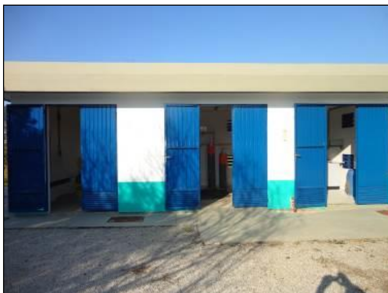
Figura 481 - Prédio de apoio: depósitos e escritório (Acompanhamento)
