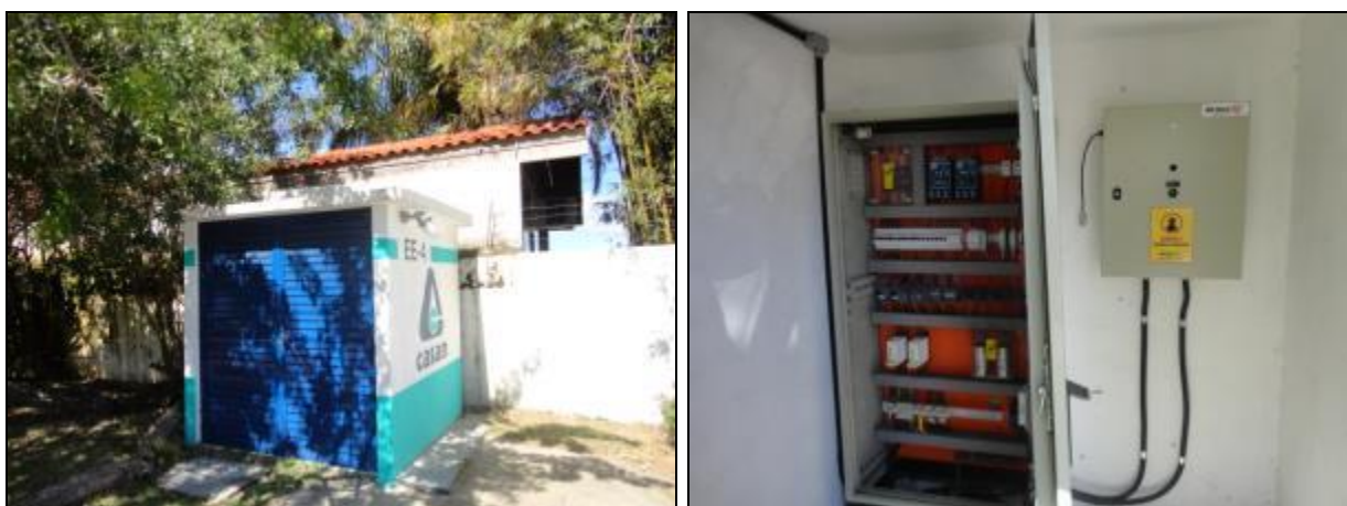
Figura 620- Vista externa e interna da casa de comando
