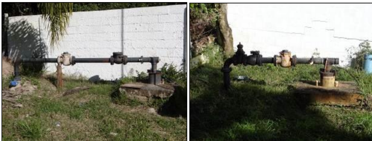
Figura 113 - Área do manancial onde é feita a captação (Inicial)
