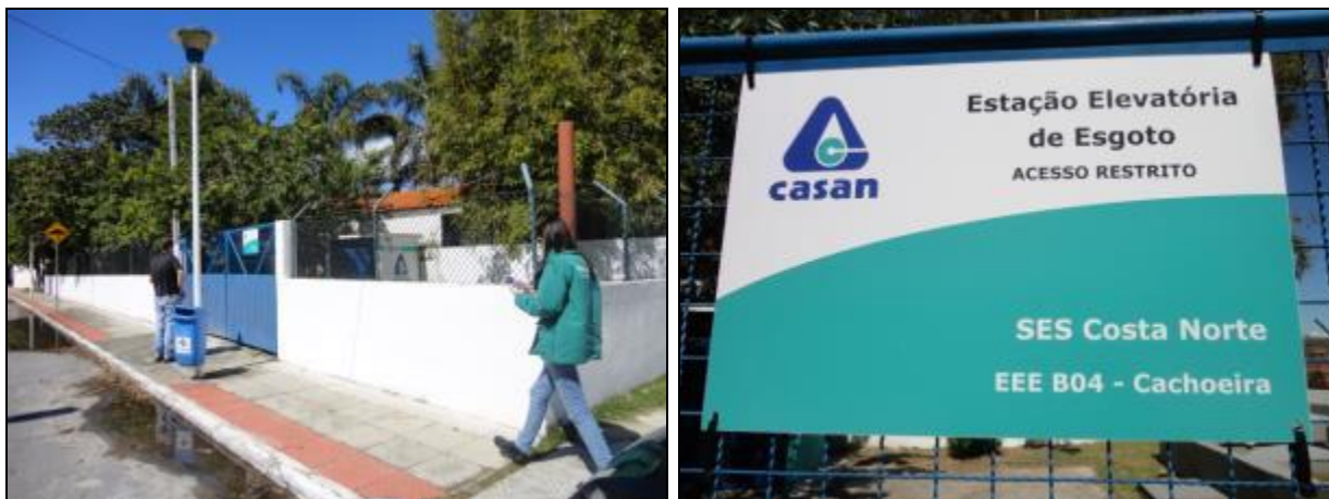
Figura 619- Vista geral da EEE B04 Cachoeira com placa de identificação e restrição de acesso
