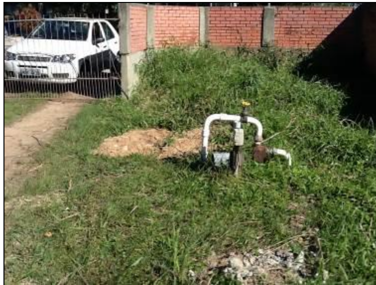
Figura 109 - Área do manancial cercada, porém não identificada (Inicial)
