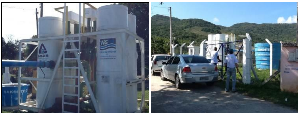
Figura 175 – Fachada/panorâmica geral da ETA e portão de acesso. Coord. Geográficas: 27°28'6.31"S 48°26'38.97"O (Inicial)
