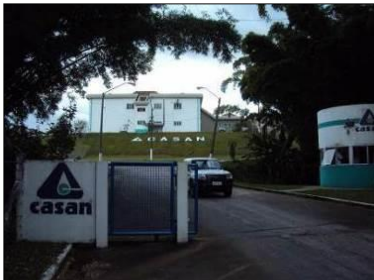
Figura 143 - Fachada principal da ETA (Inicial)
