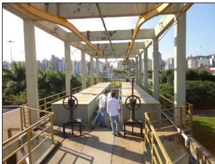
Figura 462 – Estruturas da área de recepção do EB (Acompanhamento)
