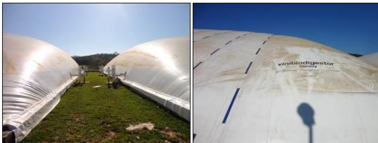
Figura 594 - Sistema de recuperação de gás metano: projeto em vias de conclusão (Inicial)
