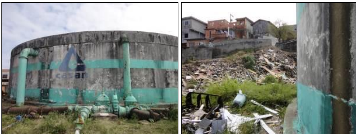
Figura 242 – R-07 – Serrinha – Vista geral do reservatório e das condições do entorno (Acompanhamento)
