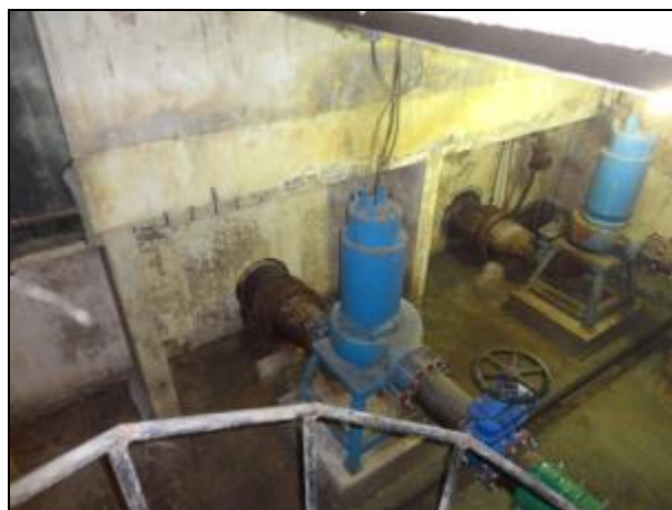
Figura 709- Vista externa do poço úmido (à esquerda) e vista das bombas submersíveis de poço seco (à direita)
