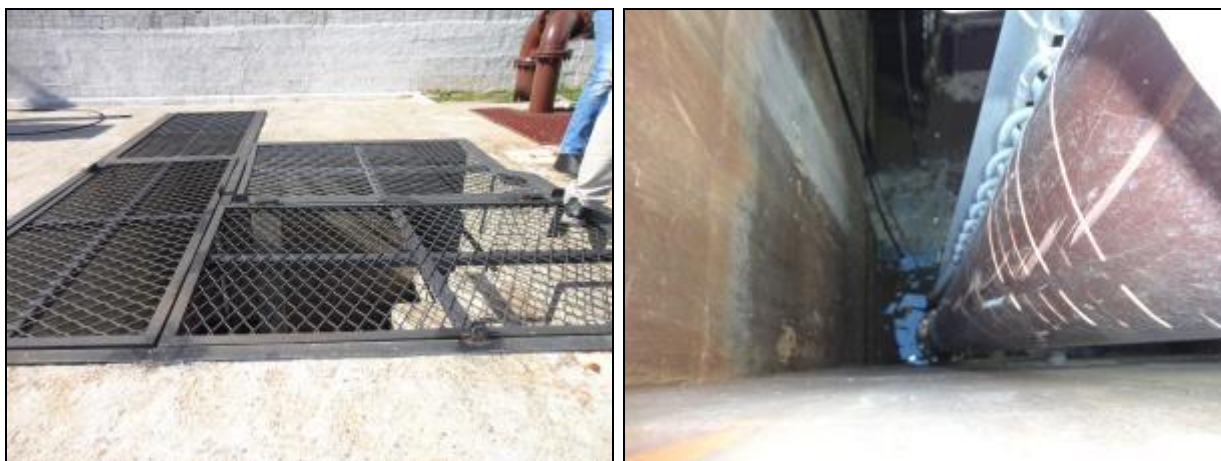
Figura 757- Vista externa e interna do poço úmido
