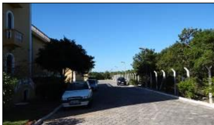
Figura 196 – Alguns trechos da cerca da ETA (Acompanhamento)
