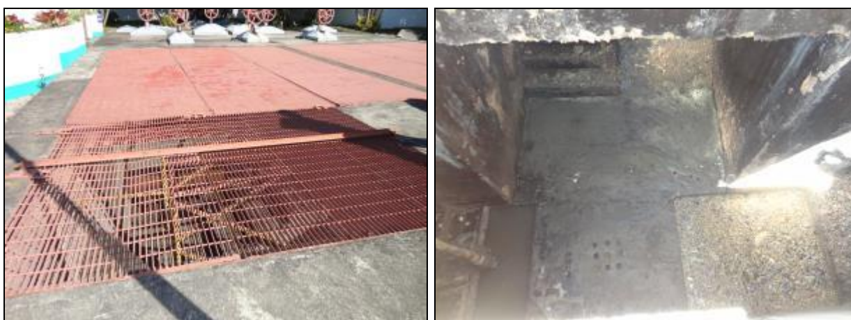
Figura 762- Vista externa e interna do poço úmido
