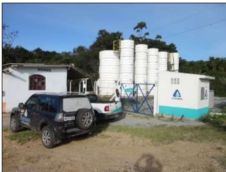
Figura 183 – Entorno da Estação (Acompanhamento)
