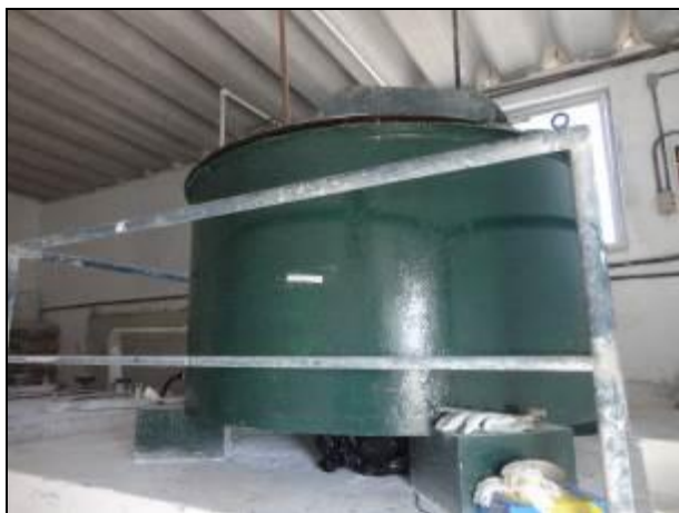
Figura 215 – Casa de química (fora de uso) e armazenamento de produtos químicos. Tanque somente utilizado para misturar Ortopolifosfato (Acompanhamento)
