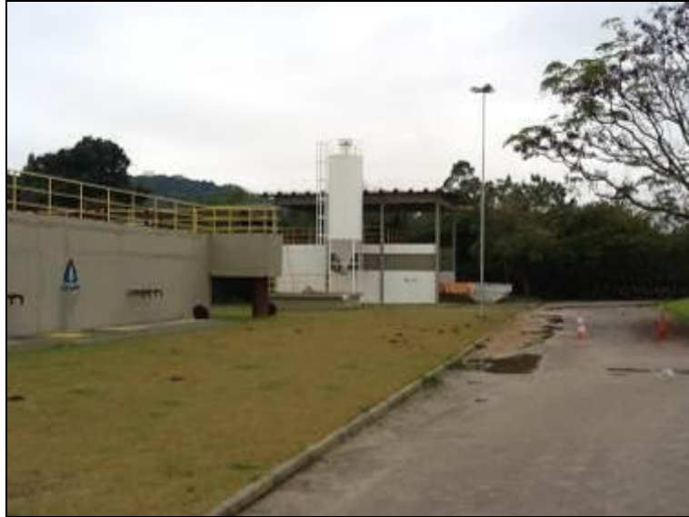
Figura 505 - Reatores UASB (Inicial)
