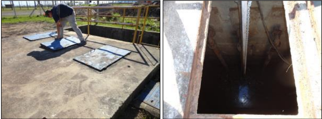
Figura 734- Vista externa e interna do poço úmido
