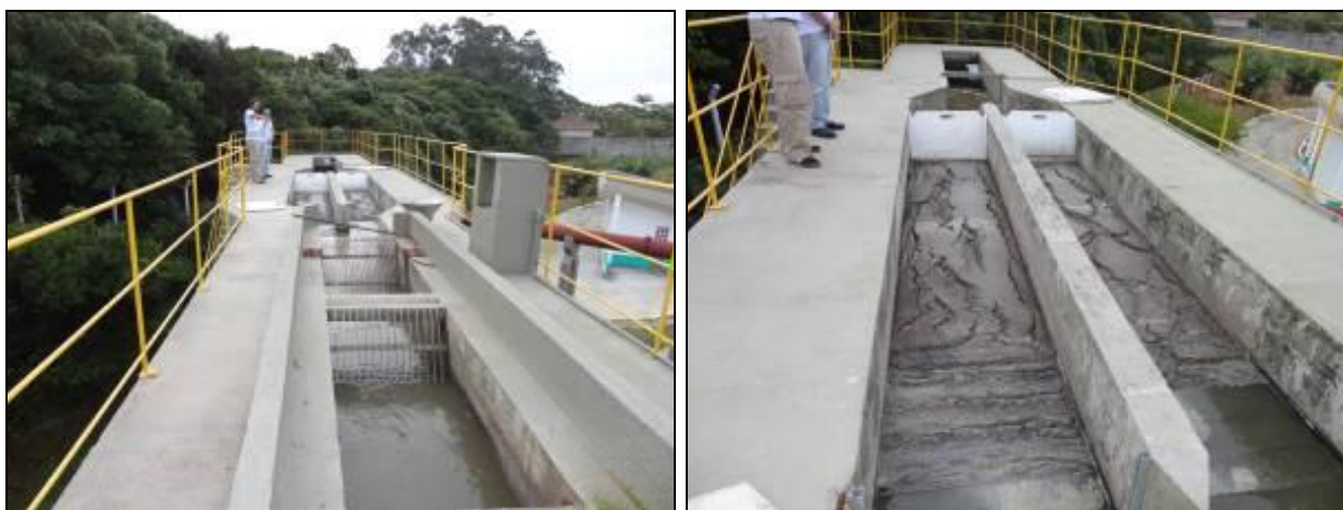
Figura 558 – Área de chegada do esgoto bruto (Acompanhamento)
