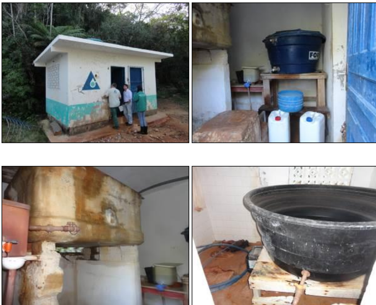
Figura 56 – Casa de química e área interna (Acompanhamento)
