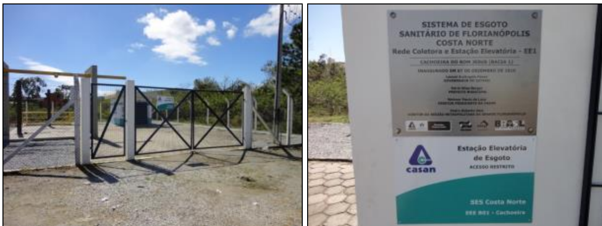
Figura 596- Vista geral da EEE B01 Cachoeira com placa de identificação e restrição de acesso
