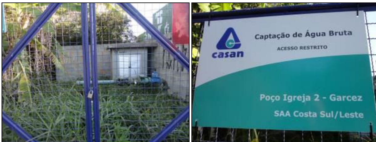
Figura 128 – Área do manancial parcialmente murada e identificada (Acompanhamento)
