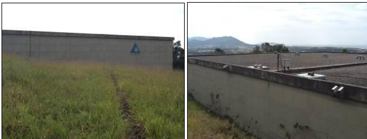
Figura 293 - Morro das Pedras Coord. Geográficas: 27°42'35.79"S 48°30'39.85"O (Inicial)
