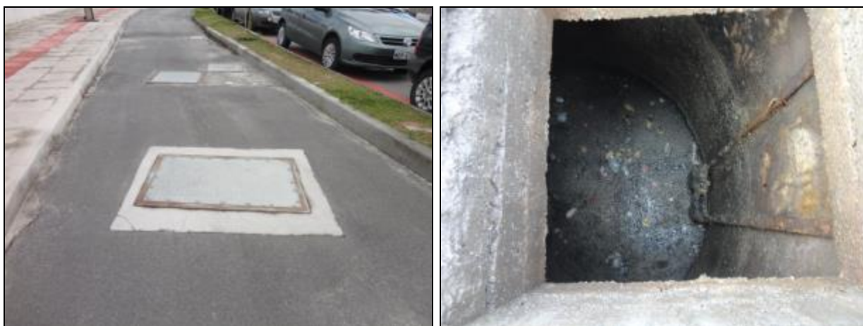
Figura 691- Vista externa e interna do poço úmido
