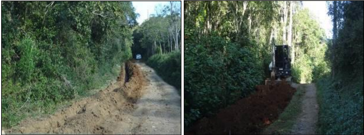
Figura 42 - Acesso à represa (Acompanhamento)
