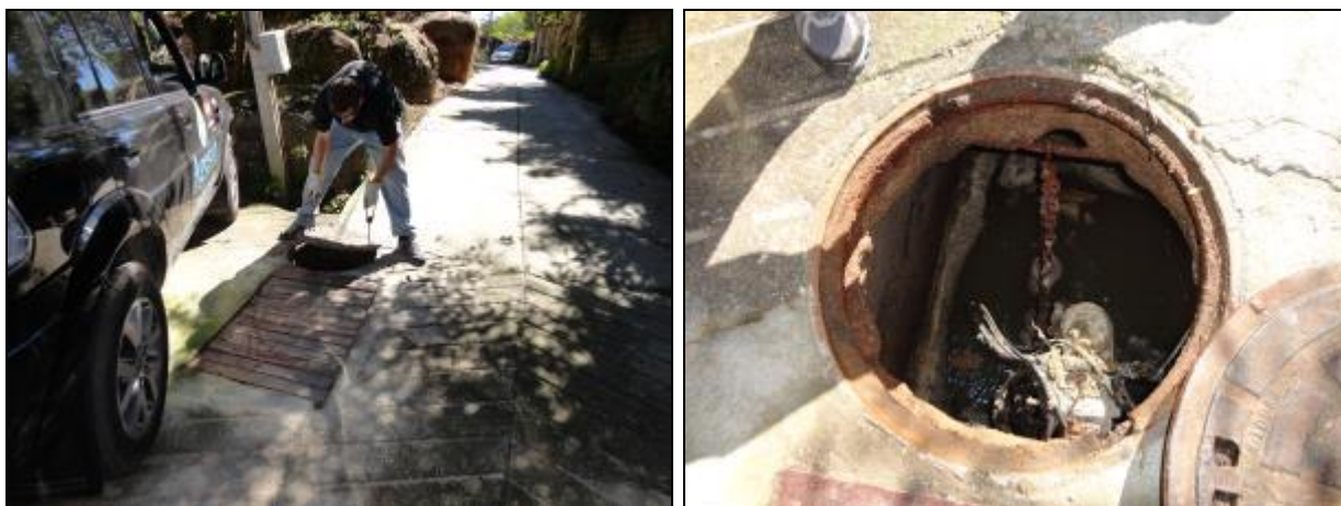
Figura 688- Vista externa e interna do poço úmido
