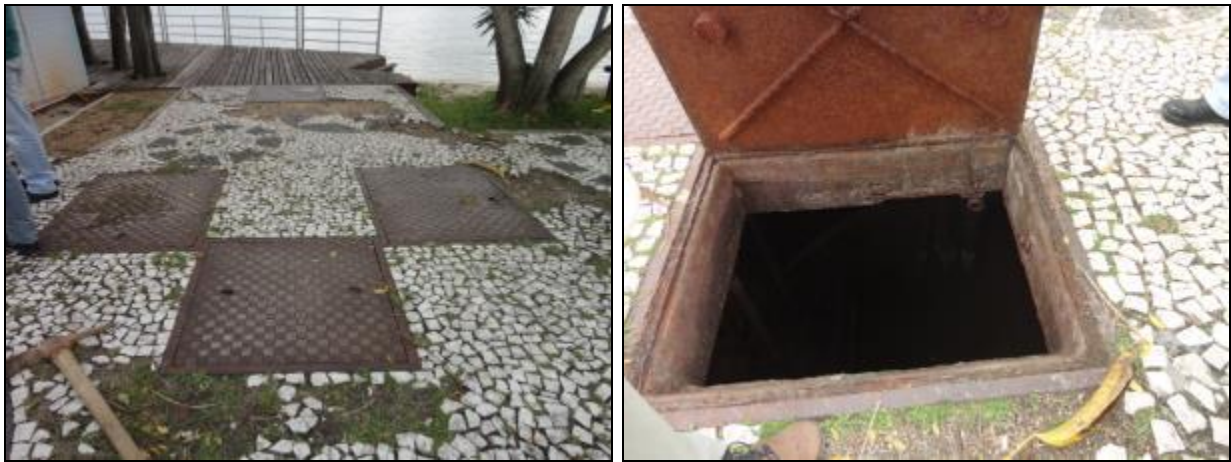
Figura 700- Vista exterior e interior do poço úmido
