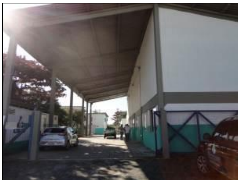
Figura 209 - Acesso à ETA Ingleses (Acompanhamento)
