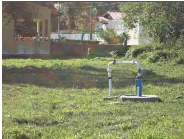
Figura 320- Vista das duas ponteiras da Cachoeira do Bom Jesus que operam somente no verão
