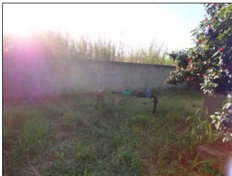
Figura 131 – Poço Eros (Acompanhamento)
