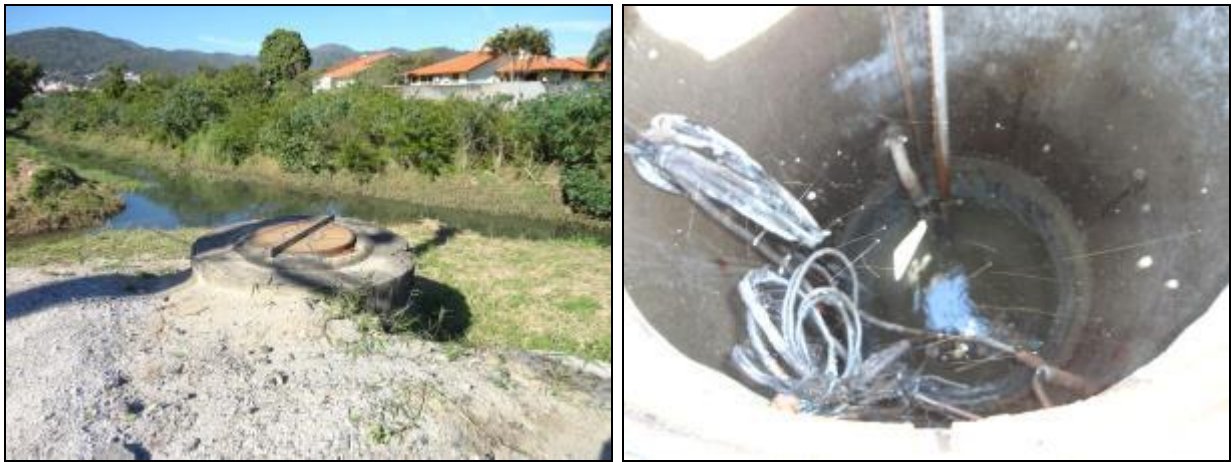
Figura 749- Vista externa e interna do poço úmido
