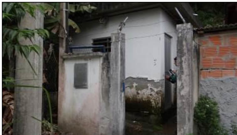
Figura 371- Vista externa da área do ERAT Praia do Forte
