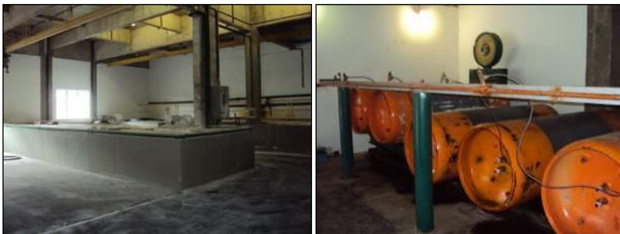
Figura 157 - Casa de Química da ETA (Inicial)
