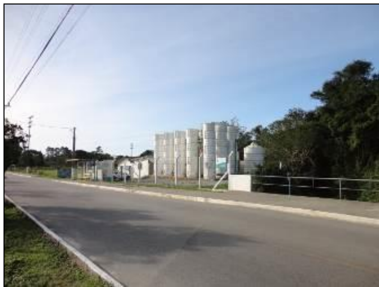
Figura 34 - Área do manancial cercada, porém não identificada (Acompanhamento)
