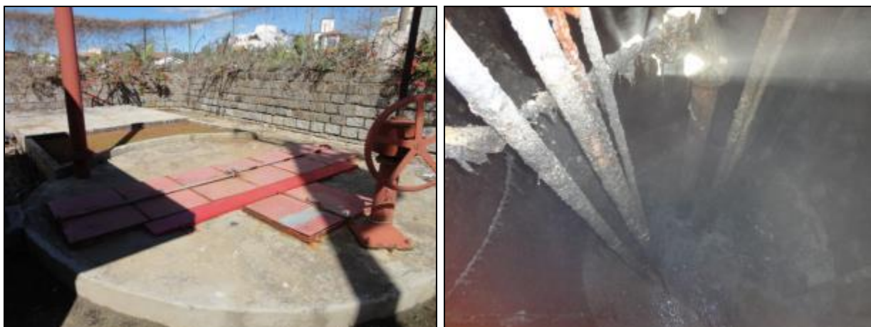
Figura 602- Vista externa e interna do poço úmido
