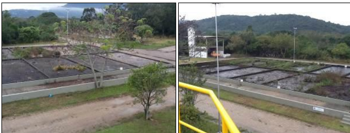
Figura 516 - Leitos de secagem do lodo (Inicial)
