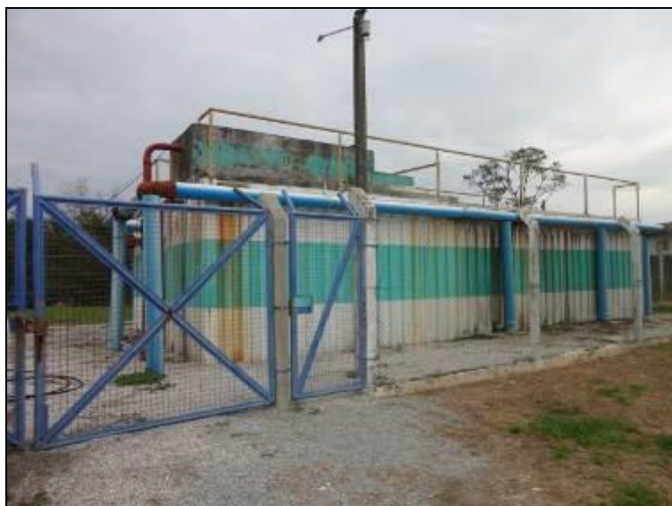
Figura 542 – Estação de Tratamento de Esgotos (Acompanhamento)
