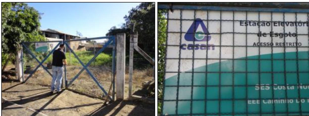
Figura 622- Vista geral da EEE Caminho do Mar com placa de identificação e restrição de acesso
