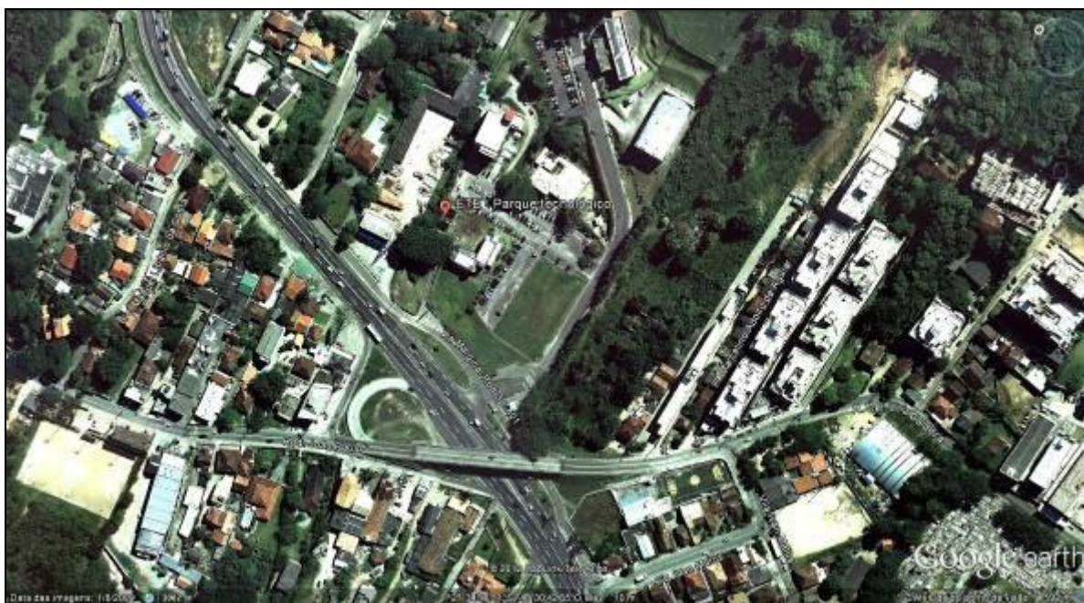
Figura 493 - Estação de Tratamento de Esgotos do Parque Tecnológico. Coordenadas: 27° 34' 18" S / 48° 30' 42" O
