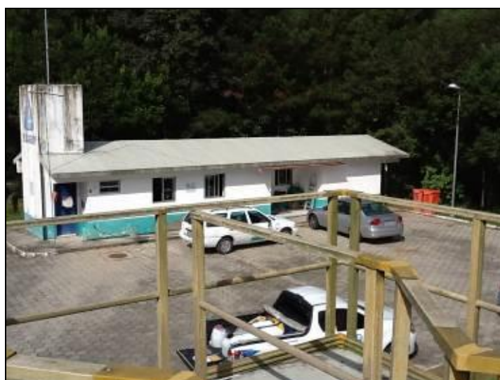
Figura 581 - Área de Apoio: escritório e depósitos (Inicial)
