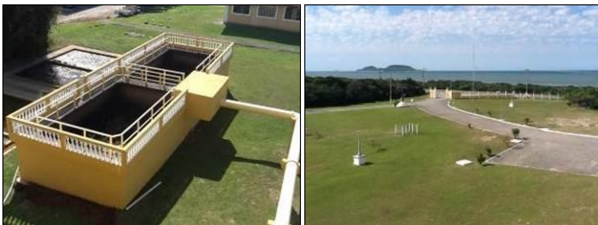
Figura 197 - Áreas externas em bom estado de conservação (Inicial)
