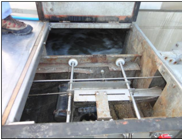
Figura 591 – Equipamentos de tratamento inicial do esgoto na entrada da ETE: separação de sólidos (Acompanhamento)
