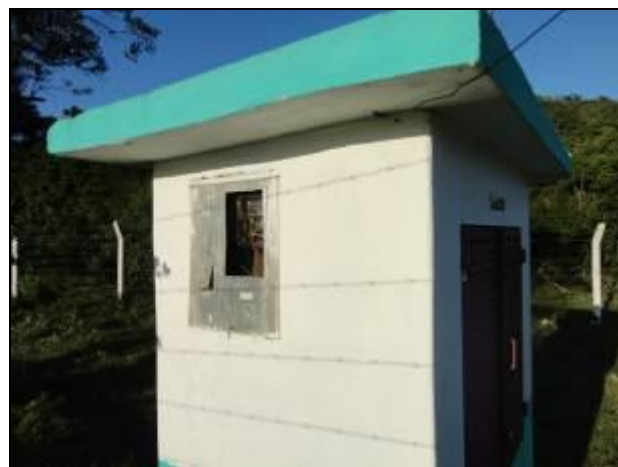
Figura 86 – Quadro de energia sem cadeado, vidro do relógio quebrado, sem identificação (Acompanhamento)
