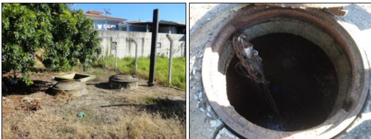
Figura 624- vista externa e interna do poço úmido
