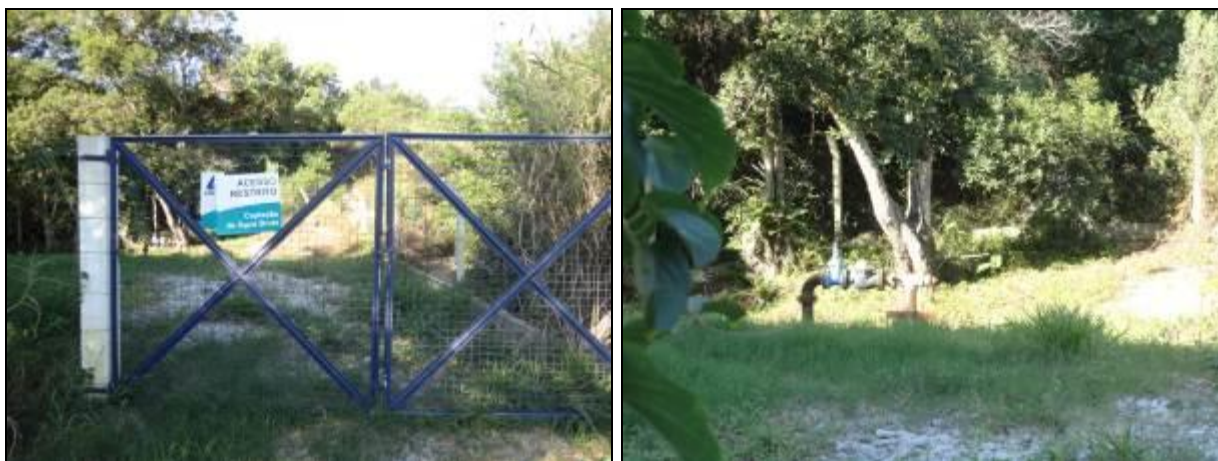
Figura 334- Vista da área do Poço II da ETA Ingleses
