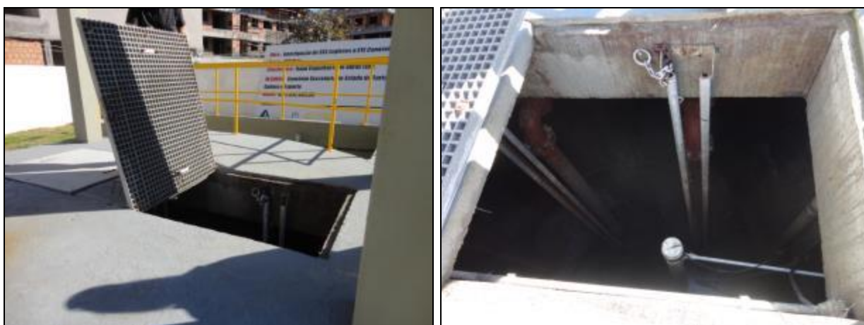
Figura 634- Vista externa e interna do poço úmido
