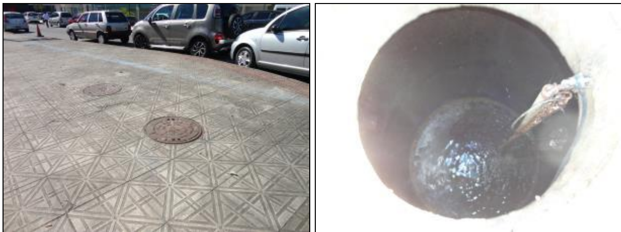
Figura 764- Vista externa e interna do poço úmido
