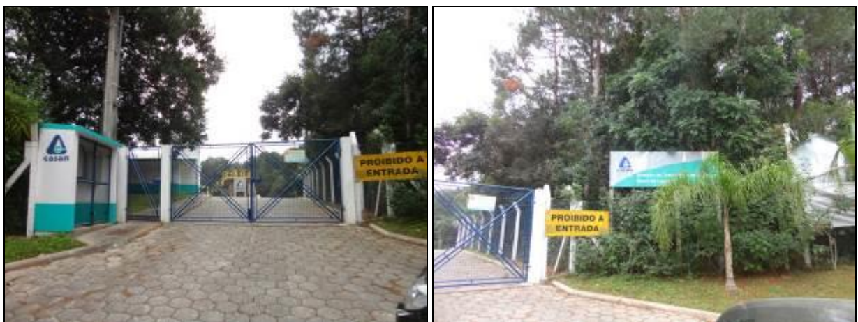
Figura 576 – Entrada da ETE e placas de identificação (Acompanhamento)
