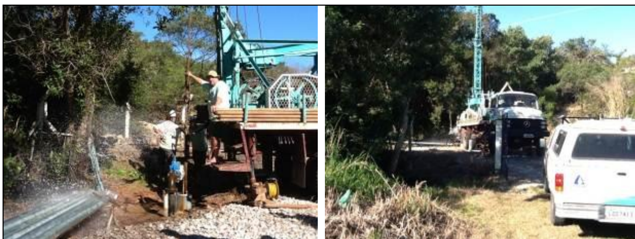
Figura 79 - Ponteiras 01, 02 e 03. Em manutenção (Inicial)
