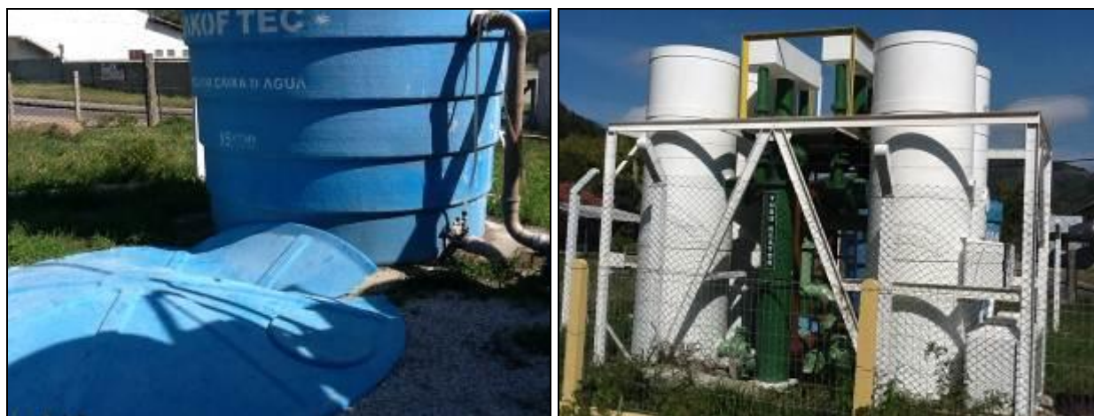
Figura 179 - Áreas externas em bom estado de conservação (Inicial)
