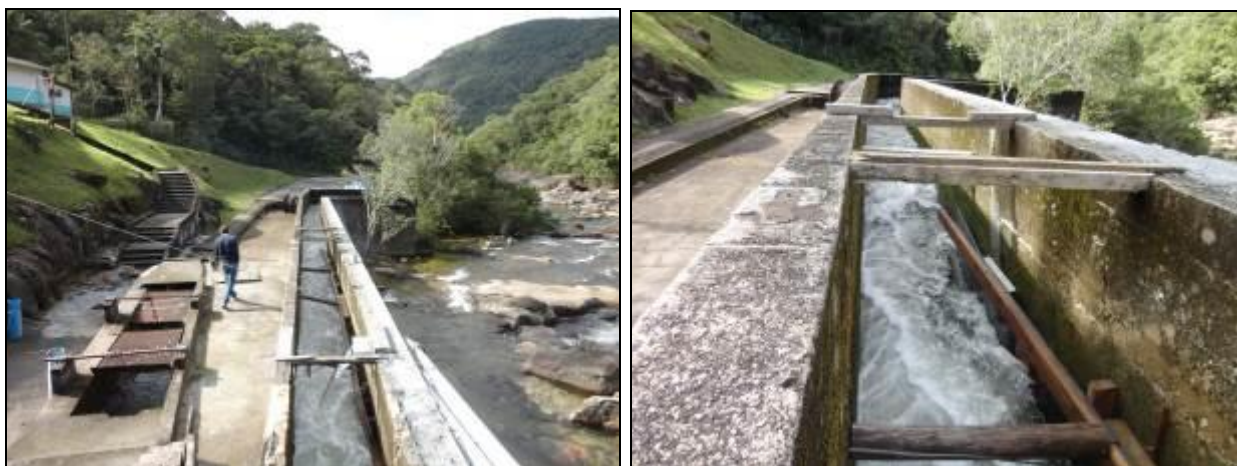
Figura 6 - Imagens da área de captação de Pilões (Acompanhamento)
