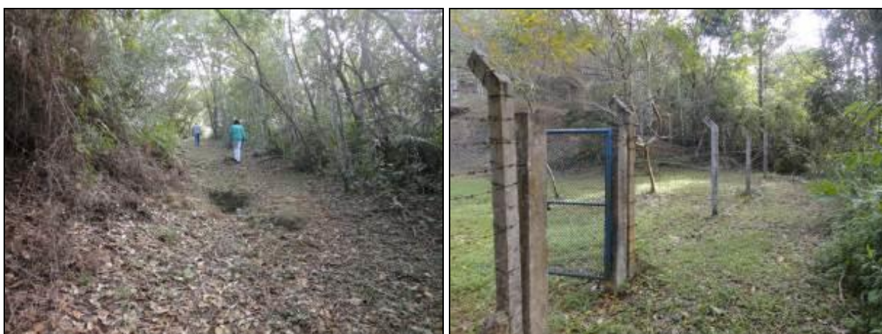
Figura 267 – Cacupé – Acesso e portão do reservatório (Acompanhamento)
