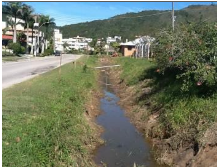
Figura 163 - Entorno da ETA (Inicial)
