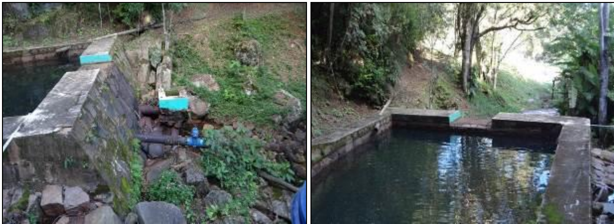
Figura 40 - Represa da Lagoa (Acompanhamento)
