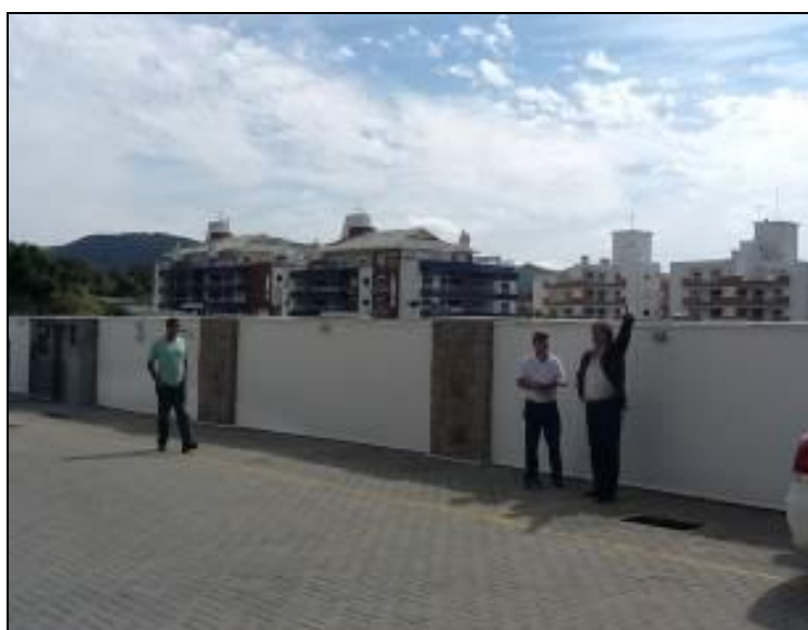
Figura 136 - Captação está localizada dentro de Condomínio Residencial (Inicial)
