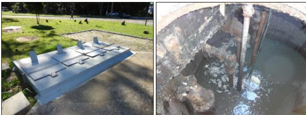
Figura 651- Vista externa e interna do poço úmido
