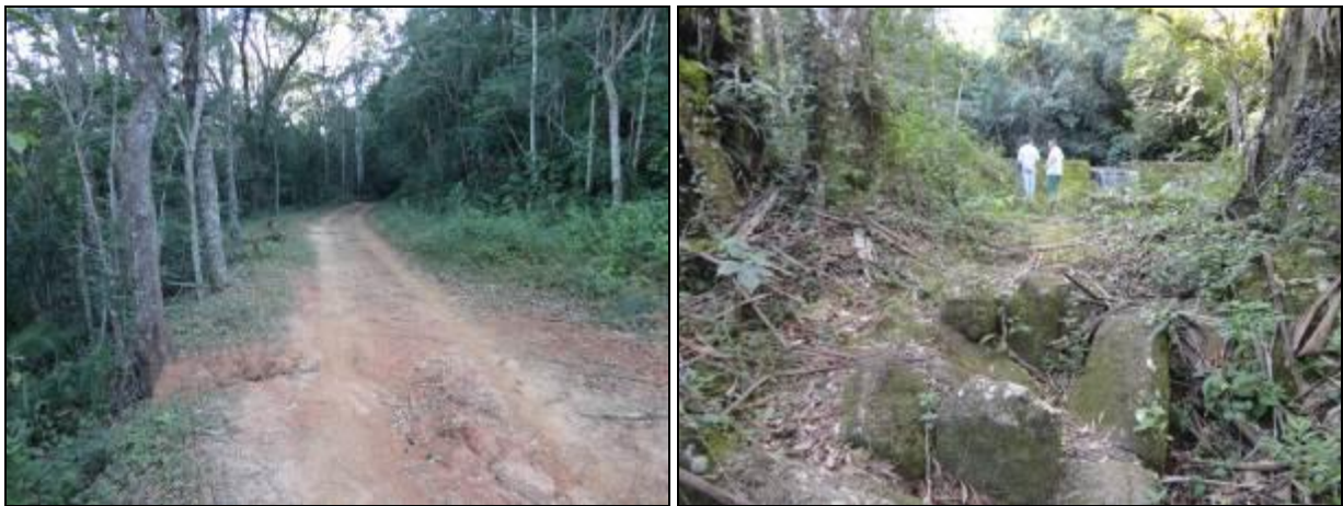
Figura 55 – Acessos para a represa de captação do Rio Tavares (Acompanhamento)
