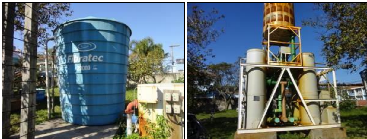
Figura 174 – Pátio da ETA (Acompanhamento)
