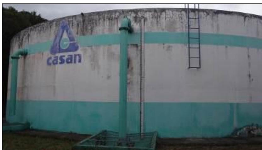
Figura 300- Reservatório Canto da Lagoa (Acompanhamento)
