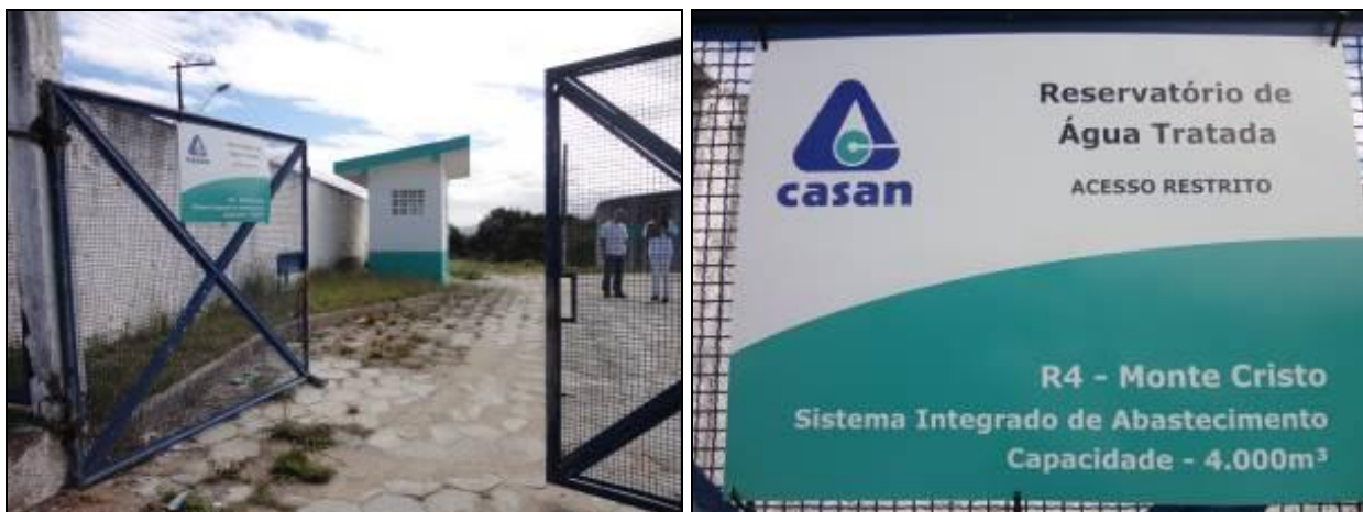
Figura 233 – R-04 – Monte Cristo – Portão de acesso e placa de identificação (Acompanhamento)
