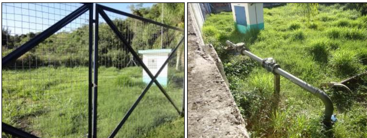
Figura 341- Vista da área do Poço Ipanema
