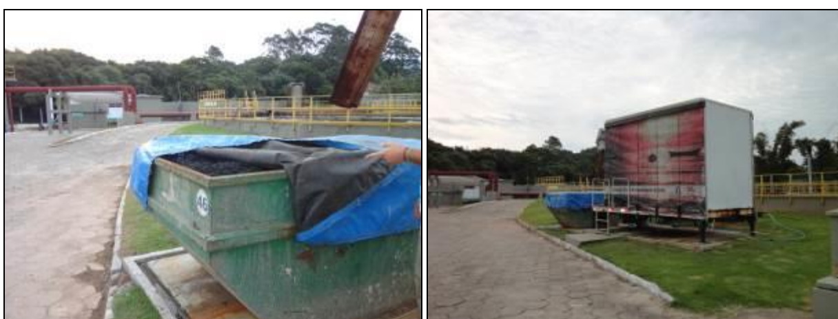
Figura 567 – Lodo desidratada e caminhão desidratador de lodo (Acompanhamento)
