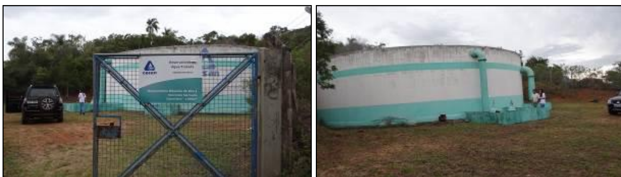
Figura 297- Reservatório Ribeirão da Ilha I com portão de acesso e placa de identificação (Acompanhamento)
