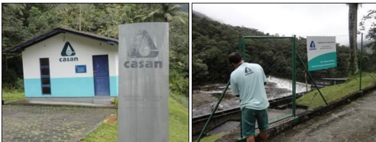
Figura 7 – Imagens da área de captação que se encontra cercada e com placa de identificação (Acompanhamento)
