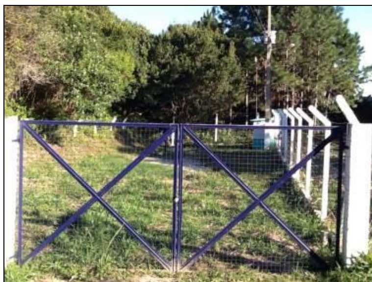
Figura 91 - Área do manancial onde é feita a captação (Inicial)
