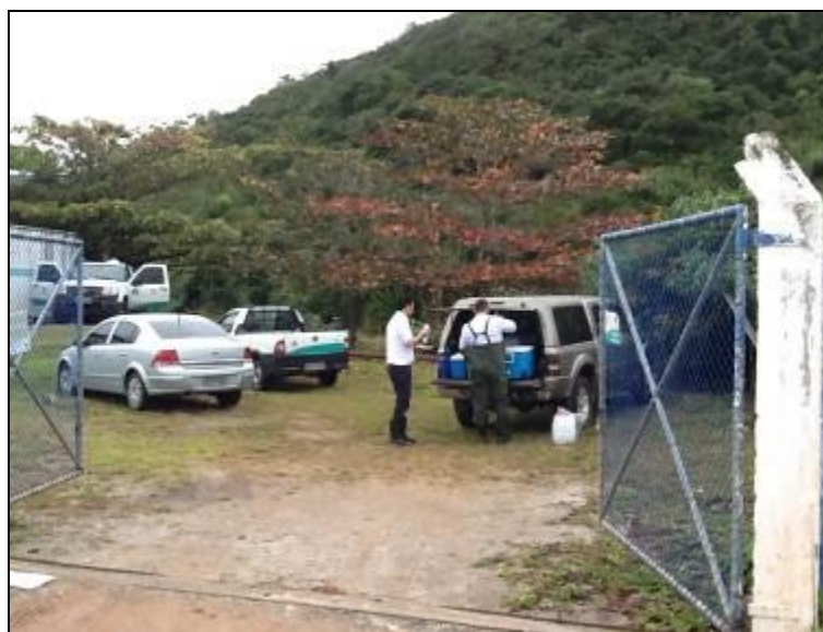
Figura 529- Acesso e pátio interno da ETE (Inicial)
