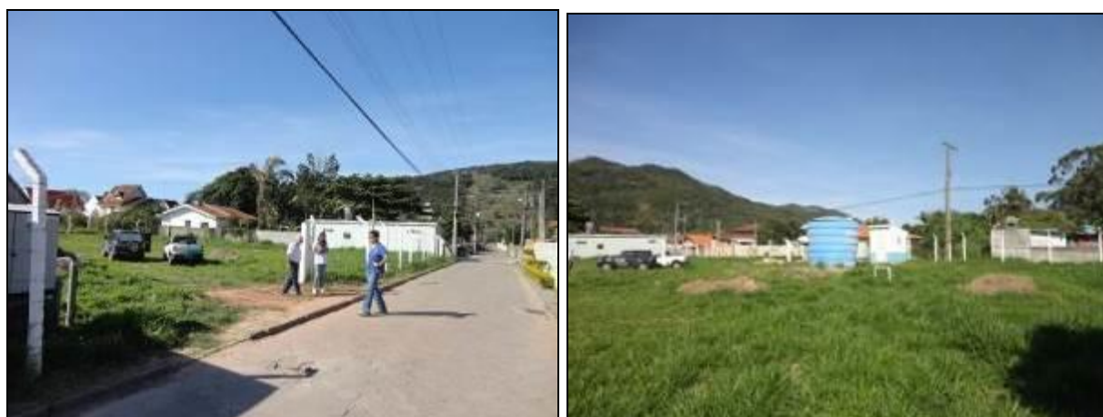
Figura 116 – Área do manancial está sem portão (Acompanhamento)
