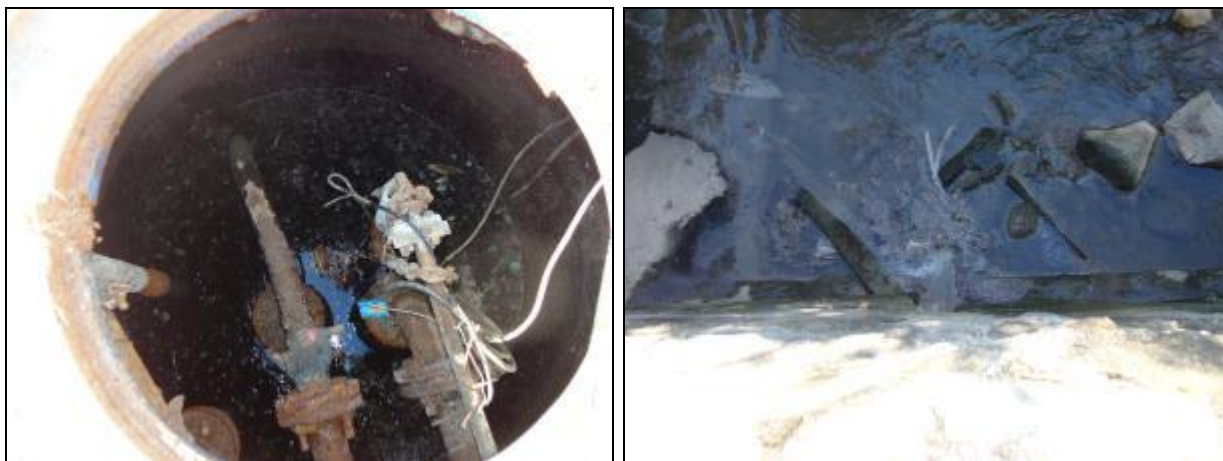
Figura 759- Vista interna do poço úmido (à esquerda) e local onde extravasa o esgoto (à direita)
