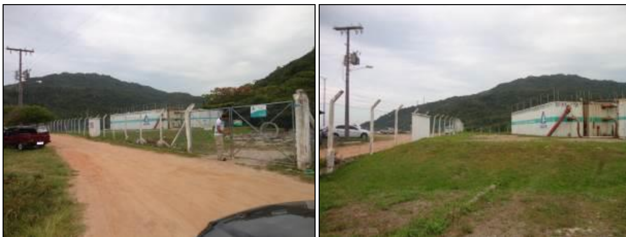
Figura 530 – Acesso e pátio interno da ETE (Acompanhamento)
