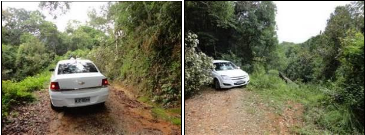
Figura 8 - Acesso sujeito a deslizamentos e queda de vegetação (Inicial)
