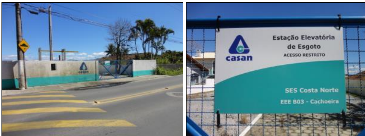
Figura 616- Vista geral da EEE B03 Cachoeira com placa de identificação e restrição de acesso
