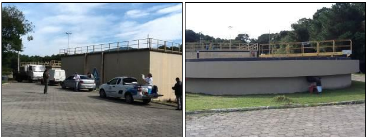
Figura 577 - Reatores UASB e decantador (Inicial)
