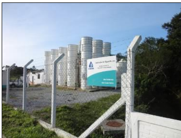
Figura 181 – Panorâmica geral da ETA (Acompanhamento)
