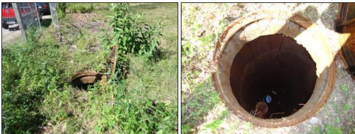
Figura 767- Vista externa e interna do poço úmido
