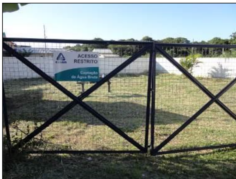
Figura 337- Vista da área do Poço Didi I
