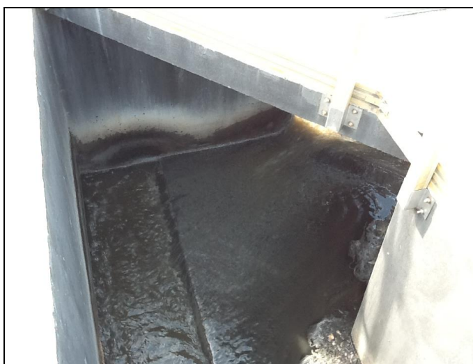
Figura 586 - Entrada do EB (Inicial)
