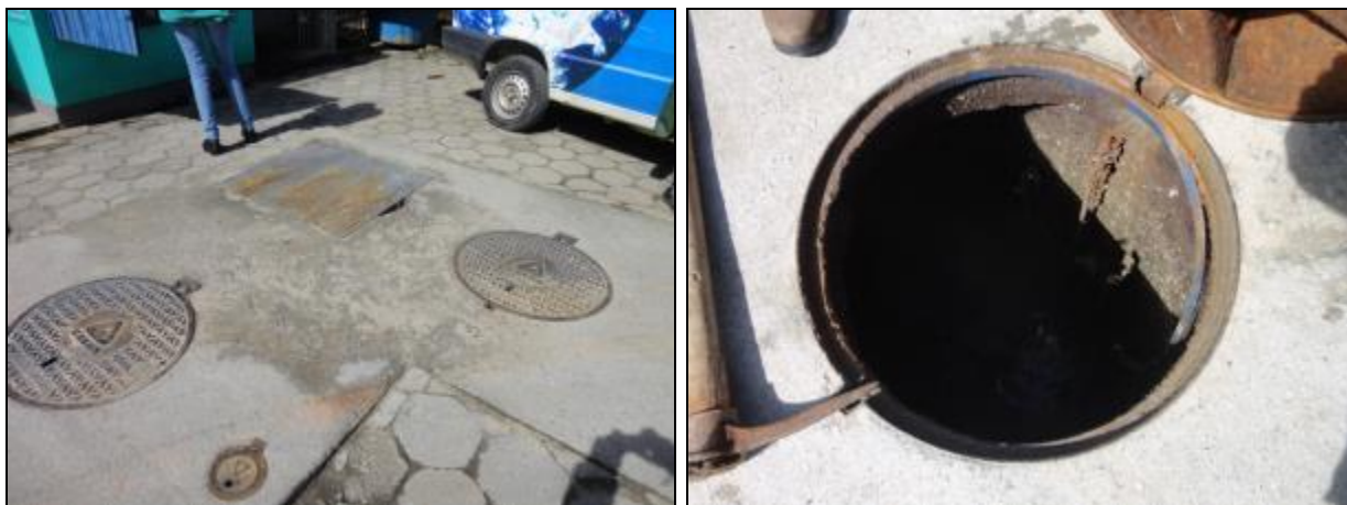
Figura 639- Vista externa e interna do poço úmido
