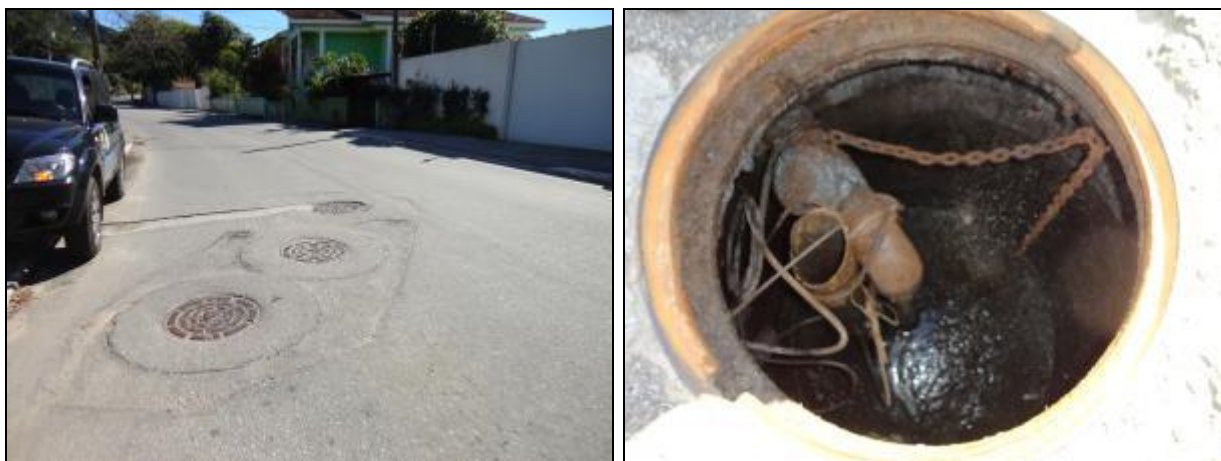
Figura 683- Vista externa e interna do poço úmido
