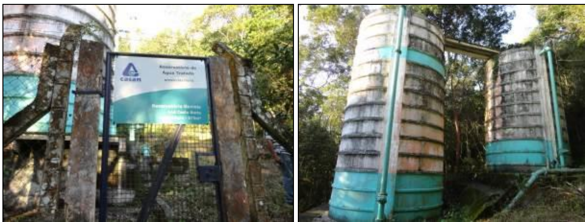
Figura 292 – Reservatório Daniela – Placa de identificação (Acompanhamento)
