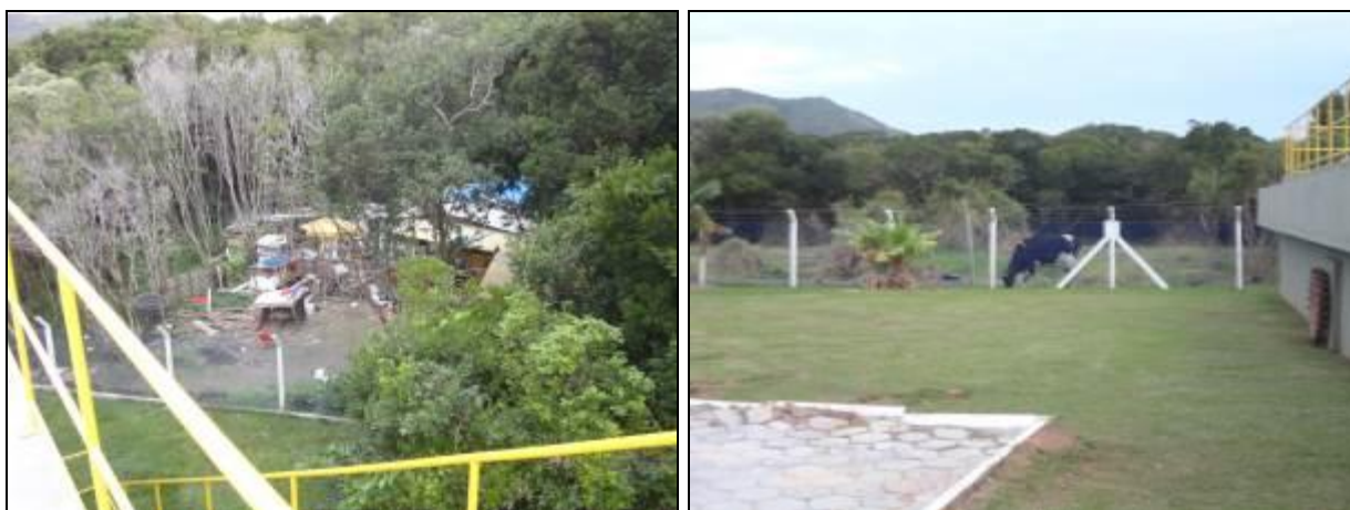
Figura 556 – Áreas do entorno da ETE (Acompanhamento)
