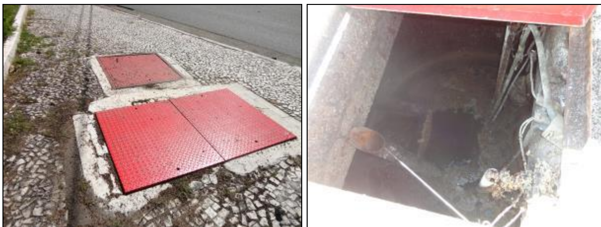
Figura 672- Vista externa e interna do poço úmido
