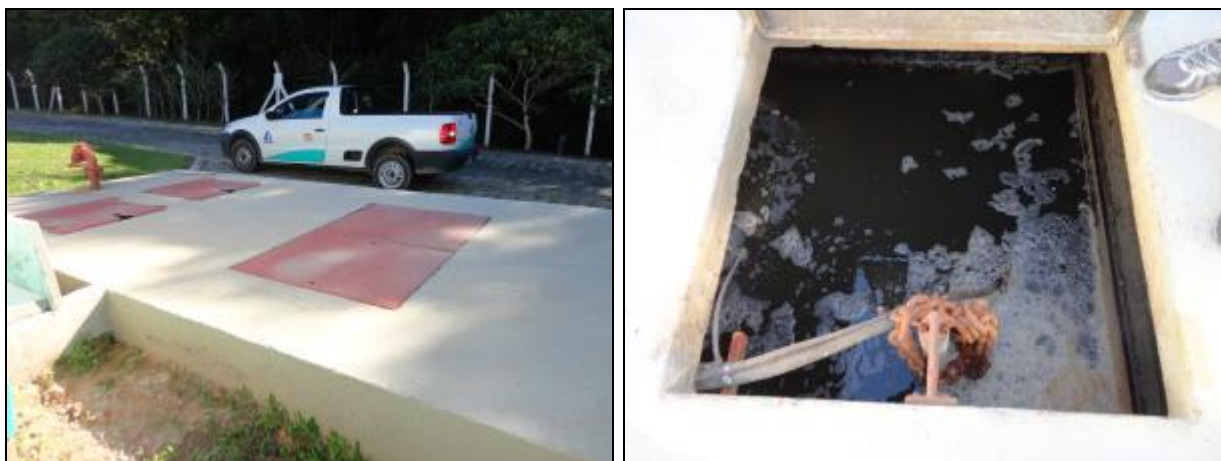
Figura 648- Vista externa e interna do poço úmido
