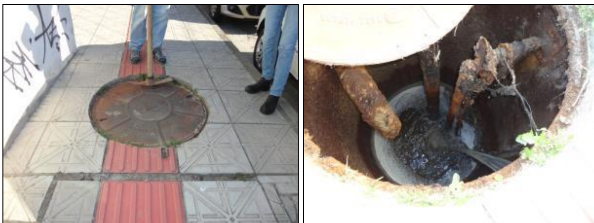
Figura 755- Vista externa e interna do poço úmido
