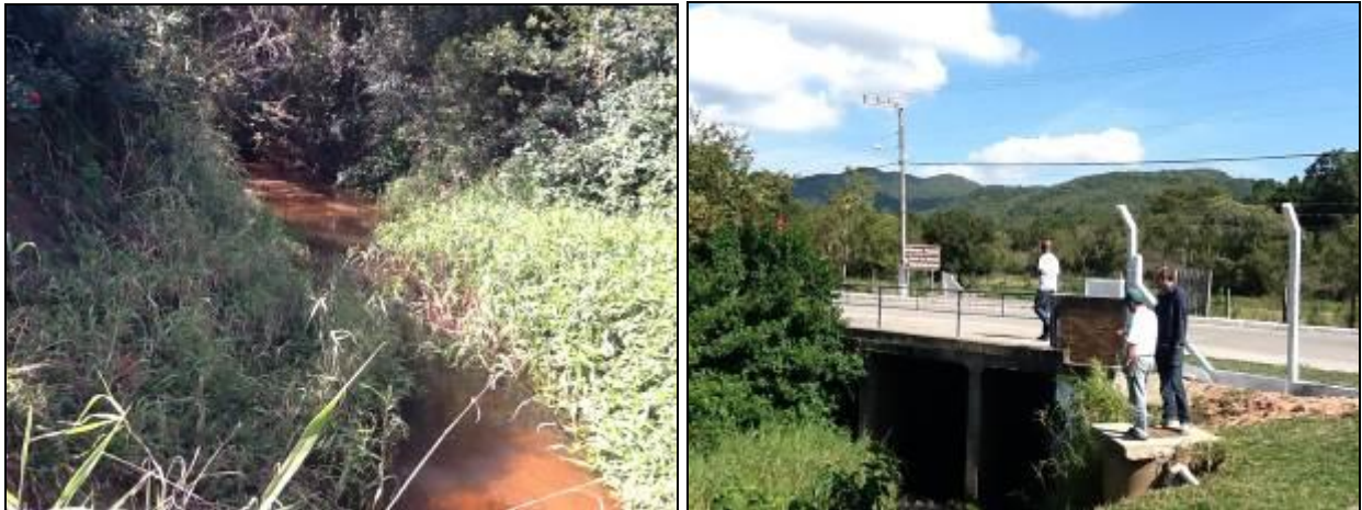
Figura 33 - Área do manancial cercada, porém não identificada (Inicial)
