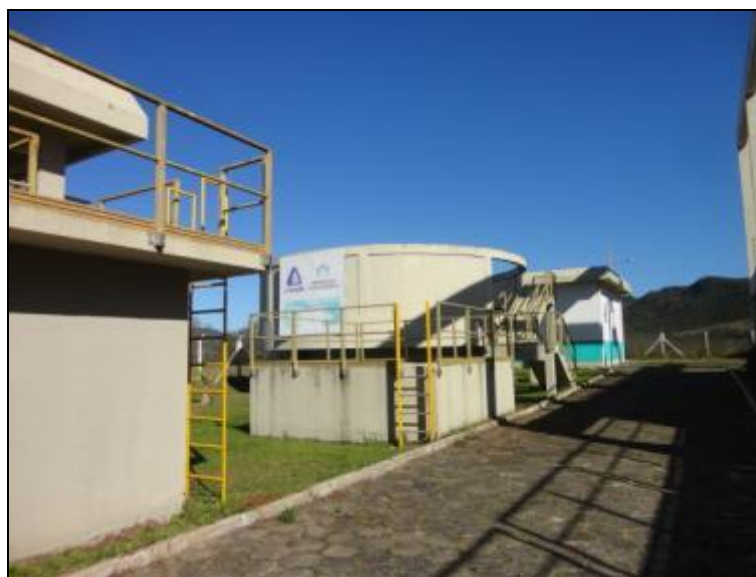
Figura 629- Vista da ETE abandonada
