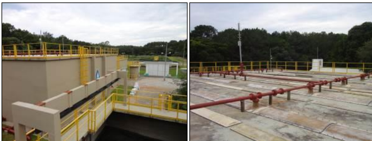
Figura 578 – Reatores UASB (Acompanhamento)
