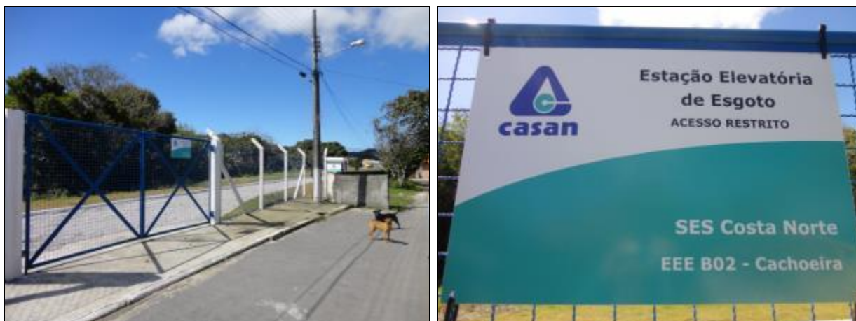
Figura 612- Vista do portão de acesso a EEE B02 Cachoeira com placa de identificação e restrição de acesso
