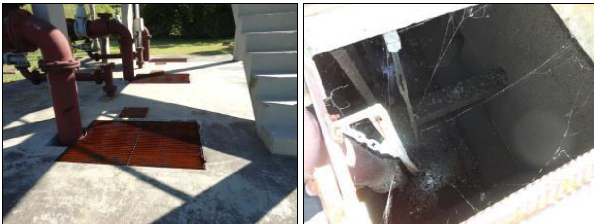
Figura 729- Vista externa e interna do poço úmido
