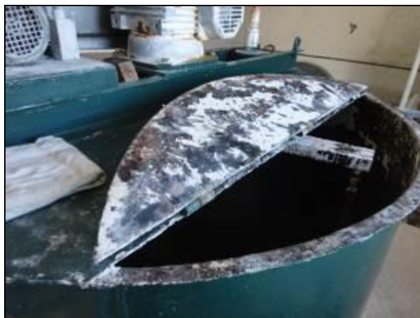
Figura 215 – Casa de química (fora de uso) e armazenamento de produtos químicos. Tanque somente utilizado para misturar Ortopolifosfato (Acompanhamento)
