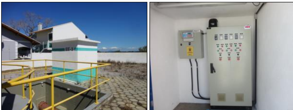
Figura 617- Vista externa e interna da casa de comando
