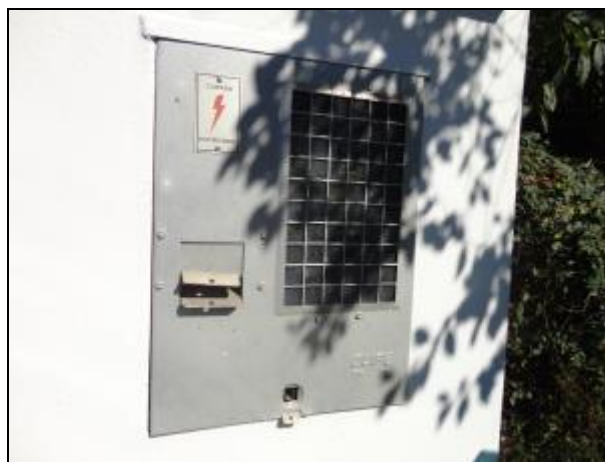
Figura 680- Quadro de comando (à esquerda) e quadro de energia (à direita)
