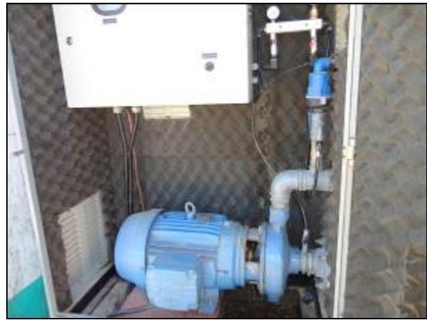
Figura 391- Quadro de energia (à esquerda) e vista interna com bomba e quadro de comando (à direita)
