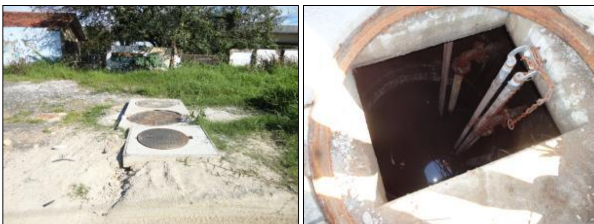
Figura 740- Vista externa e interna do poço úmido
