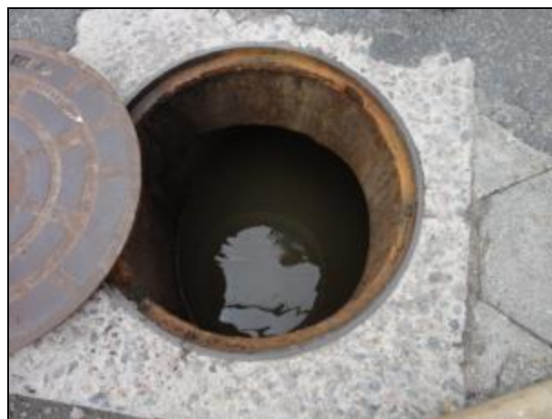
Figura 706- Vista externa e interna do poço úmido
