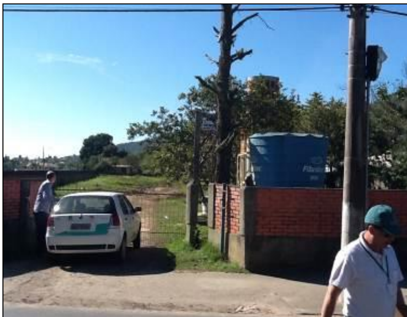
Figura 171 - Portão de acesso à ETA (Inicial)
