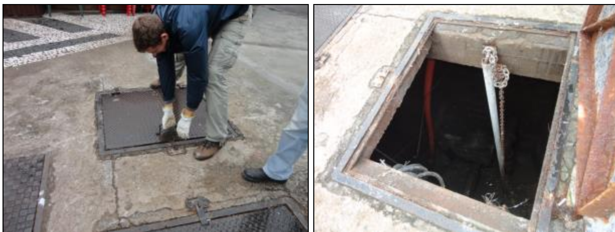
Figura 698- vista externa e interna do poço úmido
