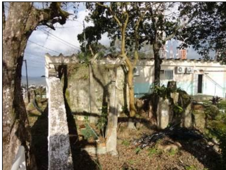
Figura 252 – TV Cultura – Centro – Vista do reservatório desativado (Acompanhamento)
