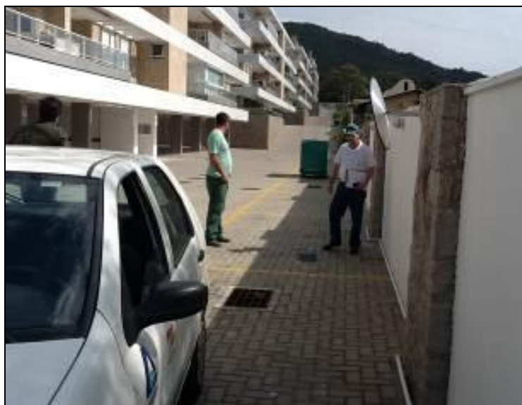
Figura 135 - Poço aguardando conclusão do quadro de força para iniciar operação (Inicial)
