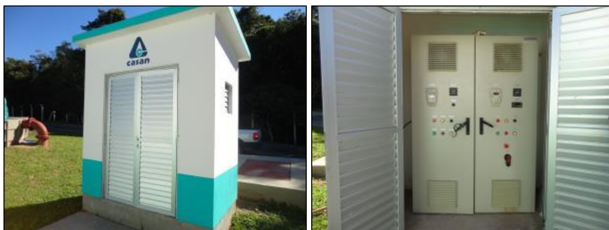
Figura 647- Vista externa e interna da casa de comando
