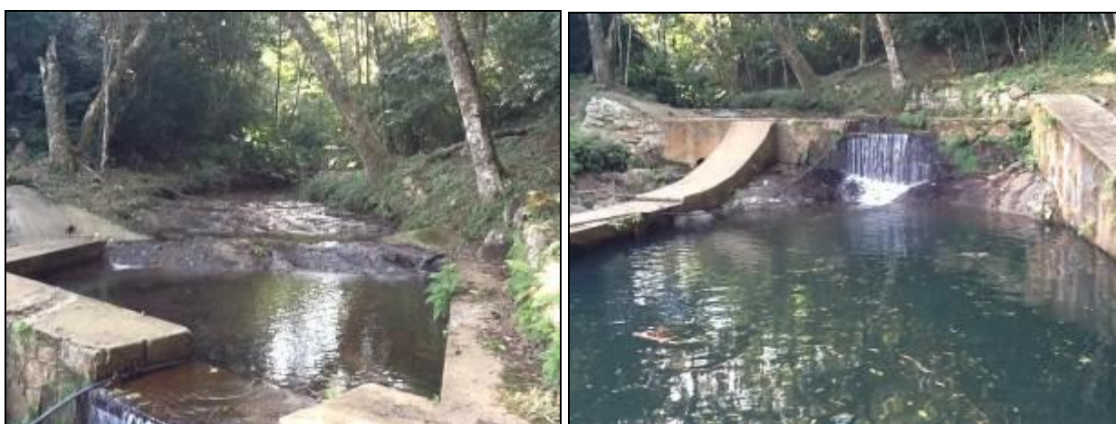
Figura 37 - Área do manancial não está cercada nem identificada (Inicial)
