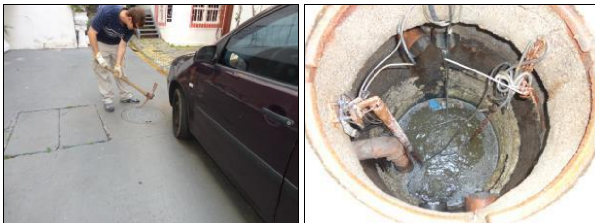
Figura 770- Vista externa e interna do poço úmido
