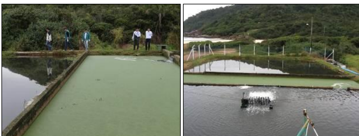
Figura 533 - Lagoas de estabilização (Inicial)
