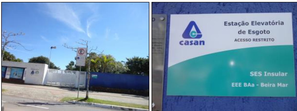
Figura 761- Vista geral da EEE BAa Beira Mar com placa de identificação e restrição de acesso
