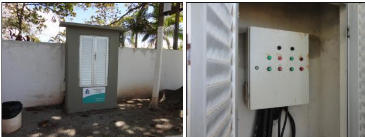
Figura 606- Vista externa e interna da casa de comando
