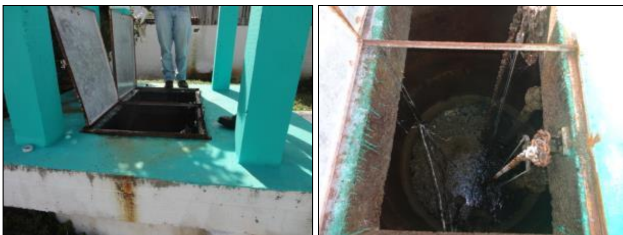
Figura 642- Vista externa e interna do poço úmido
