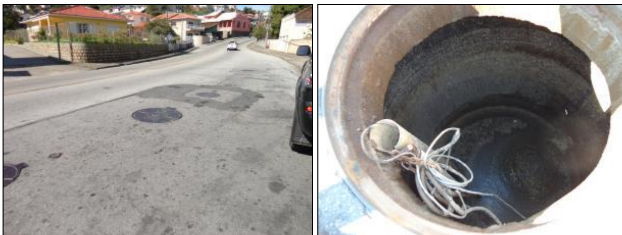
Figura 726- Vista externa e interna do poço úmido
