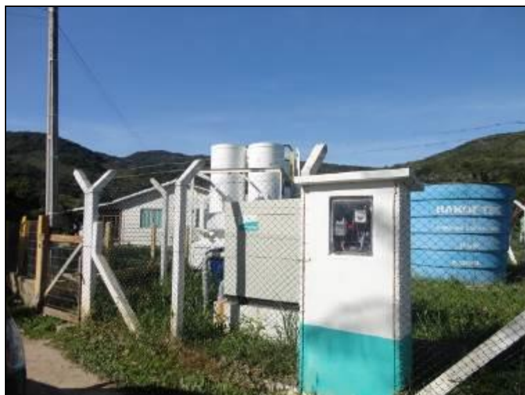
Figura 178 – Parte do cercamento da ETA (Acompanhamento)
