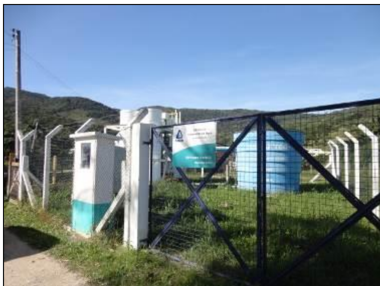
Figura 176 – Panorâmica geral da ETA e portão de acesso (Acompanhamento)
