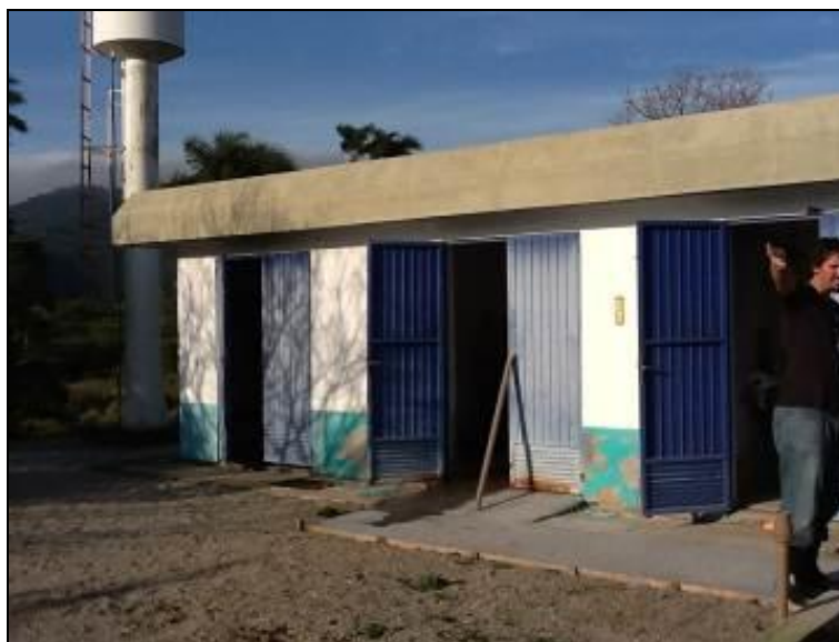
Figura 480 - Prédio de apoio: depósitos e escritório (Inicial)
