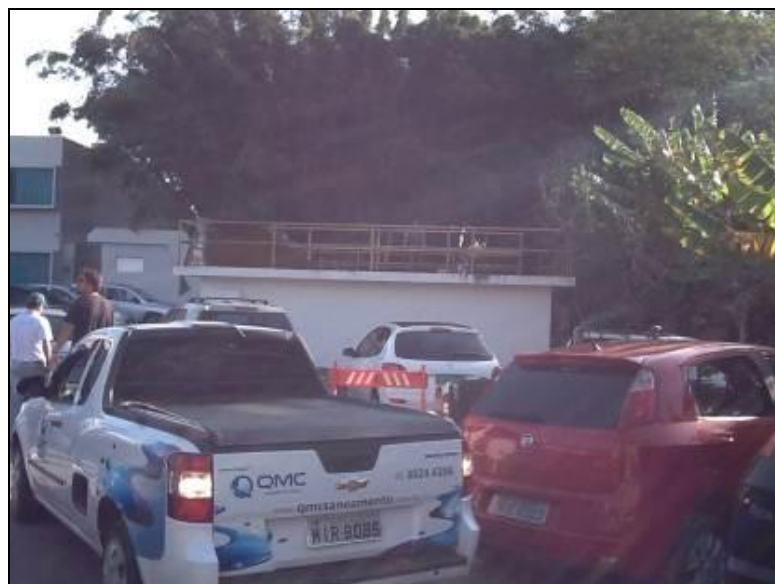
Figura 494 - A ETE está em meio a estacionamentos e sem qualquer isolamento (Inicial)
