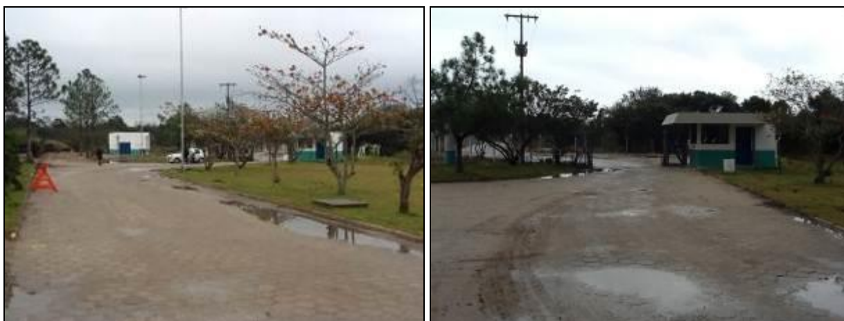
Figura 513 - Áreas de Acesso/Circulação da Estação de Tratamento de Esgotos (Inicial)
