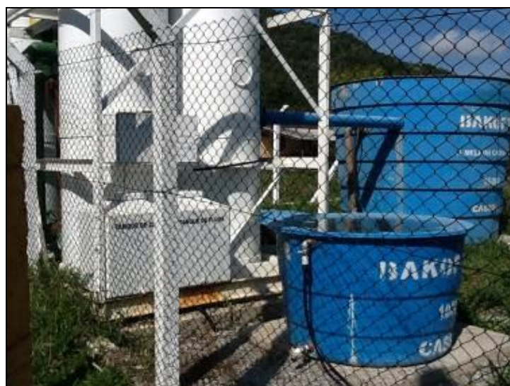
Figura 177 - Parte do cercamento da ETA (Inicial)
