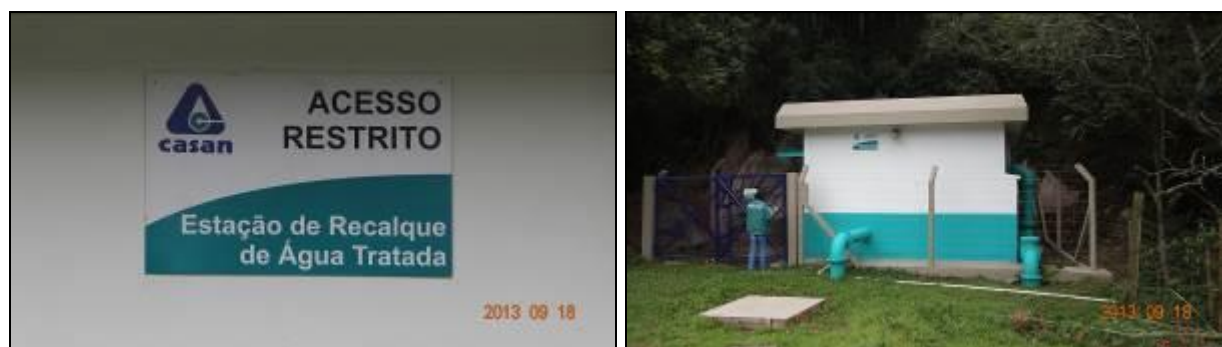
Figura 309- Placa de identificação e vista geral do Booster Canto da Lagoa
