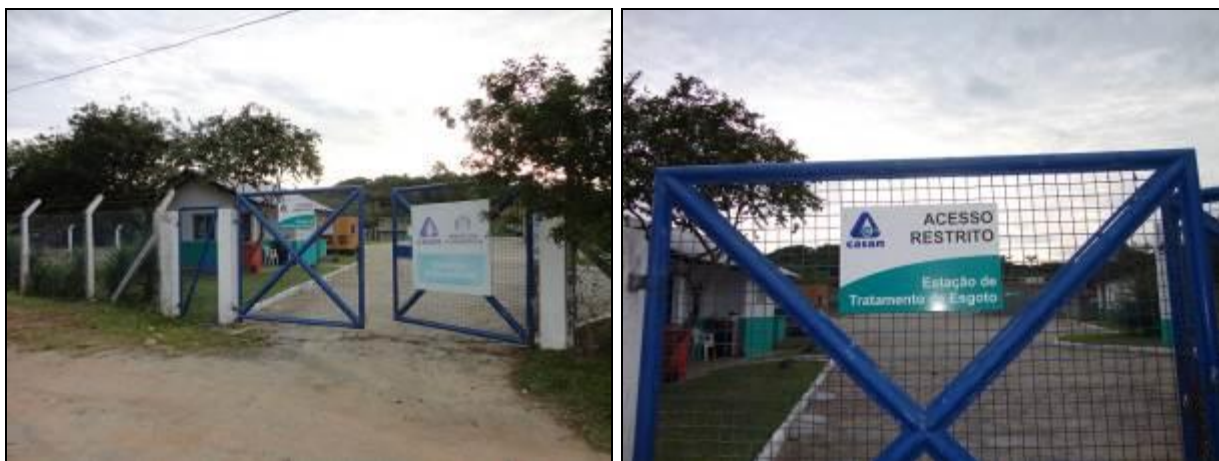
Figura 554 – Portão de entrada da ETE e placa de identificação (Acompanhamento)
