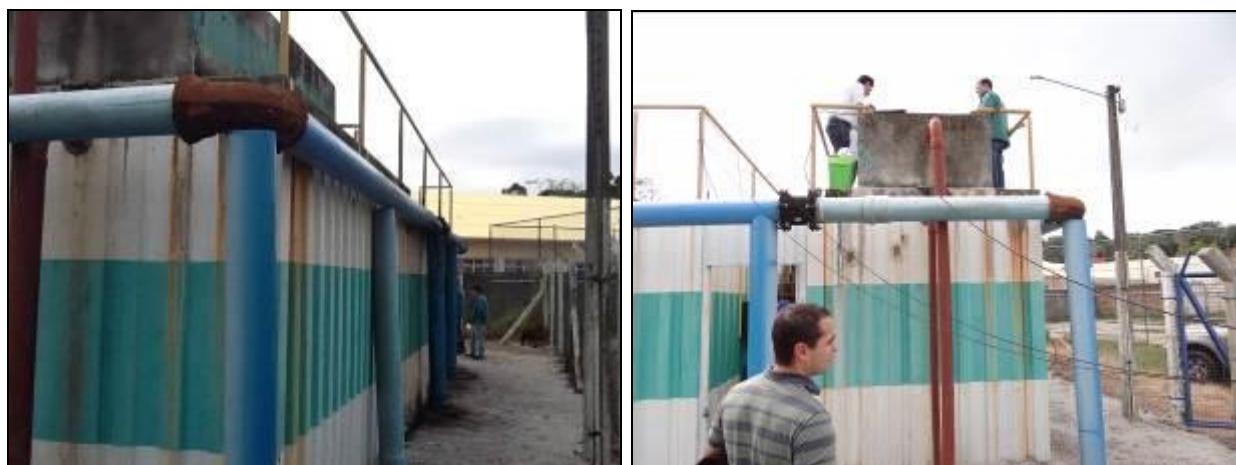
Figura 541 - Estação de Tratamento de Esgotos (Inicial)
