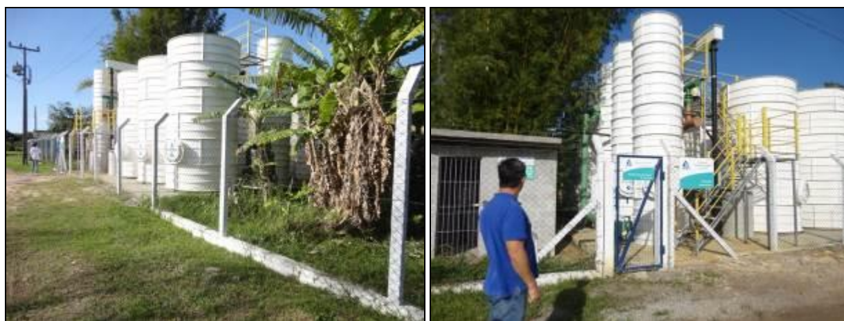
Figura 186 – Fachada e panorâmica geral da ETA (Acompanhamento)
