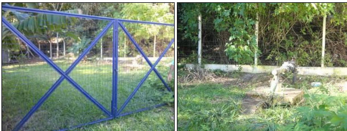
Figura 340- Vista da área do Poço RBS I
