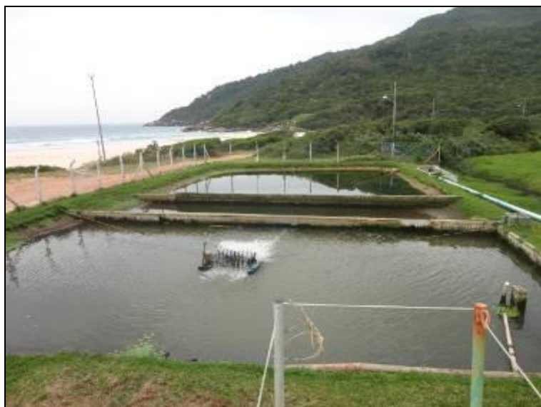
Figura 534 – Lagoas de estabilização (Acompanhamento)
