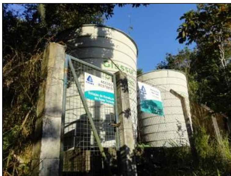
Figura 282 – Reservatório do Forte (Acompanhamento)
