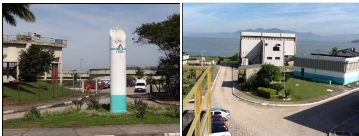
Figura 458 - Acesso e pátio interno da ETE (Inicial)
