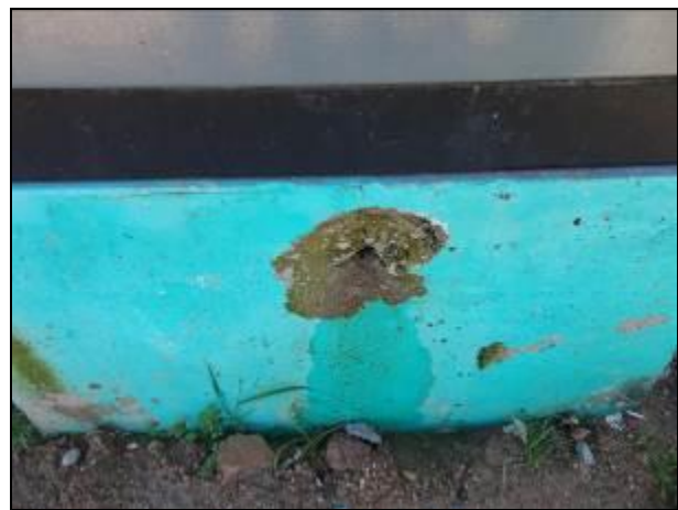
Figura 392- Vazamento na bomba
