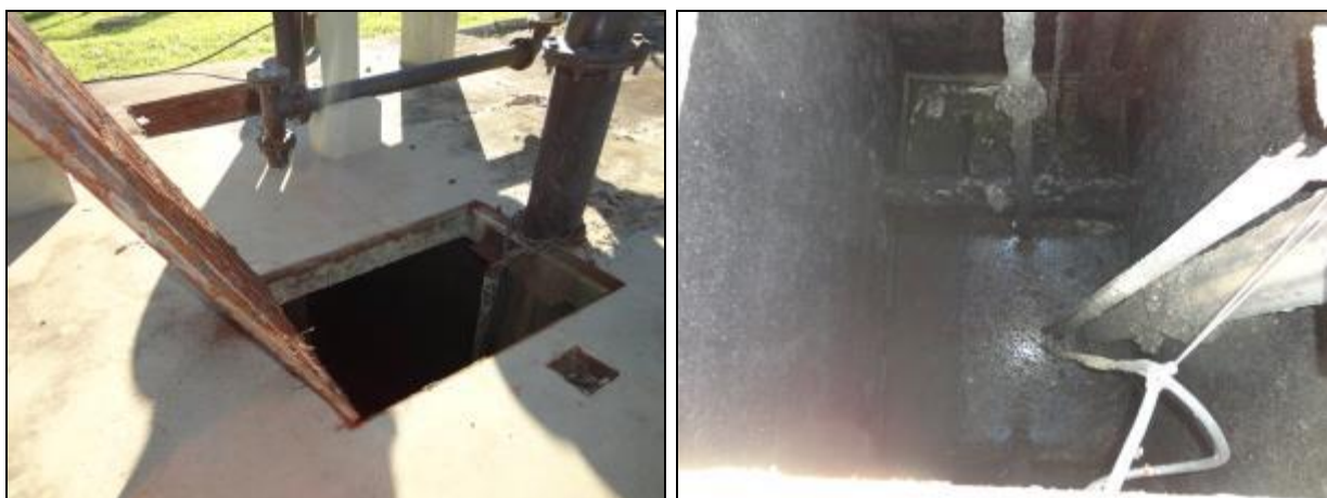
Figura 745- Vista externa e interna do poço úmido
