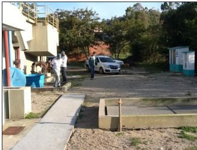
Figura 479 - Acesso e pátio interno da ETE (Inicial)
