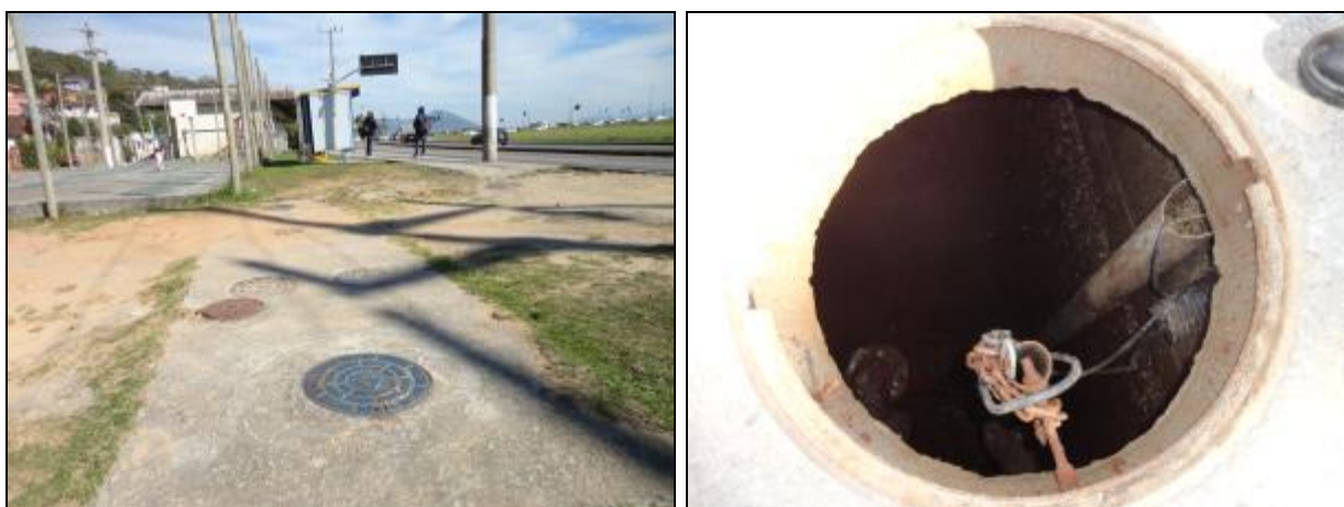
Figura 732- Vista externa e interna do poço úmido
