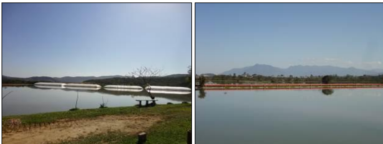
Figura 588 - Imagens das lagoas de decantação da ETE – Potecas (Inicial)
