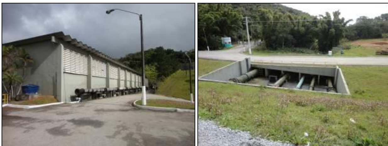
Figura 151 - Panorâmicas internas da ETA (Acompanhamento)
