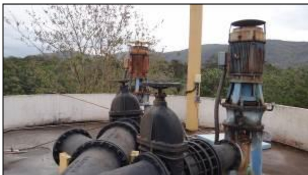
Figura 316- Bombas (à esquerda) e chegada da água bruta (à direita)
