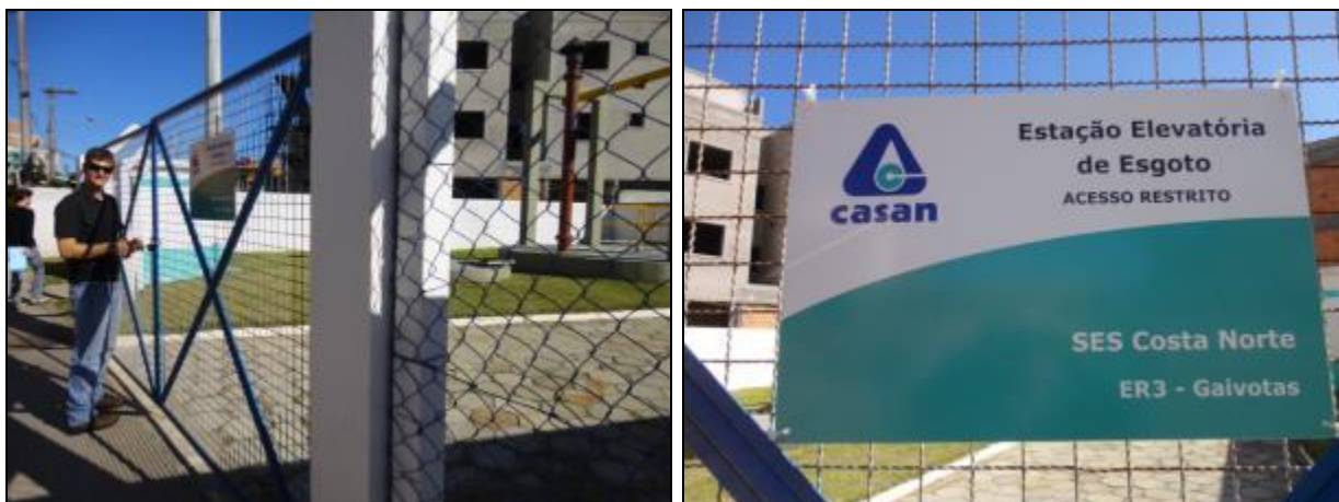
Figura 631- Vista da EEE ER3 Gaivotas com placa de identificação e restrição de acesso
