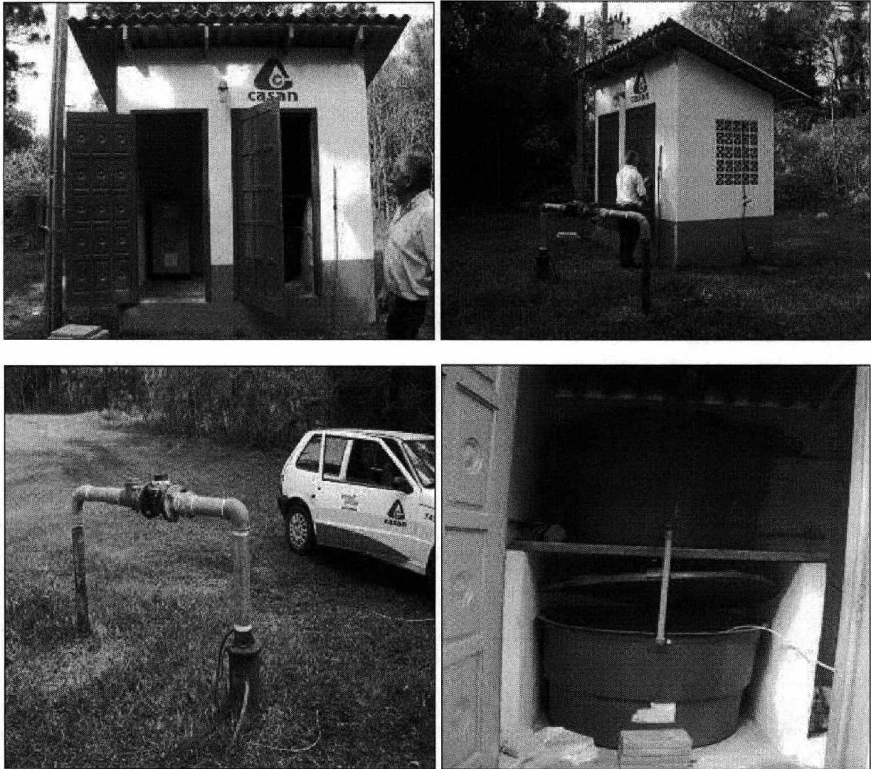
Figura 3: Captação - Poço 02- 27m 3 /h (Inicial)
