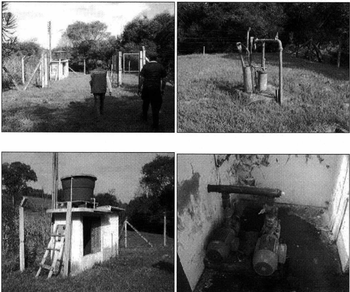
Figura 1: Captação – Poço 01- 8 m 3 /h (Inicial)
