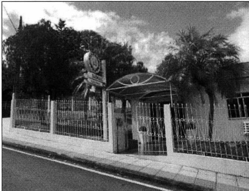
Figura 4: Fachada do Escritório do SAMAE
