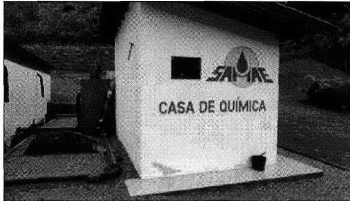
Casa de Química da ETA.
