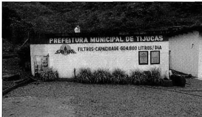
Fachada da ETA
