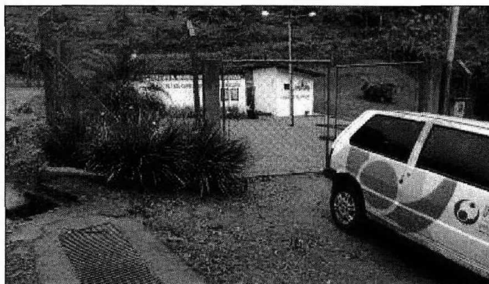
Cerca de Proteção da ETA
