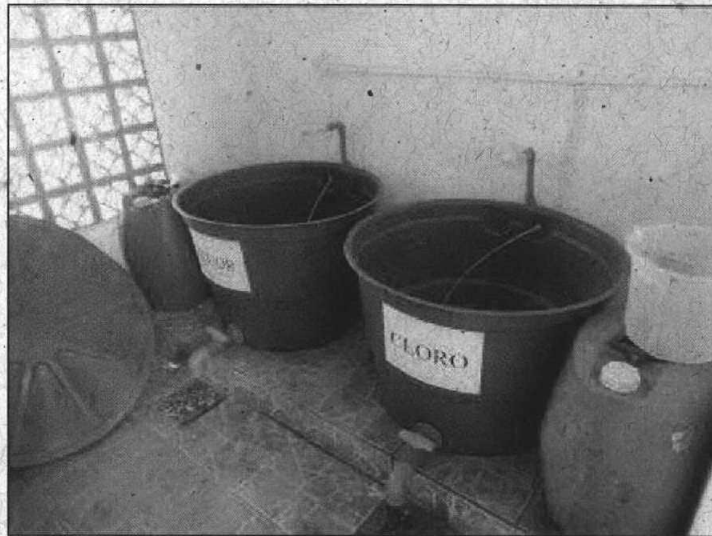
Casa de Química da ETA
