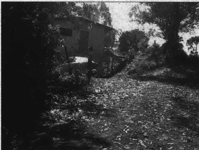
Acesso e entrada da ETA
