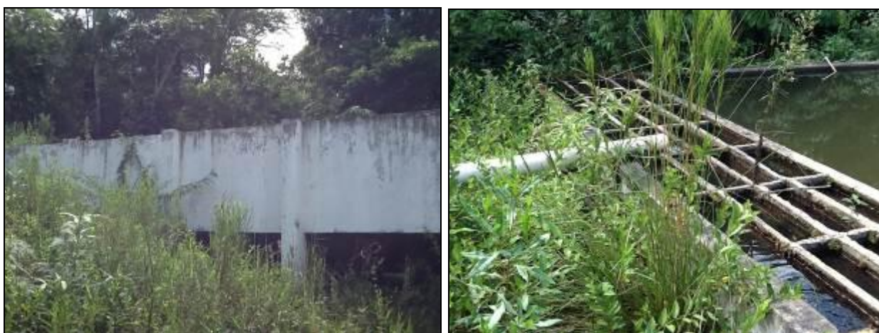
Figura 3: Área de captação do Rio Cocal.
