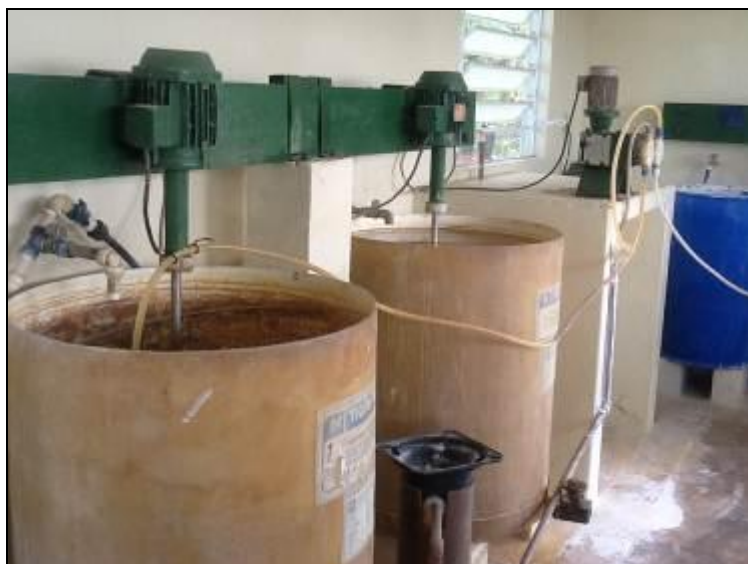
Casa de Química da ETA.
