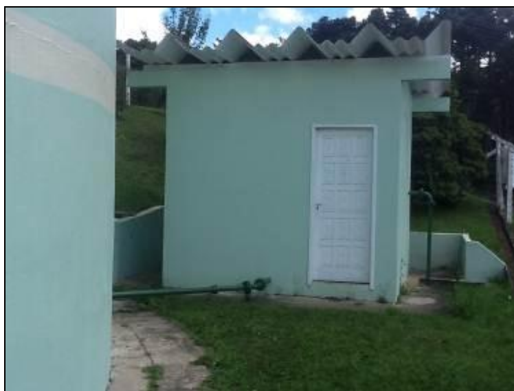
Fachada da ETA
