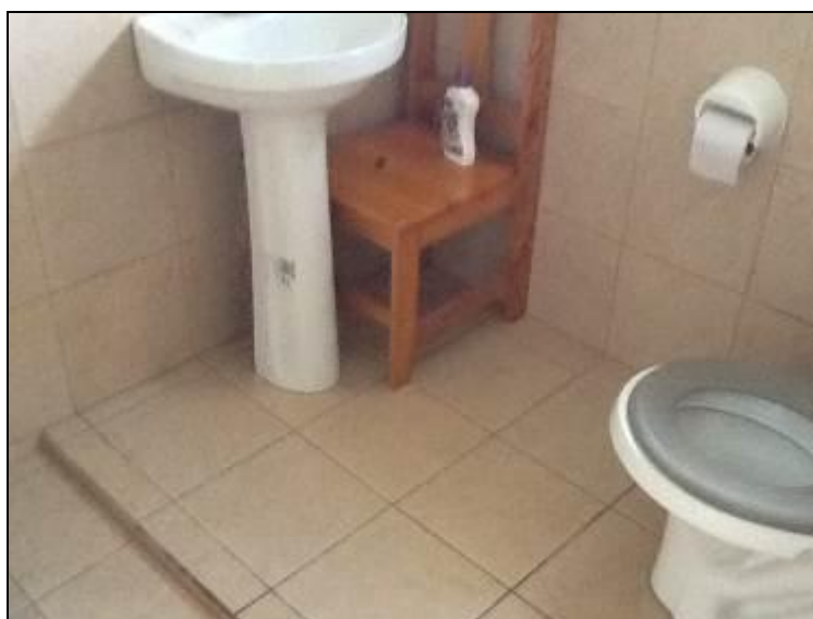
Sanitário do Escritório.
