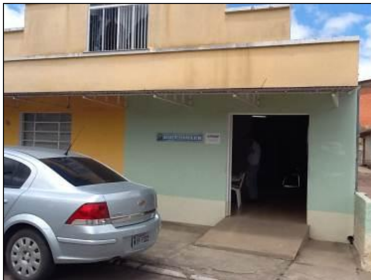
Fachada do Escritório.
