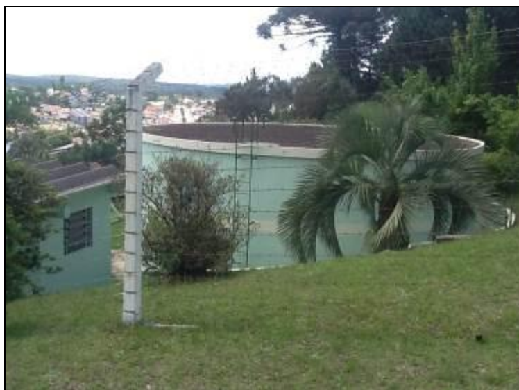
Cerca de Proteção da ETA
