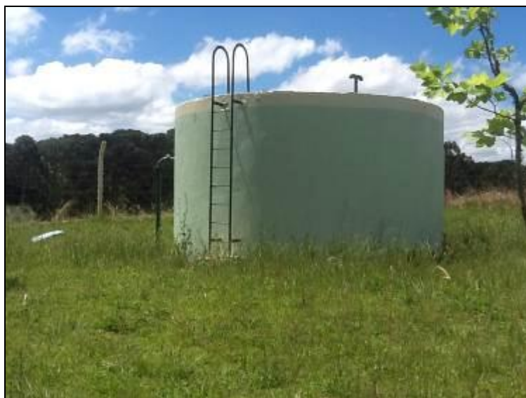
Escada de Acesso
