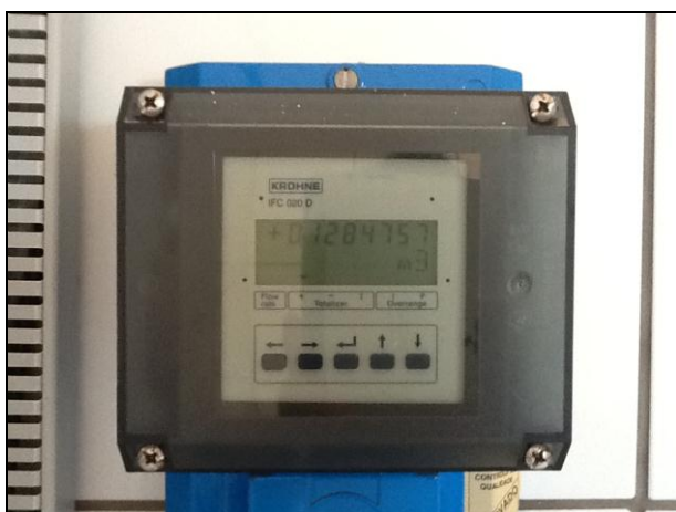
Macromedidor de saída da ETA e relatórios de controle.
