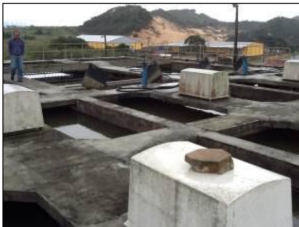
Floculadores necessitando melhorias.
