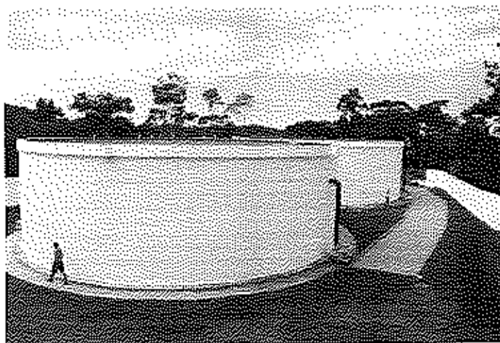
Figura 8 - Reservatório R3 localizado na Rua Venezuela (©Assessoria de Imprensa/EMASA).
