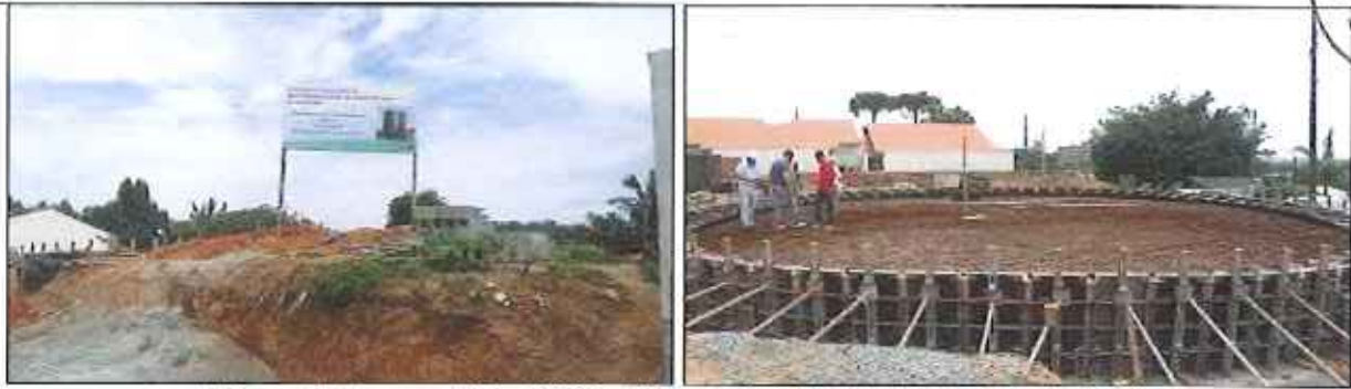
Figura 4: Reservatório 2.000 m 3 (Fiscalização de dezembro de 2014)
