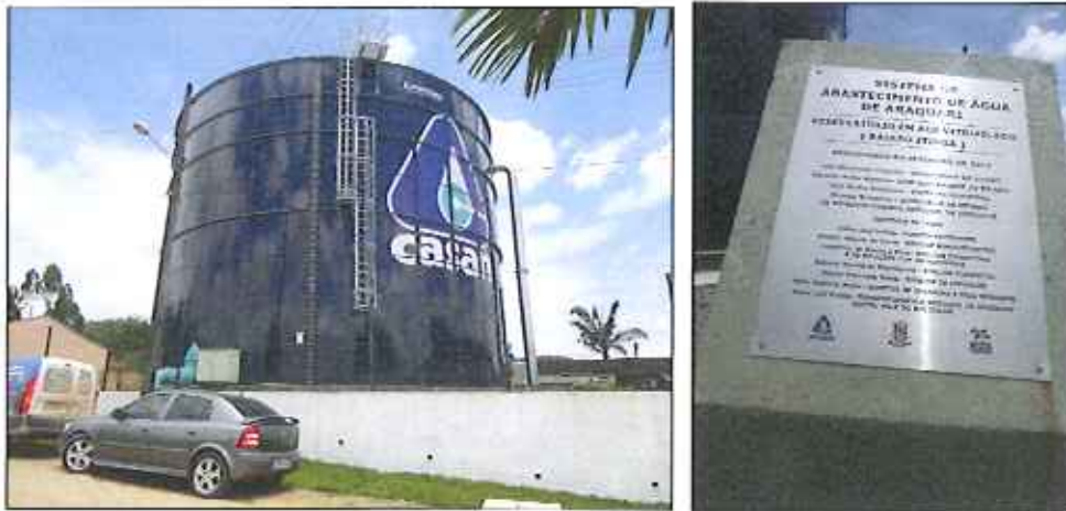
Figura 5: Reservatório 2.000 m 3 (Fiscalização de dezembro de 2015)
