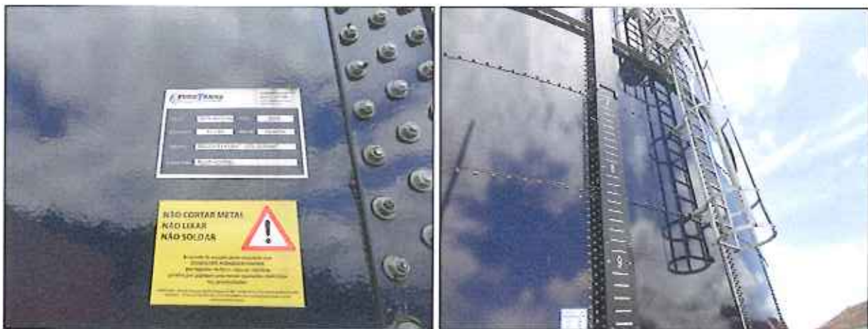
Figura 6: Reservatório 2.000 m 3 (Fiscalização de dezembro de 2015)
