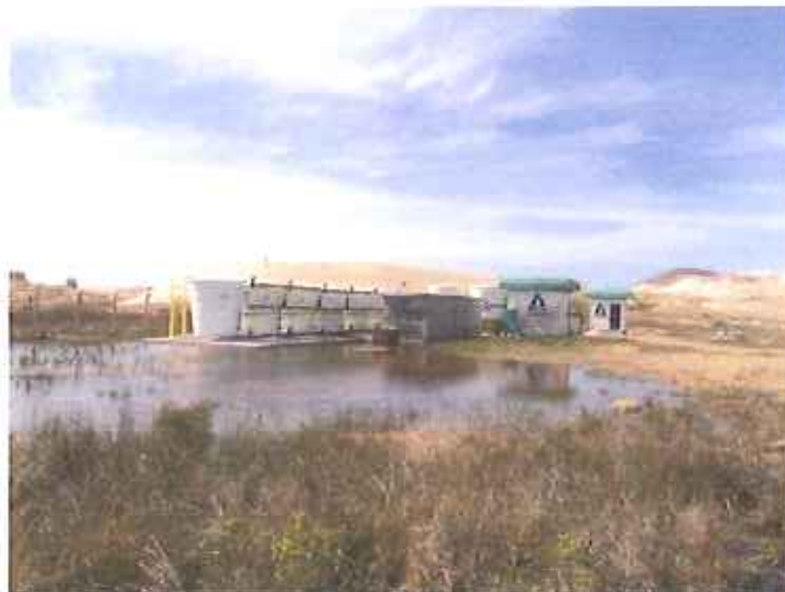
Imagem 4 e Foto 3 - Captação e Casa de Química do Farol de Santa Marta
