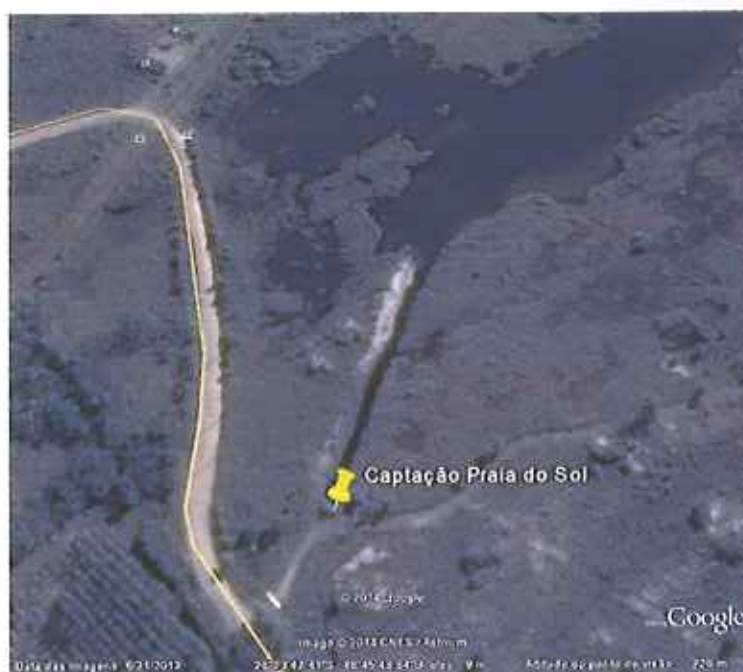
Imagem 5 - Captação da Praia do Sol
