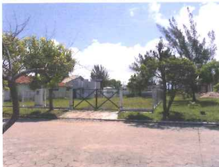
Imagem 6 e Foto 4 - ETA da Praia do Sol
