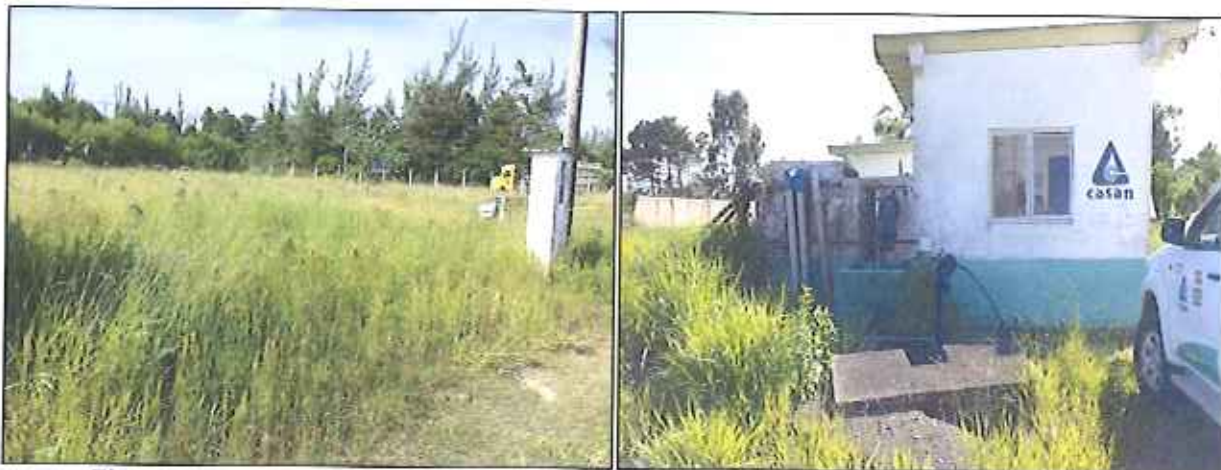
Figura 5: Falta de limpeza e de retirada de vegetação na ETA Itapirubá (05/04/2016)
