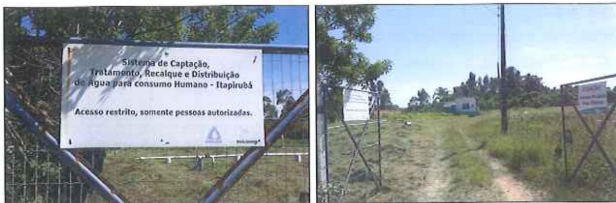
Figura 1: Entrada da ETA e área de captação de Itapirubá, cuja responsabilidade é da concessionária de Laguna (05/04/2016)
