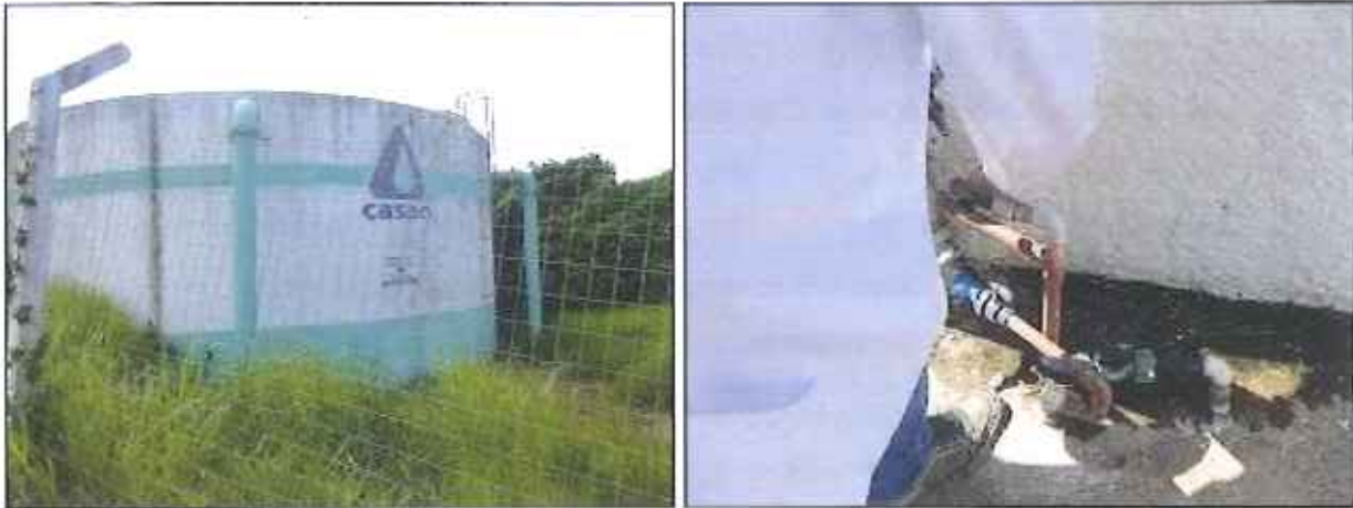
Figura 6: Coleta de amostra de água no Reservatório R02 Morro da Glória
