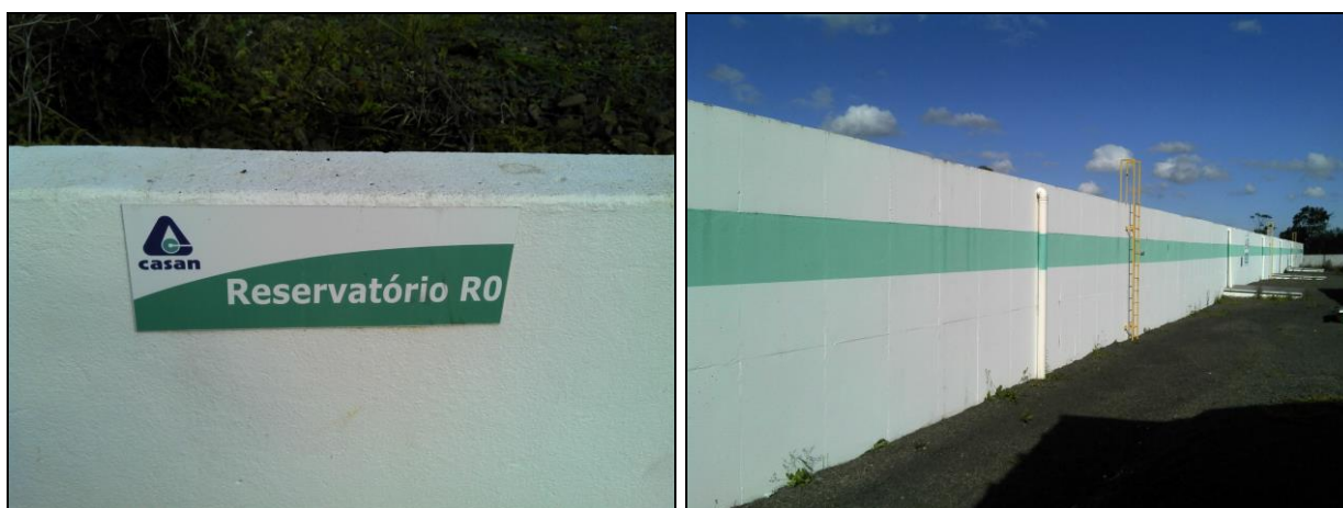
Figura 5: Reservatório 00 + Reservatório Pulmão (GEFIS 038/2015)
