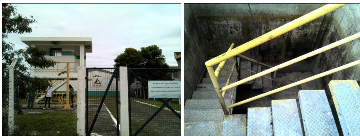
Figura 31: Estação Elevatória de Esgoto Santa Augusta (GEFIS 038/2015)
