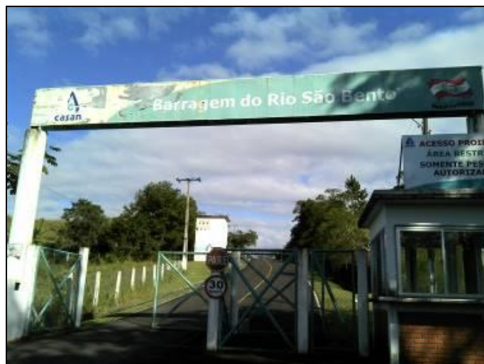
Figura 2: Portão de acesso monitorado por câmeras e abertura remota do portão (GEFIS 038/2015)
