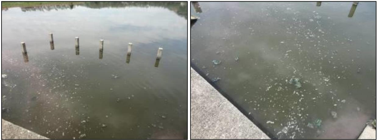
**Figura 2: Material sobrenadante nas lagoas**
