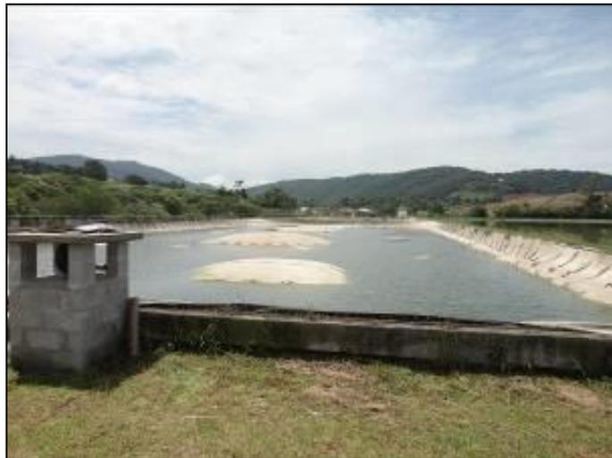
**Figura 3: Reatores com a lona rompida**
