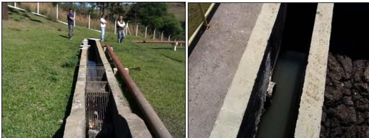
Estruturas de recepção.
