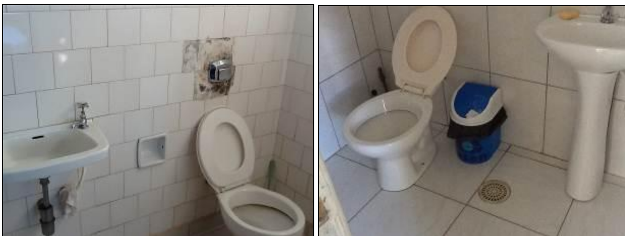
Sanitários de unidades da estrutura de São Joaquim.
