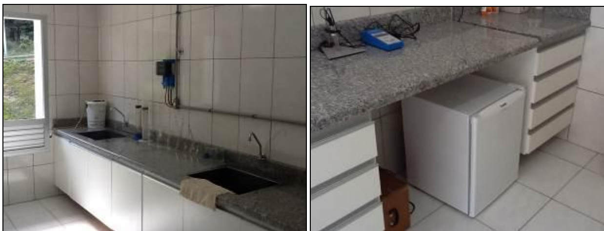
Aspecto geral do laboratório da ETE.
