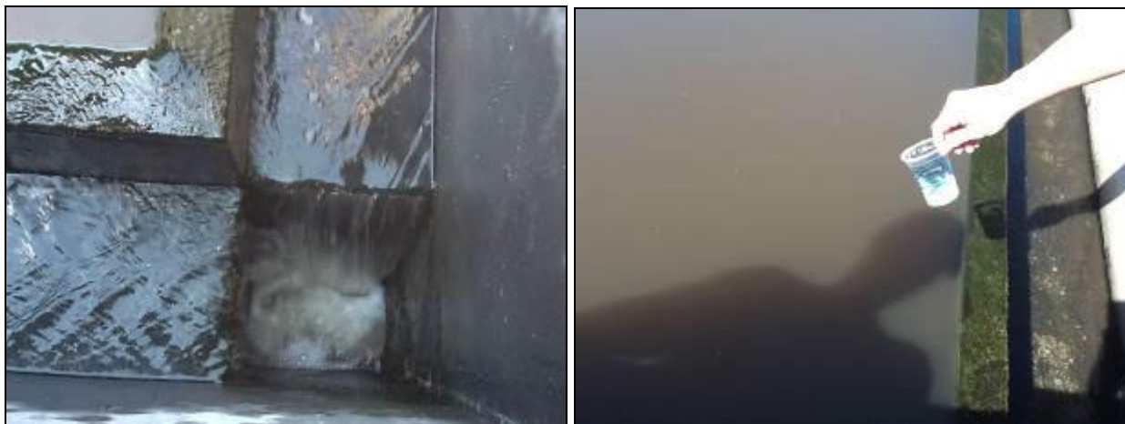
Saída do efluente e condição da água de saída.
