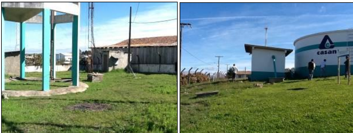
Áreas de entorno dos Reservatórios do SAA São Joaquim.
