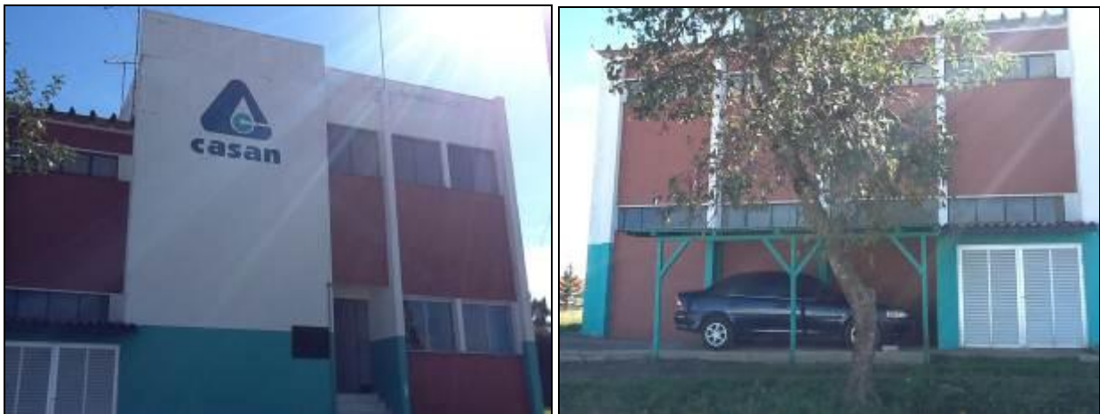
Fachada da ETA
