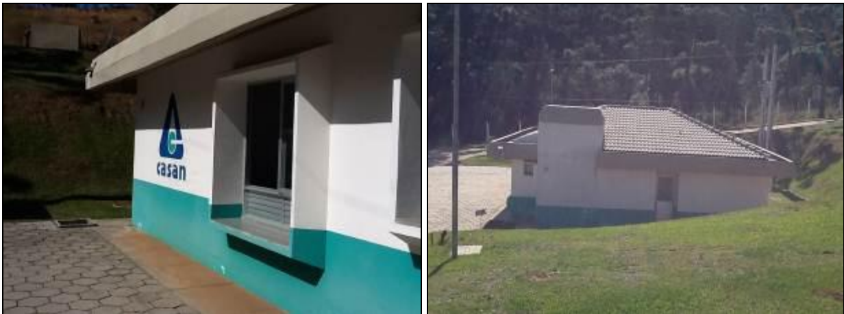
Prédio que serve ao laboratório da ETE.
