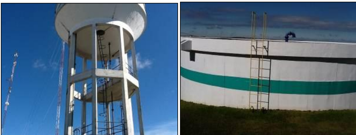
Escadas de acesso a cobertura dos Reservatórios.
