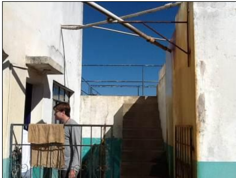
Escadas que dão acesso ao tratamento físico da ETA.
