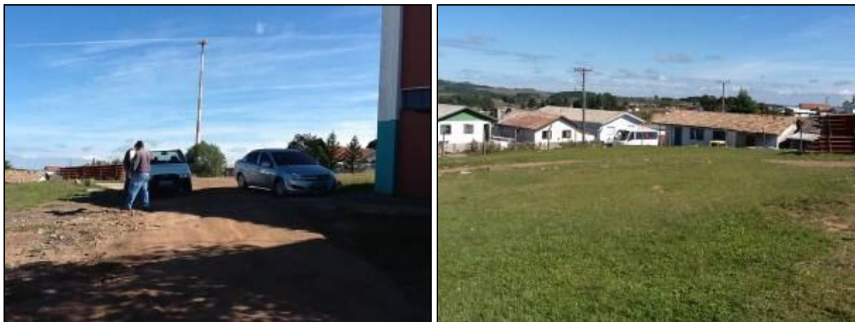
Acessos da ETA São Joaquim.
