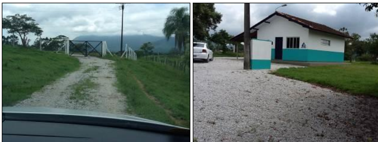
Figura 50: Vista da entrada e estação de controle da ETE de Santo Amaro da Imperatriz. (Acompanhamento I)
