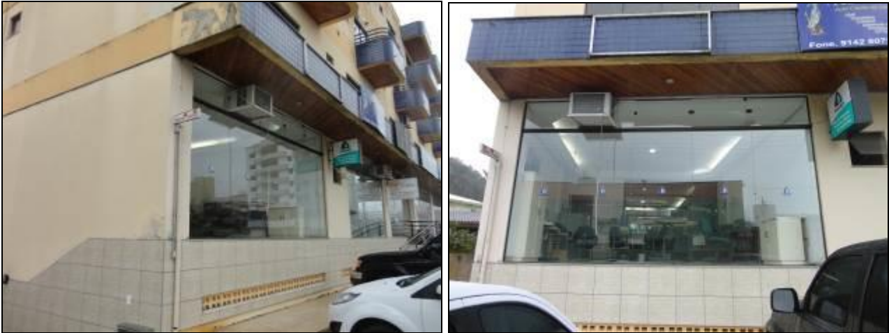
Figura 3: Fachada Escritório (Acompanhamento II)
