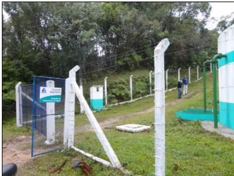
Figura 24: Acesso a ETA junto ao Reservatório (Acompanhamento II)
