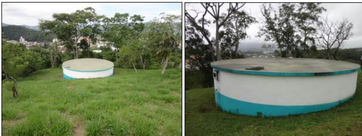
Figura 33: Cobertura em boas condições. (Acompanhamento I e II)
