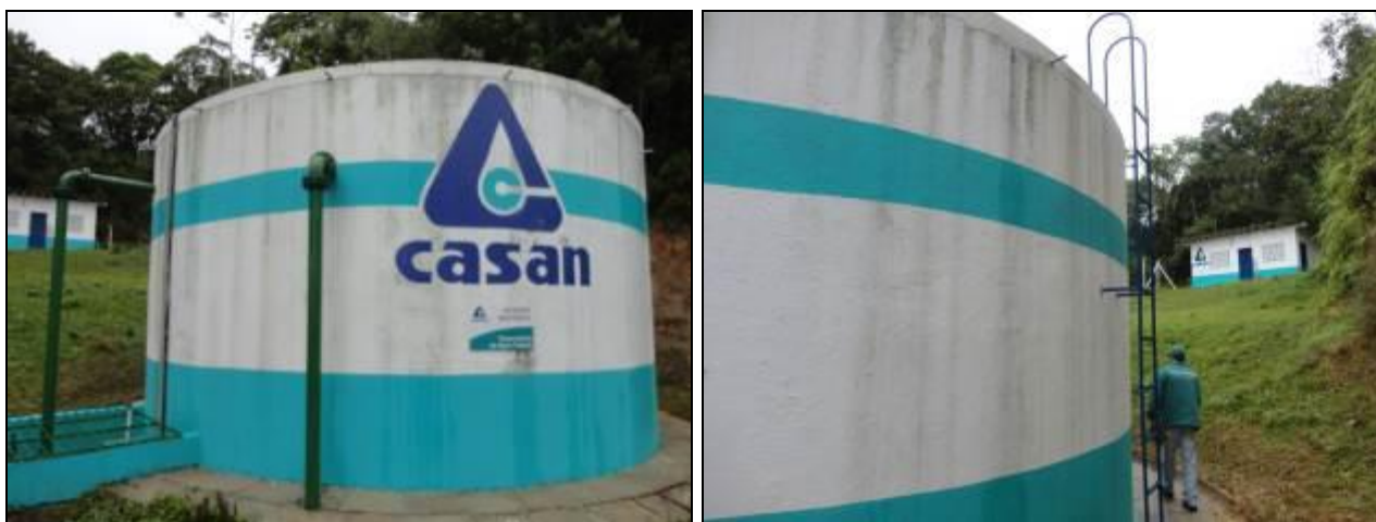
Figura 34: Reservatório de Caldas (Acompanhamento II)
