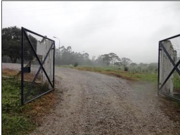
Figura 53: Acesso a ETE (Acompanhamento II)
