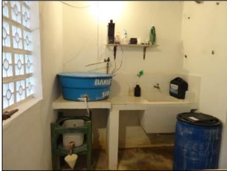
Figura 27: Interior da Casa de Química
