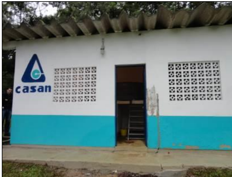
Figura 23: Fachada da ETA Caldas da Imperatriz
