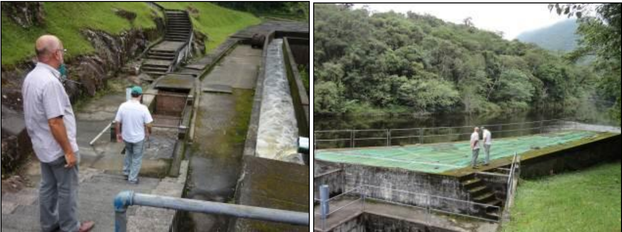
Figura 15: Imagens da área de captação de Pilões (Acompanhamento I)
