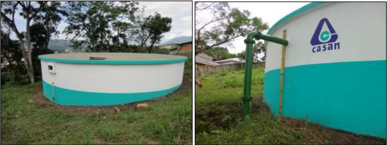
Figura 28: Imagens do Reservatório (R-01) que serve ao SAA de Santo Amaro da Imperatriz (Acompanhamento I)
