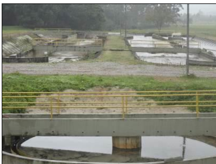
Figura 57: Vista geral da ETE (Acompanhamento)
