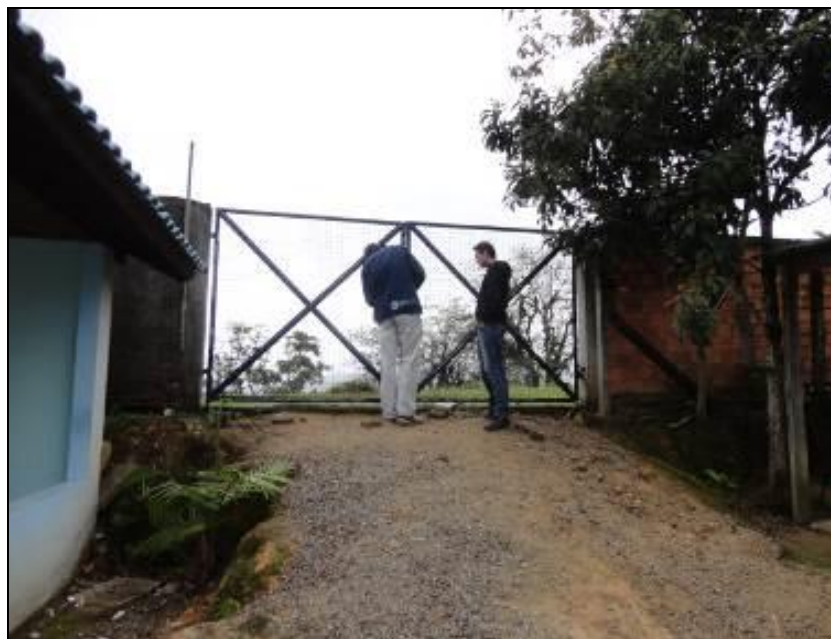
Figura 31: Portão e muros foram consertados (Acompanhamento II)
