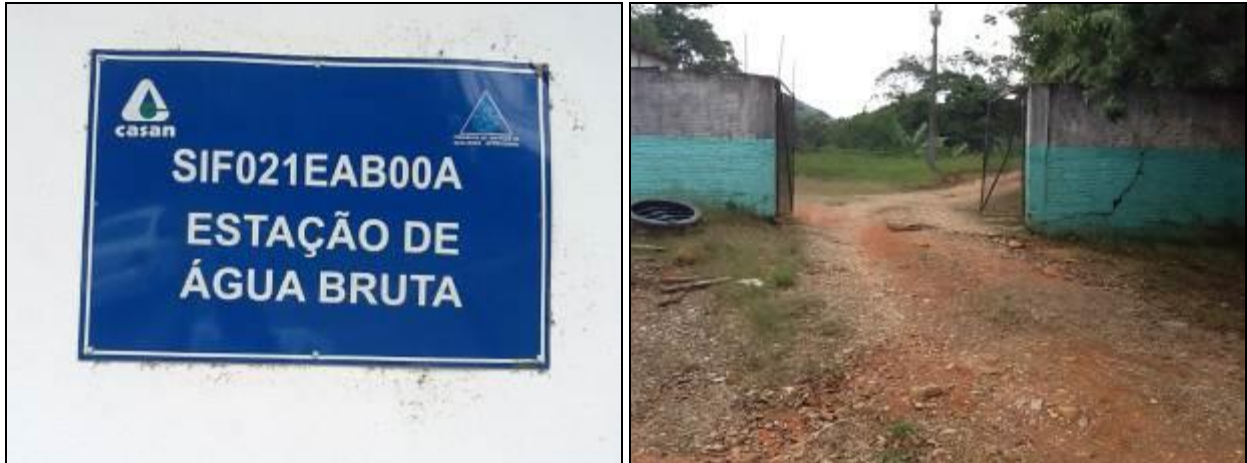
Figura 14: Placa de identificação da Unidade à esquerda e Portão de acesso que se localiza longe da área de captação, está em condições ruins e não oferece segurança. (Acompanhamento I)
