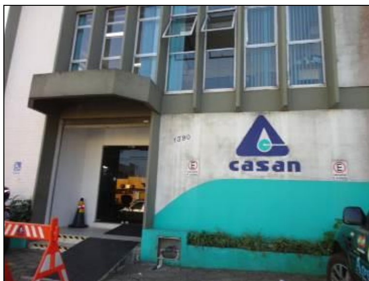
Figura 43: Fachada atual (Acompanhamento)
