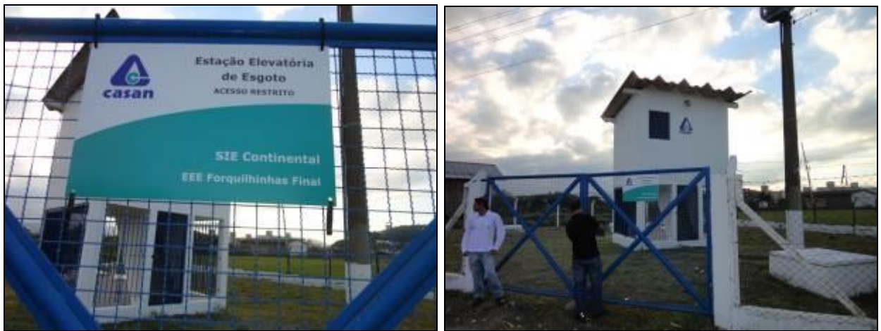
Figura 32: Elevatória Forquilha Final (Acompanhamento)
