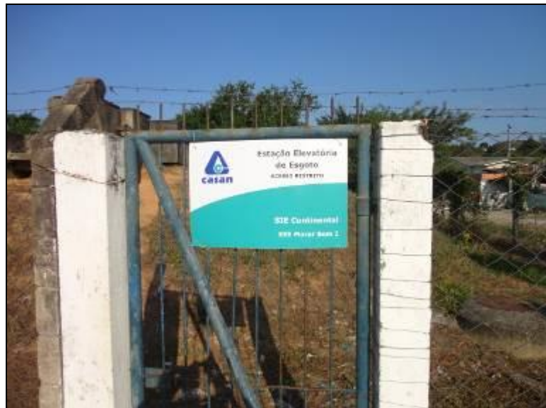
Figura 34: Elevatória Morar Bem I
