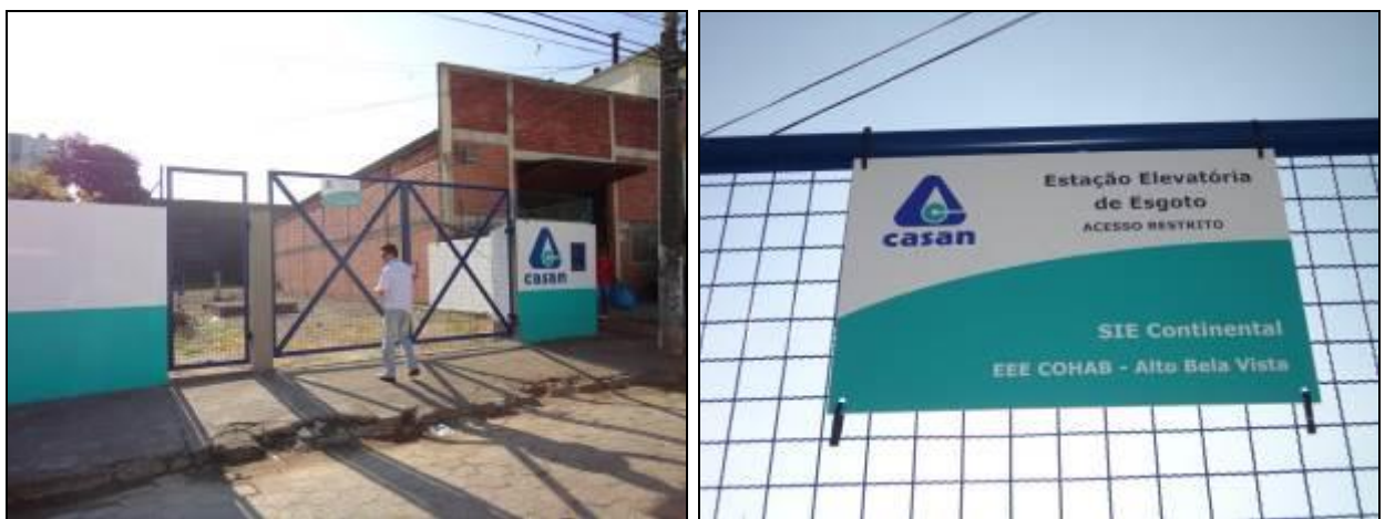
Figura 33: Elevatória COHAB Bela Vista (Acompanhamento)
