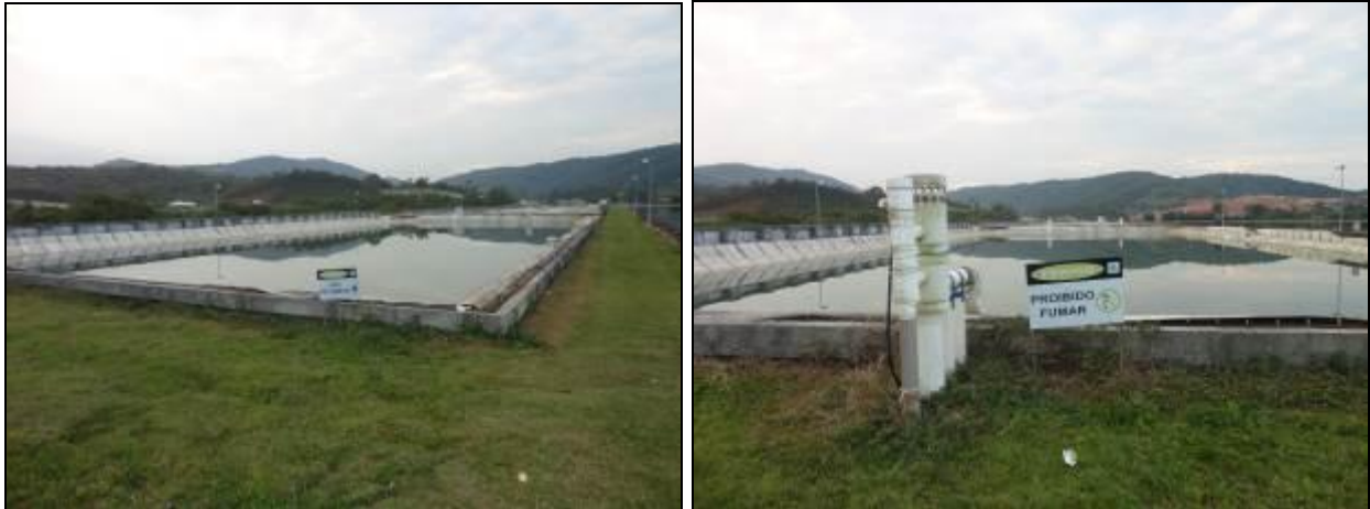
Figura 24: Reatores danificados e inativos (Acompanhamento)
