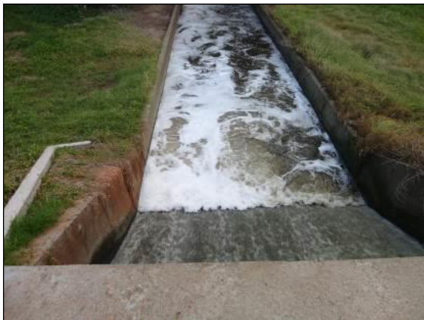
Figura 39: Efluente Final (Acompanhamento)
