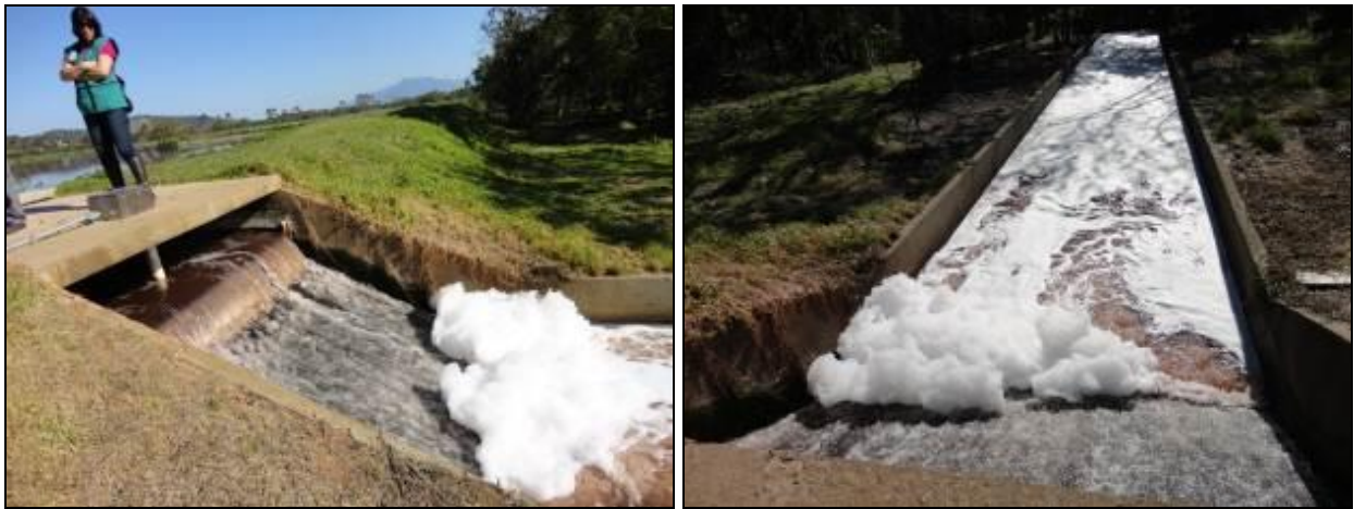
Figura 38: Saída dos efluentes para o Rio Forquilha. (Inicial)
