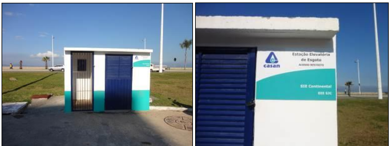
Figura 25: Elevatória EEE-SJC – Continental (Acompanhamento)
