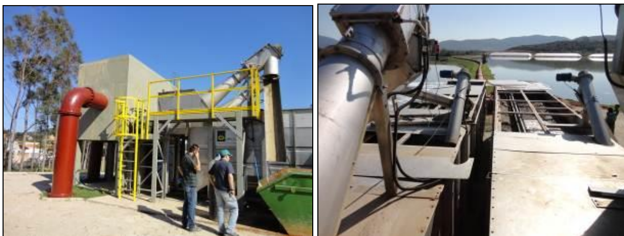
Figura 21: Equipamento de tratamento inicial do esgoto na entrada da ETE: separação de sólidos. (Inicial)
