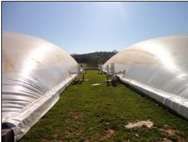
Figura 23: Sistema de recuperação de gás metano: projeto em vias de conclusão. (Inicial)
