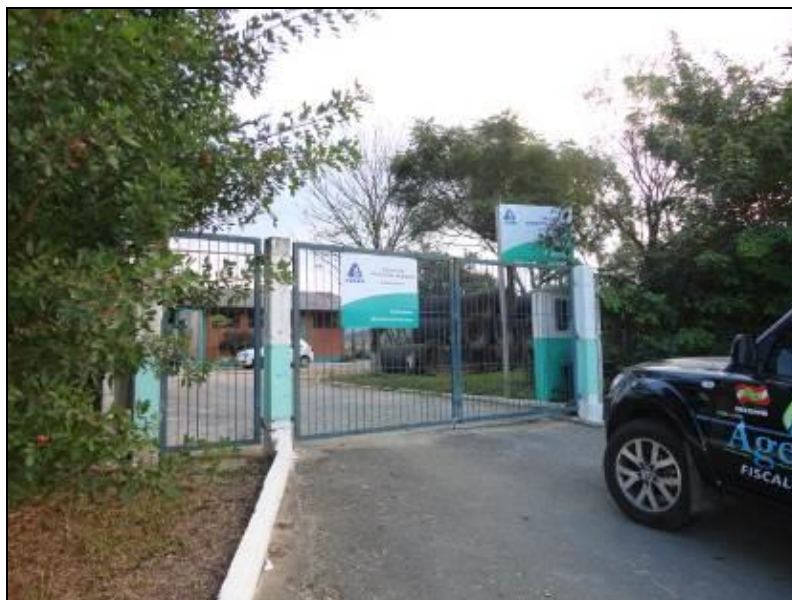
Figura 35: Fachada identificada da ETE Potecas (Acompanhamento)
