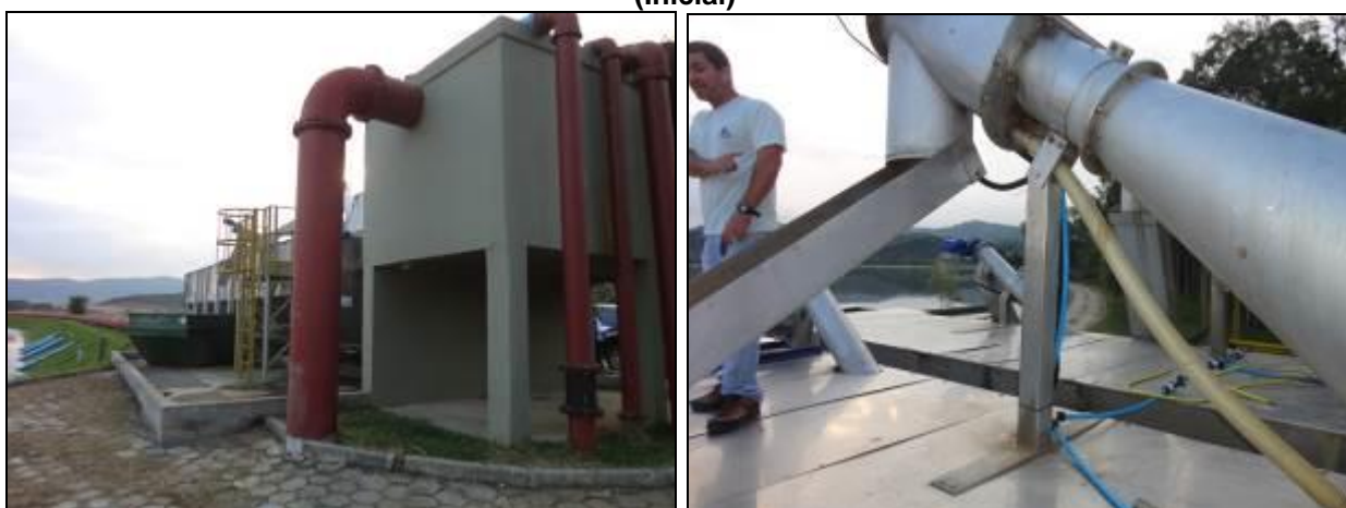
Figura 21: Equipamento de tratamento inicial do esgoto na entrada da ETE: separação de sólidos. (Inicial)
