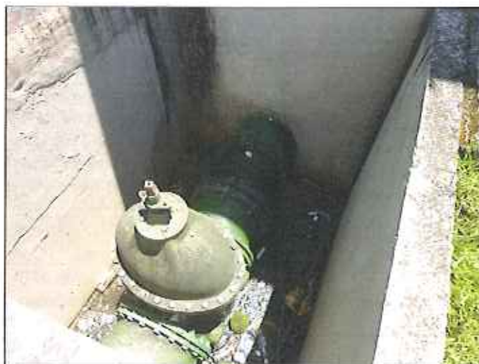
Figura 17: Ausência de gradeamento no espaço onde se localiza o registro do Reservatório Forquilhas
