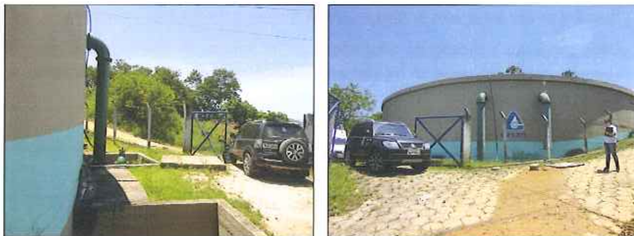
Figura 16: Ausência de Isolamento da área do Reservatório Forquilhas
