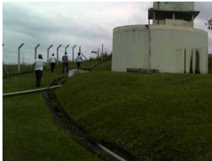
Fiscalização Inicial no Sistema de Abastecimento de Água no dia 17/11/2015 – Águas de Campo Alegre
