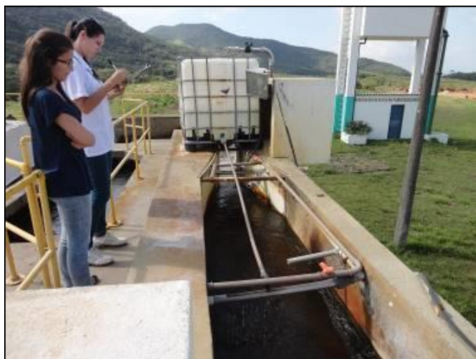
Figura 11: Calha Parshall
