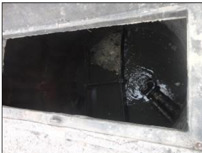
Figura 51: Chegada do efluente bruto
