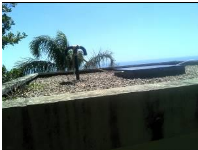
Figura 36: Cobertura do reservatório
