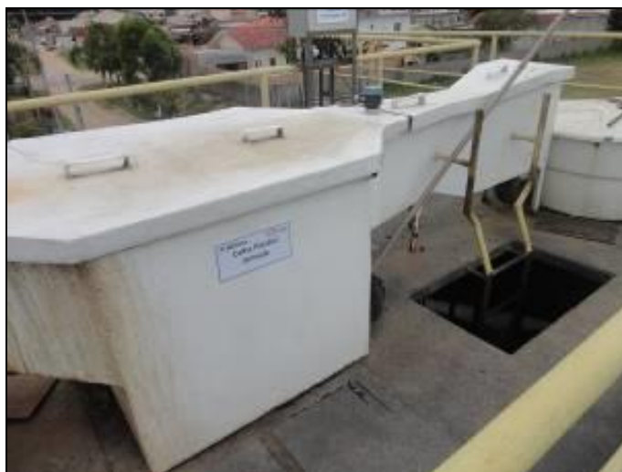
Figura 52: Calha Parshall e macro medidor
