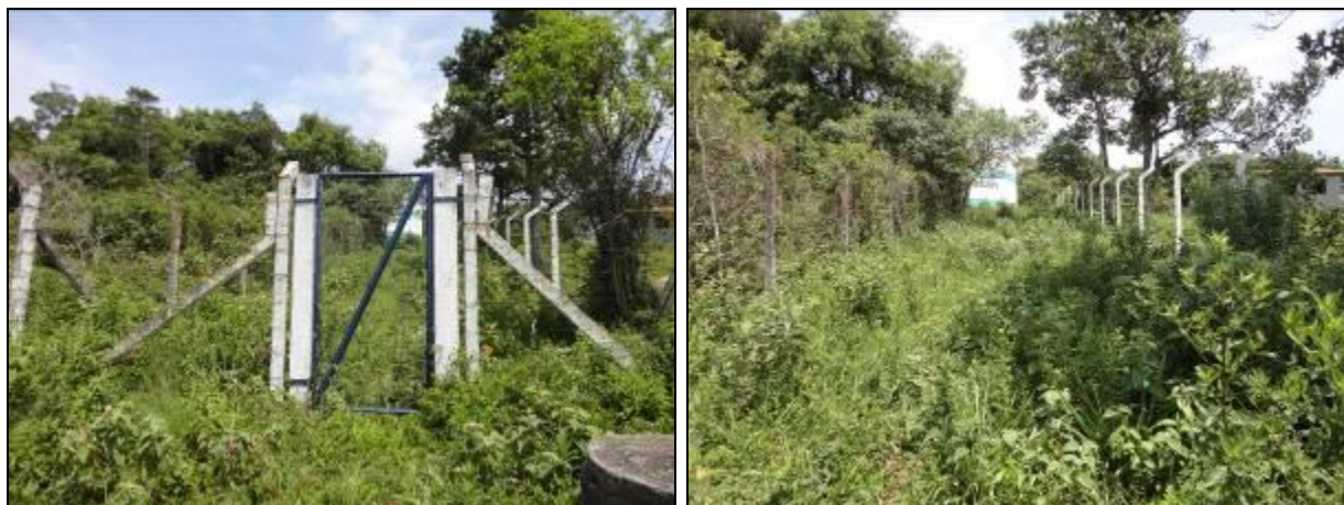
Figura 39: Acesso ao reservatório
