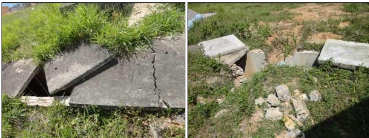
Figura 20: Condições de limpeza do entorno
