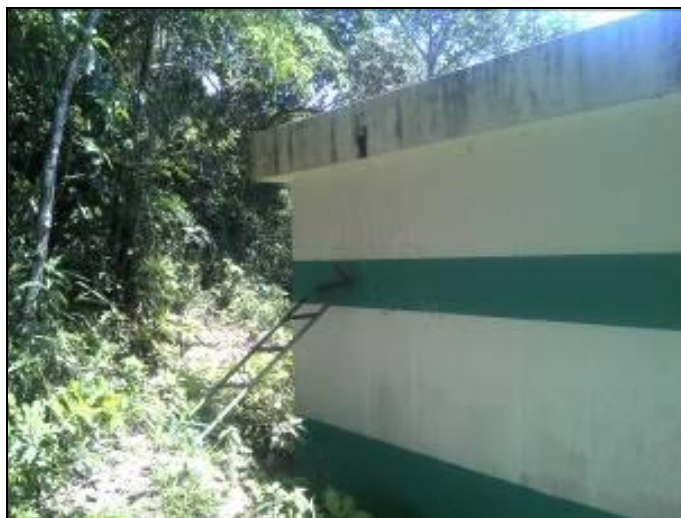
Figura 35: Escada danificada
