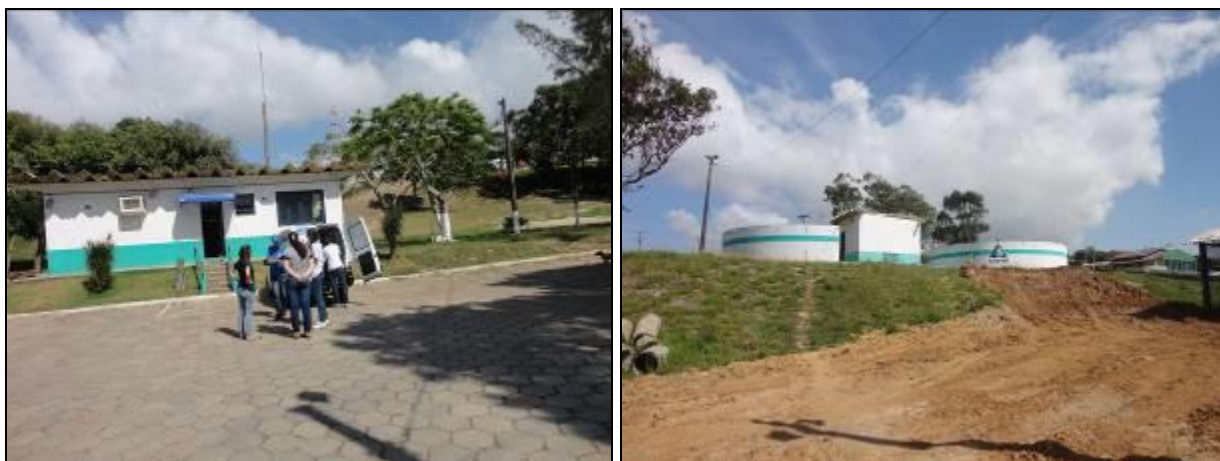
Figura 17: Local do almoxarifado e dos Reservatórios 1 e 2
