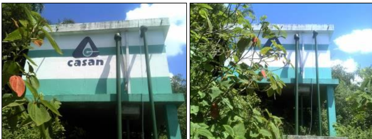
Figura 33: Reservatório Praia do Rosa
