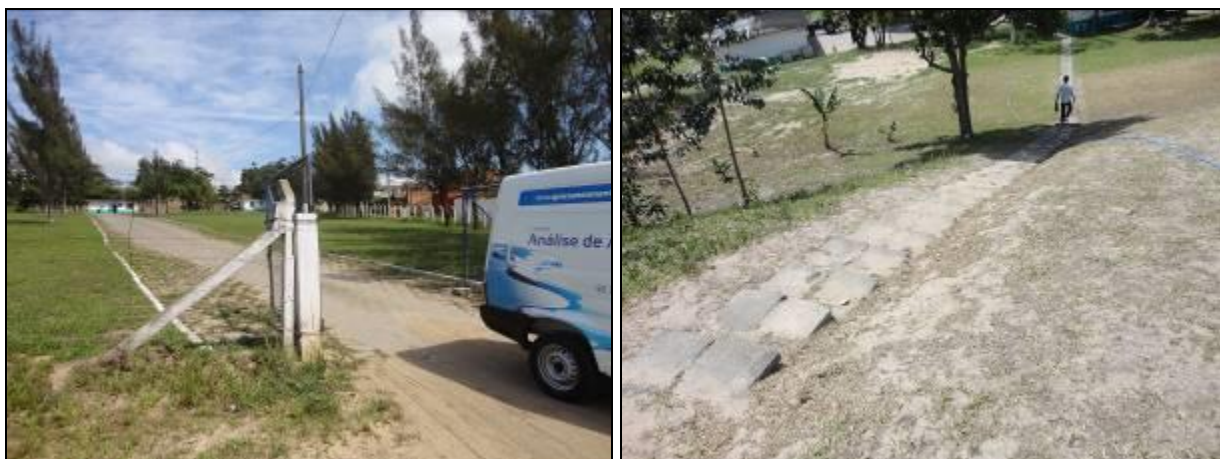
Figura 19: Acesso ao almoxarifado e Reservatórios 1 e 2
