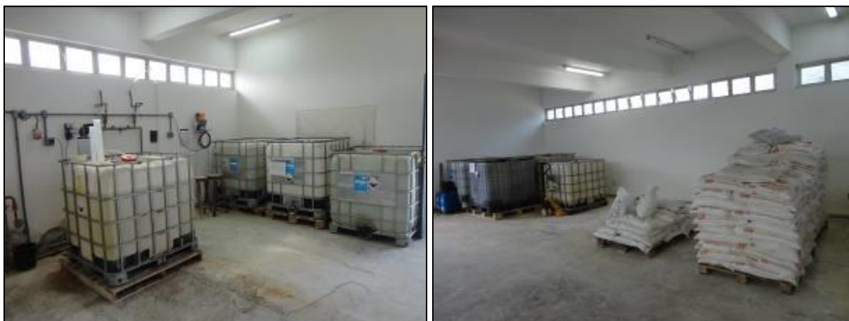
Figura 16: Almojarifado e armazenamento de produtos químicos
