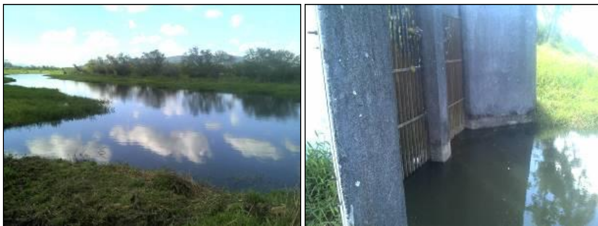
Figura 4: Manancial de captação Rio D'Una
