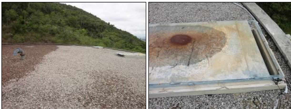
Figura 32: Cobertura do reservatório
