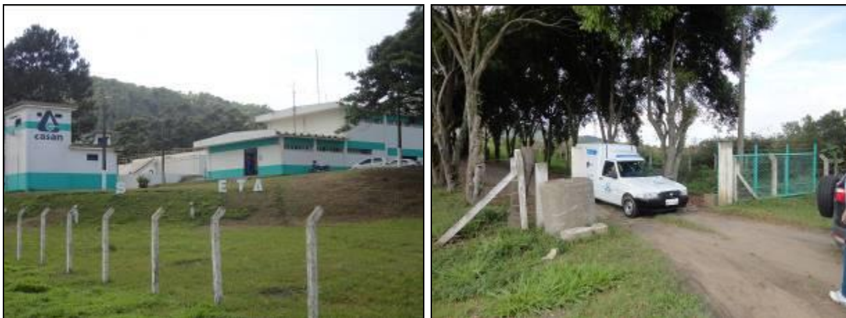
Figura 8: Estrutura física e acesso da ETA
