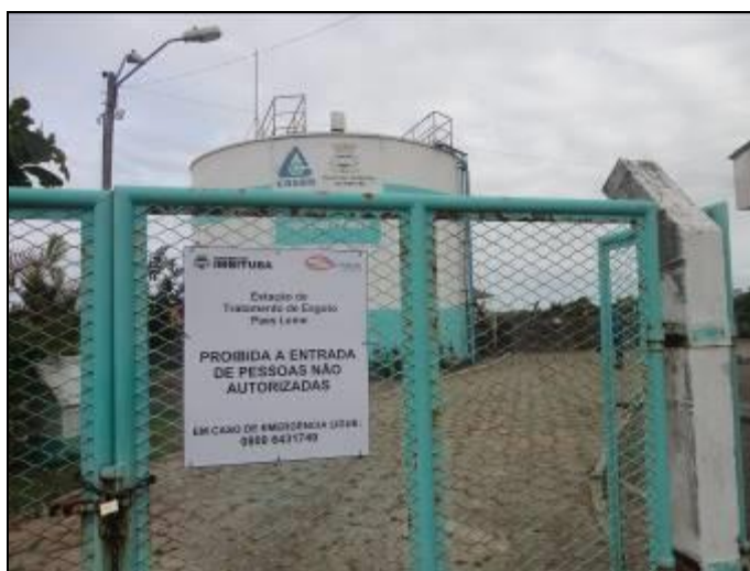
Figura 50: Placa de identificação
