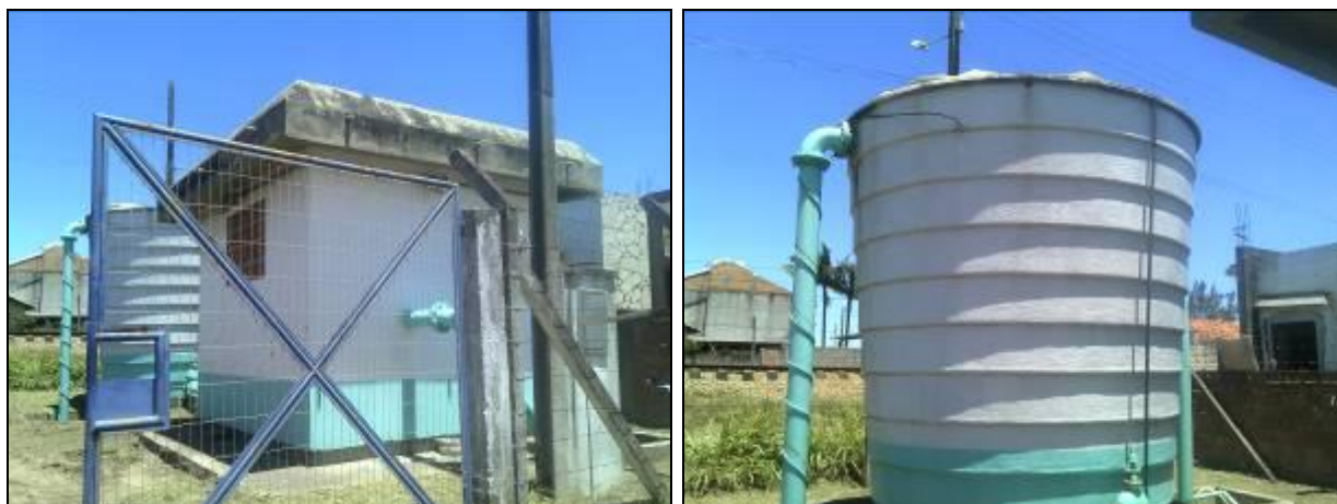
Figura 40: Reservatório Vila Nova
