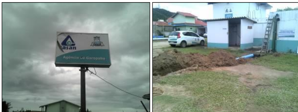
Figura 1: Instalação do recalque na ETA Central
