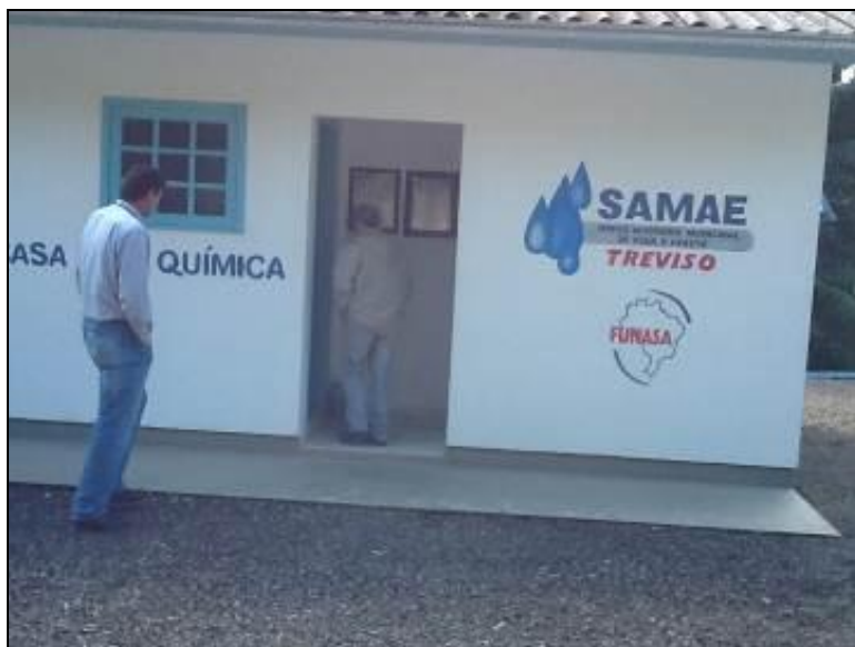
Figura 18: Estrutura da casa de química
