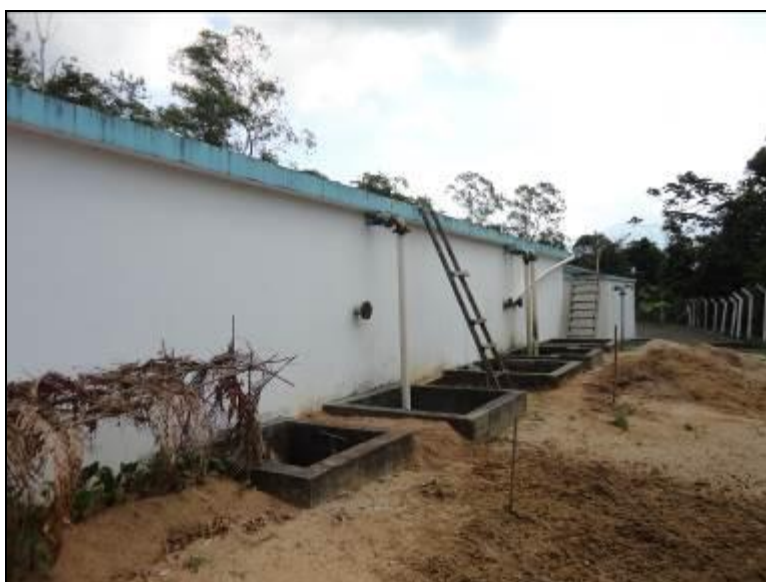
Figura 14: Escada de acesso a ETA
