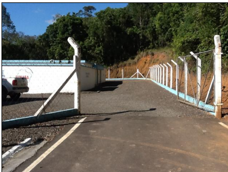
Figura 11: Acesso a ETA
