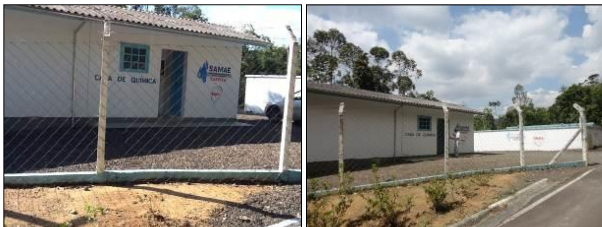
Figura 10: Fachada da ETA (inicial e acompanhamento)
