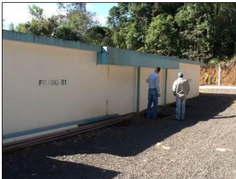
Figura 13: Entorno da ETA.
