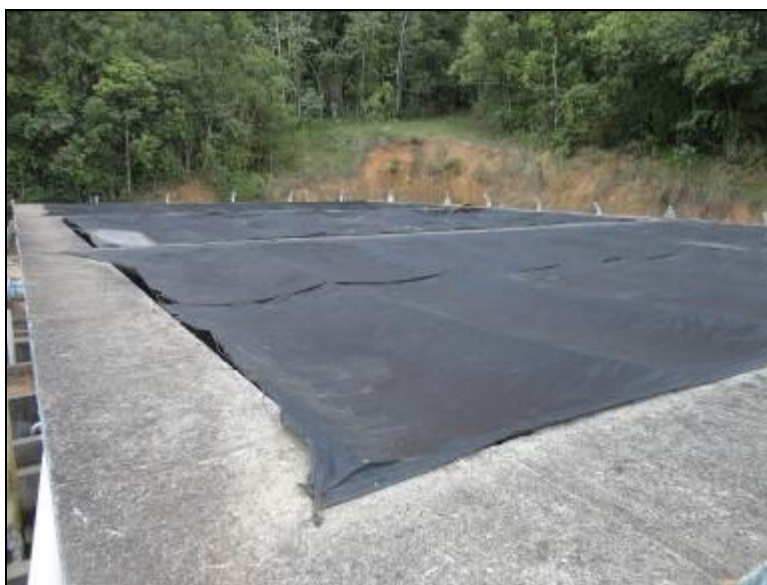
Figura 16: Área coberta dos decantadores.
