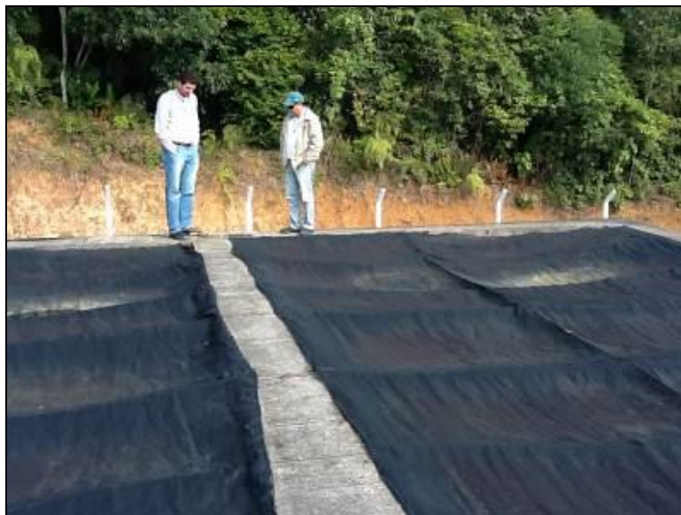
Figura 17: Estrutura de filtragem devidamente cobertas.
