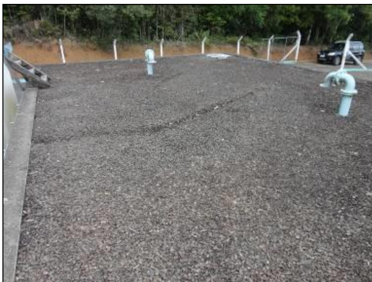
Figura 24: Área coberta do Reservatório (acompanhamento)
