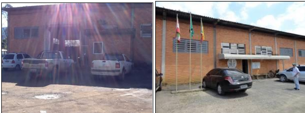
Figura 1: Fachada da Prefeitura (inicial e acompanhamento)
