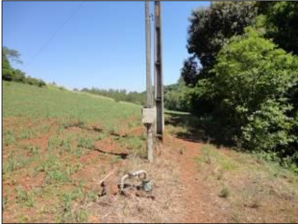
Figura 6: Captação subterrânea à esquerda e superficial com utilização de Caxambu à direita, ambos para o Sistema Isolado da Comunidade de Fátima. (inicial)
