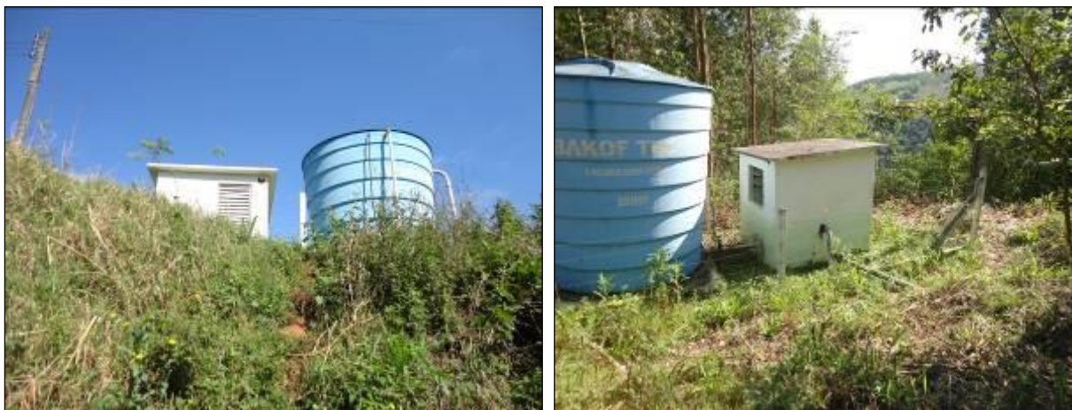
Figura 28: Vista dos ERAT, junto com os Reservatórios. (acompanhamento)
