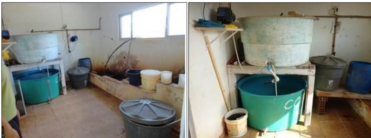
Figura 19: Casa de Química. (inicial e acompanhamento)
