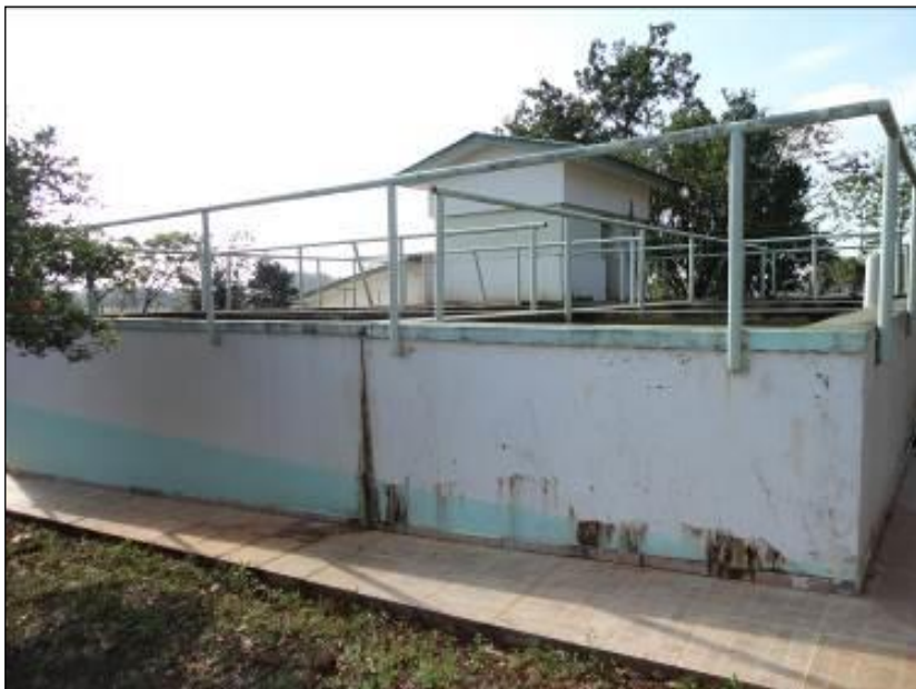
Figura 12: Vista parcial da ETA (acompanhamento)
