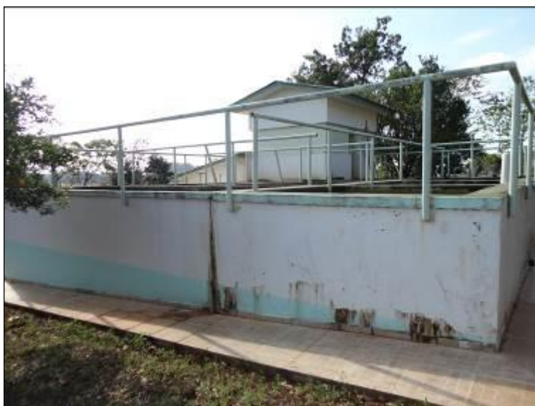
Figura 16: Guarda-Corpo ETA (acompanhamento)
