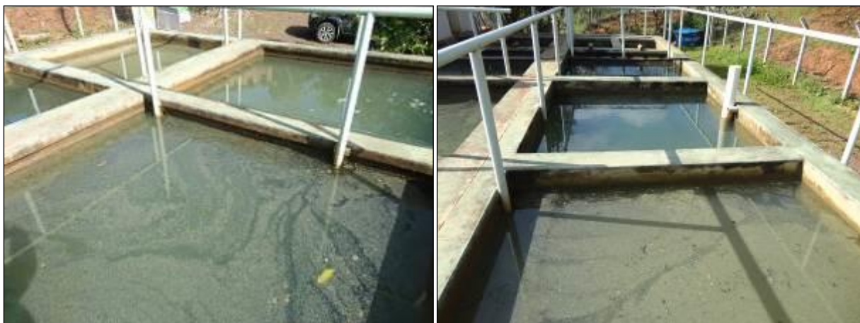
Figura 17: Decantadores ETA (acompanhamento)
