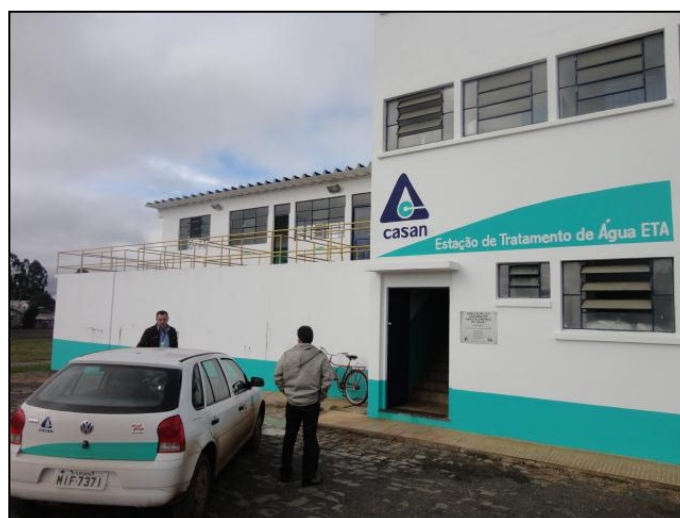
Fachada da ETA
